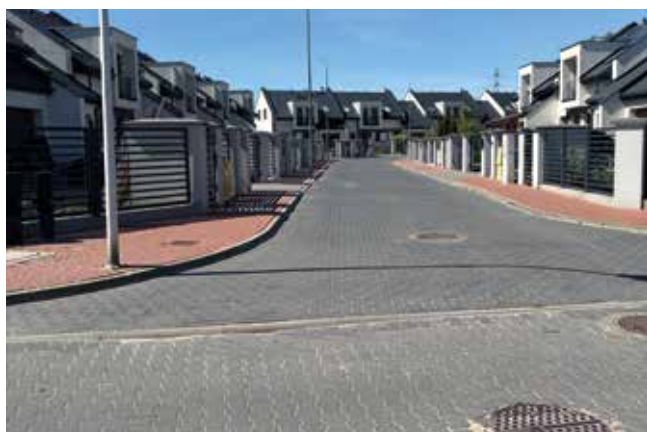
Fot. 1. Przykład całkowitego zabetonowania terenu osiedla
