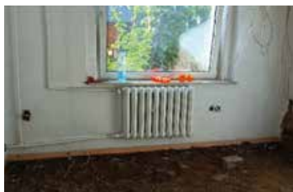
Fot. 1. Widoczne zalanie do ok. 40 cm i termogram obrazujący rzeczywiste nasączenie muru wodą do ok. 120 cm oraz wtórne podciąganie wody powyżej
