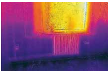
Fot. 1. Widoczne zalanie do ok. 40 cm i termogram obrazujący rzeczywiste nasączenie muru wodą do ok. 120 cm oraz wtórne podciąganie wody powyżej
