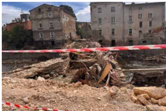
Fot. 4. Uszkodzenia budynków spowodowane powodzią w 2024 r.
