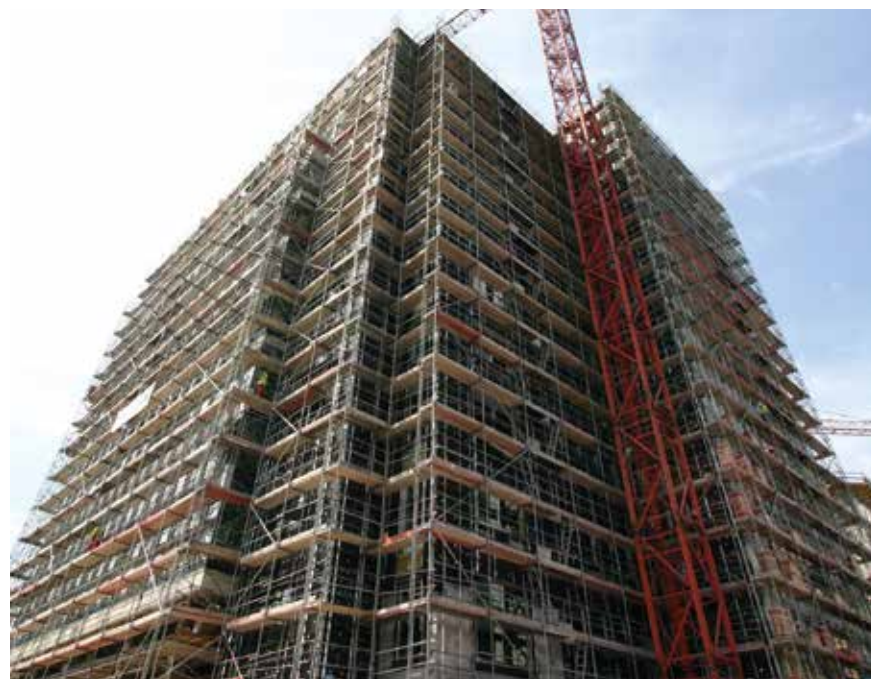
Fot. 1. Przykład konstrukcji rusztowania ramowego
