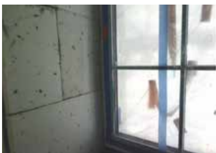
Fot. 16. Widok fragmentu budynku poddanego renowacji do standardu EnerPHit. Ocieplenie gliku wewnętrznego styropianem. „Ciepły” montaż okna (poza murem). Termogram obrazujący właściwą jakość termiczną styku połączenia ramy okna z ościeżnicą
