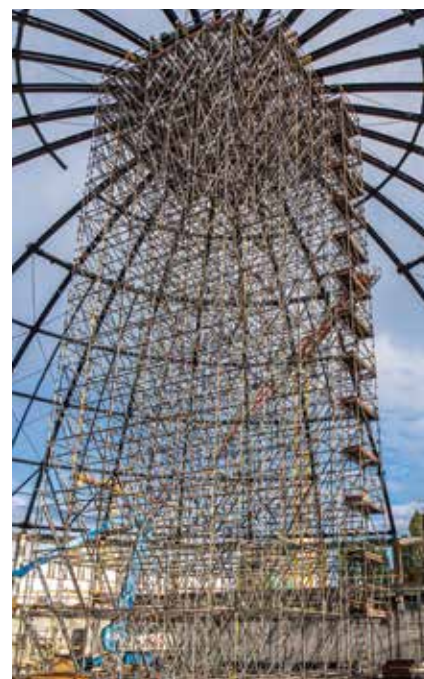
Fot. 2. Przykład konstrukcji rusztowania modułowego
