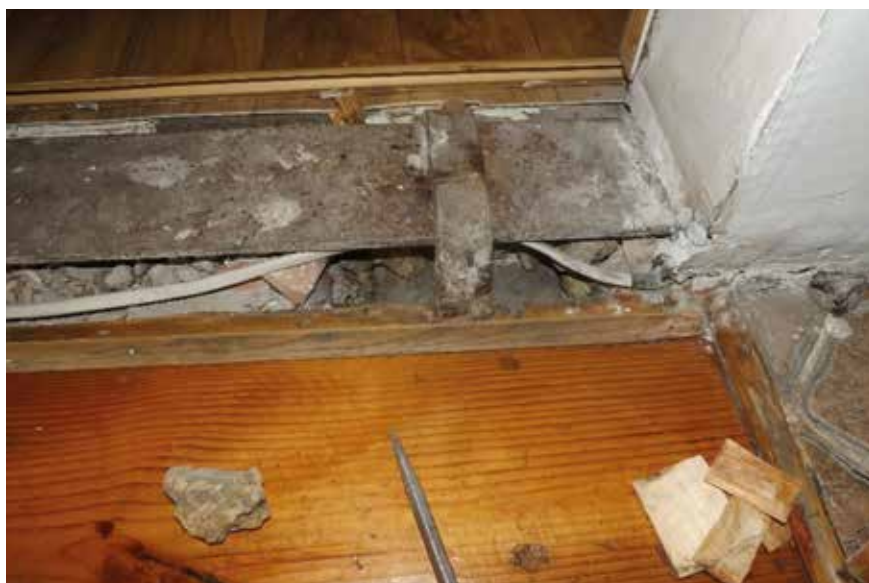
Fot. 1. Dwuteownik wysokości H = 300 mm pod ścianą działową. Do niego przymocowane są płaskowniki mocujące drewniane belki stropowe oparte na tym profilu
