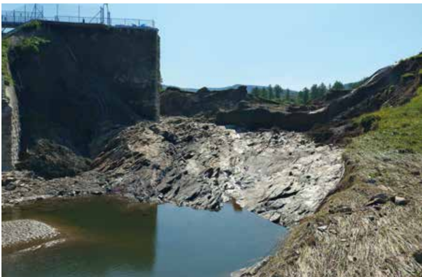
Fot. 4. Zapora suchego zbiornika Stronie Śląskie po katastrofie we wrześniu 2024 r.
