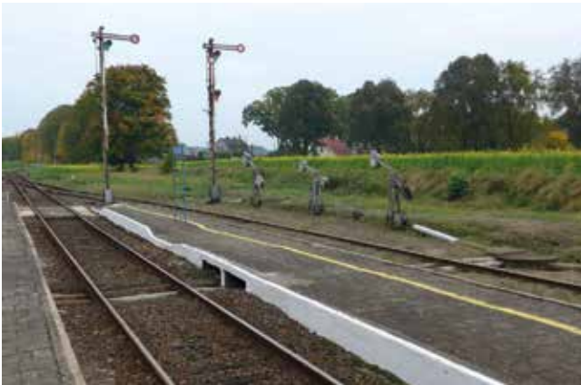
Fot. 3. Urządzenia mechaniczne pędniowe
