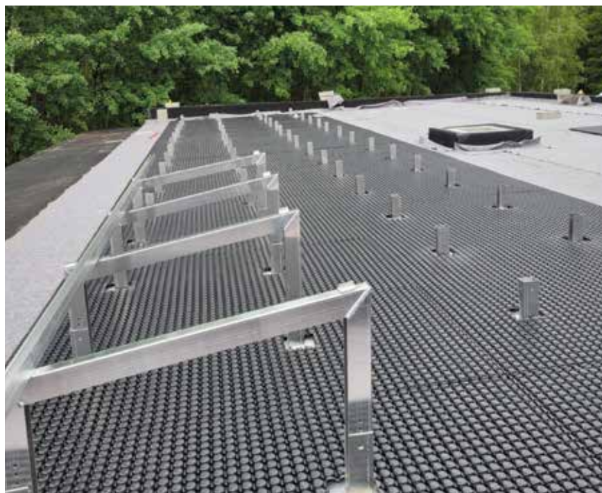
Fot. 4. Ułożenie maty drenazowo-retencyjnej oraz stojaków pod moduły fotowoltaiczne
