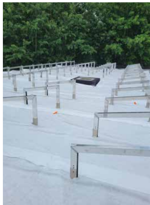
Fot. 5. Pokrycie dachu włókniną filtracyjną
