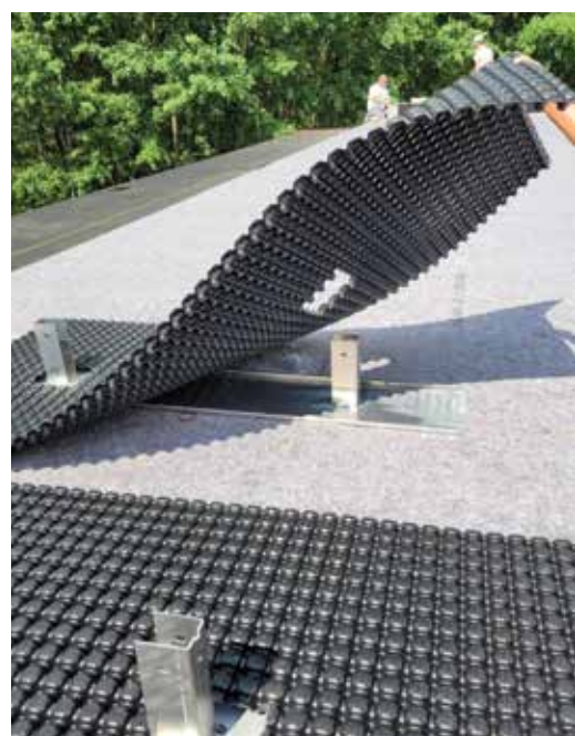
Fot. 3. Układanie włókniny chłonno-ochronnej i płyt bazowych
