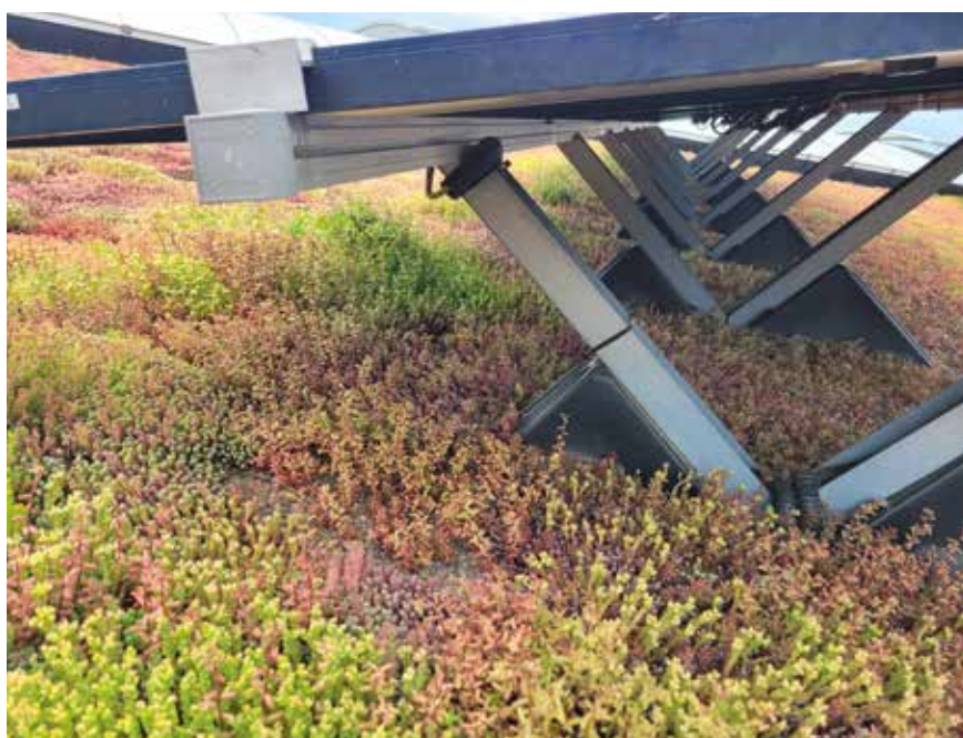
Fot. 2. Rośliny ekstensywne (rozchodniki) na dachu biosolarnym
