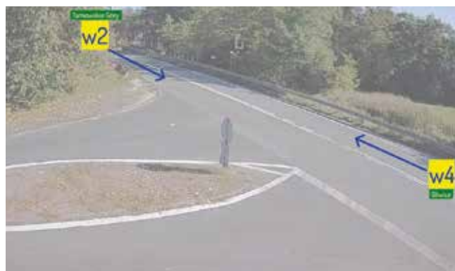
Fot. 4. Widok na skrzyżowanie z kamery umieszczonej na maszcie oświetleniowym
