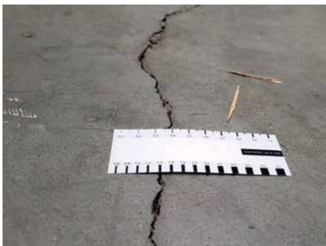
Fot. 8. Wykruszanie krawędzi rys
