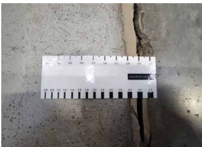
Fot. 10. Szerokość rozwarcia dylatacji roboczej
