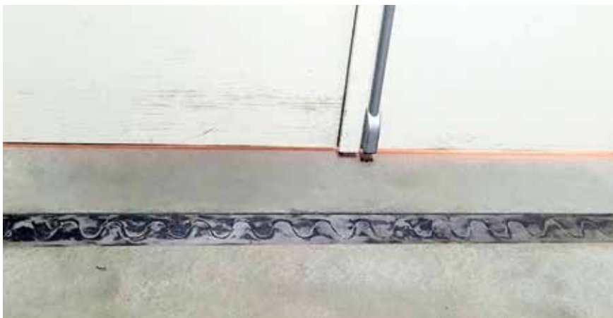
Fot. 14. Przykład zastosowania dylatacji sinusoidalnej
