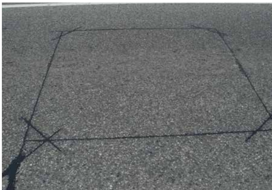
Fot. 1. Miejsce wbudowania pętli indukcyjnej
