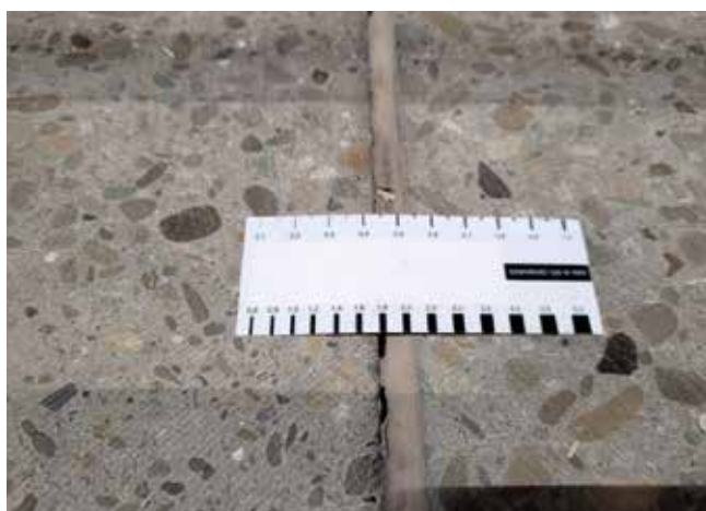
Fot. 11. Szerokość rozwarcia dylatacji skurczowej
