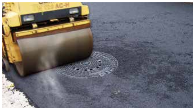
Fot. 6. Przejazd walca po przygotowanym włazie żeliwnym samopoziomującym
