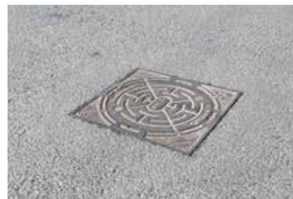
Fot. 5. Osadzony właz żeliwny na studni tworzywowej
