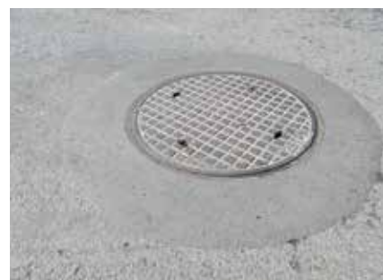
Fot. 4. Właz żeliwny po pracach naprawczych
