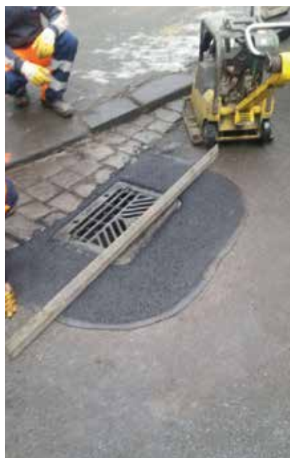
Fot. 3. Prace montażowe samopoziomującego się wpustu deszczowego
