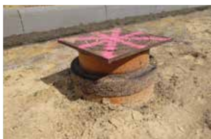
Fot. 7. Wbudowana studnia tworzywowa w korycie jezdni
