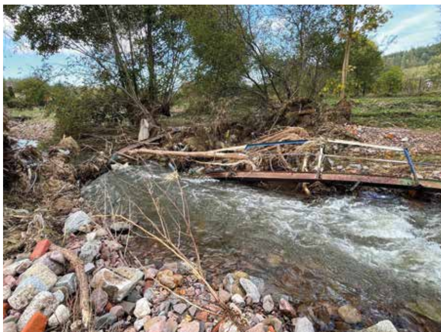
Fot. 4. Skutki powodzi w 2024 r. w gminie Głuszycza – zerwany most dla pieszych nad rzeką Bystrzycą (stalowa konstrukcja zniesiona przez nurt fali powodziowej o ok. 200 m)
