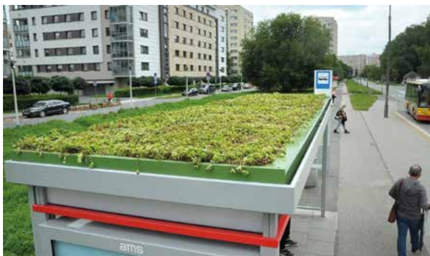
Fot. 2. Dach zielony na wiacie przystankowej w Warszawie [8]
