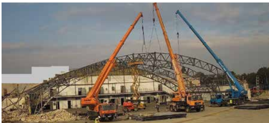
Fot. 5. Demontaż kratownic KR1-6 i KR1-7
