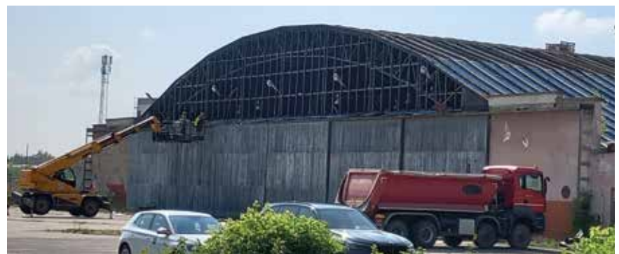
Fot. 1. Widok hangaru od strony wschodniej
