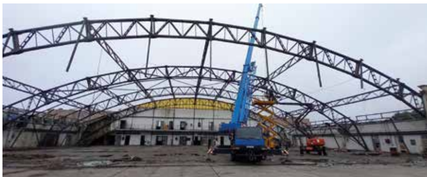
Fot. 4. Demontaż płatwi kratowych
