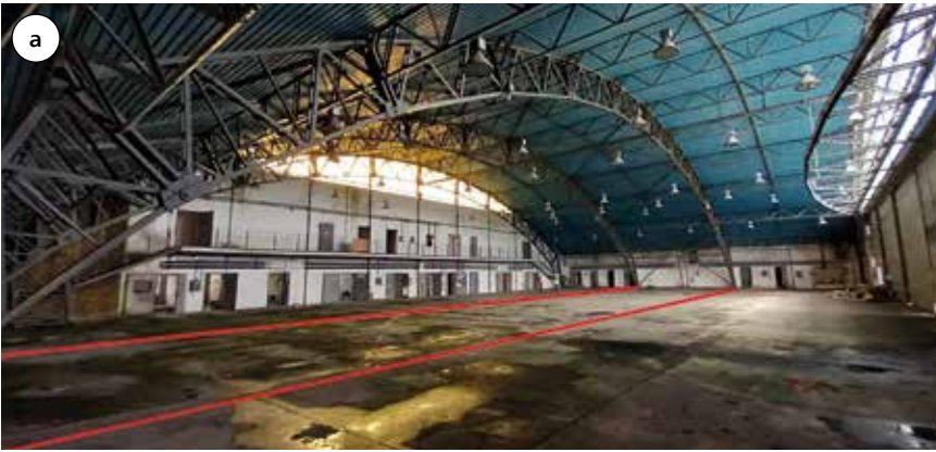
Fot. 2. Przebieg ścigi stalowego w posadzce (czerwona linia) (a), podpora dźwigara łukowego (b)
