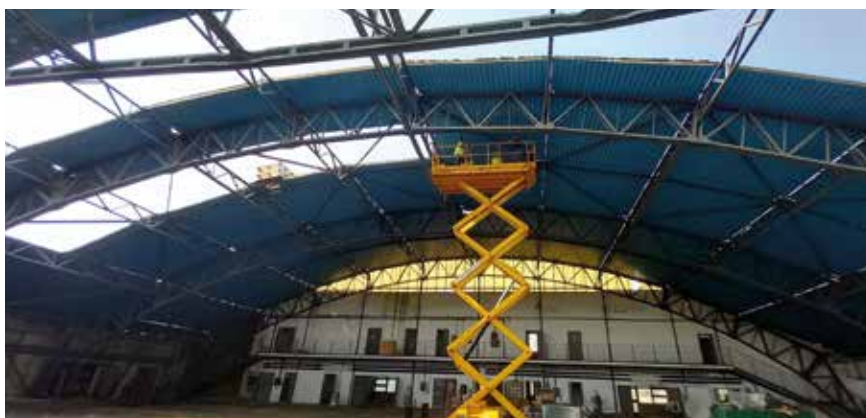
Fot. 3. Demontaż pokrycia z blachy trapezowej
