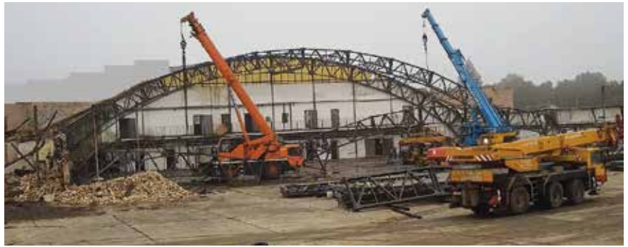
Fot. 7. Demontaż drugiego dźwigara. Obniżenie elementów kratownic KR do poziomu posadzki
