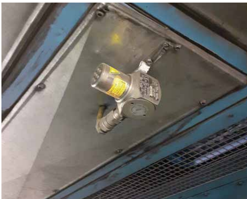
Fot. 2. Detektor stacjonarny, jednogazowy, pracujący w strefie EX, do wykrywania H_2
