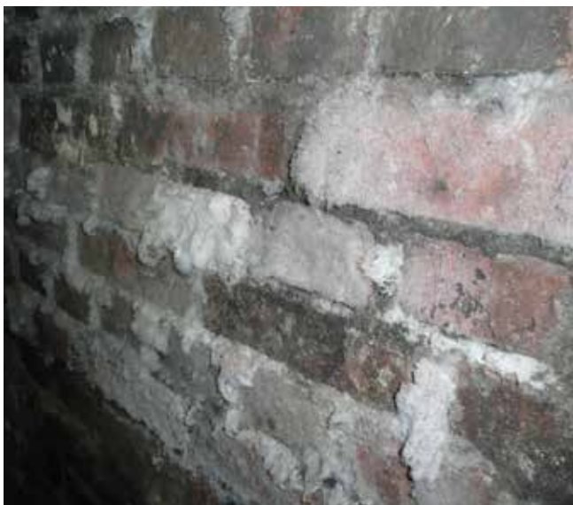
Fot. 1, 2. Obecność skorup solnych świadczy o zaawansowanych procesach destrukcyjnych
