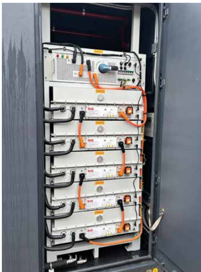
Fot. 3. Pojedyncza sekcja pakietu baterijnego LFP/C, 3,2 V, 280 Ah
