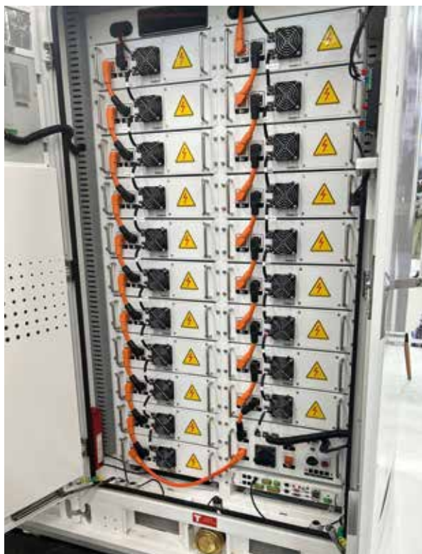
Rys. 7. Kaskadowy stos baterijny z celkami LFP 314Ah
