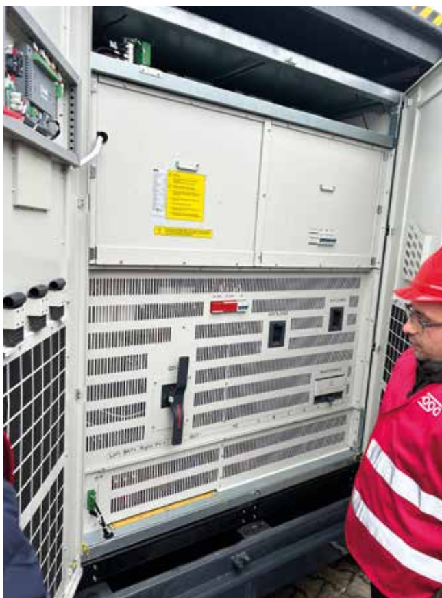
Fot. 5. Centralny przekształtnik DC/AC
