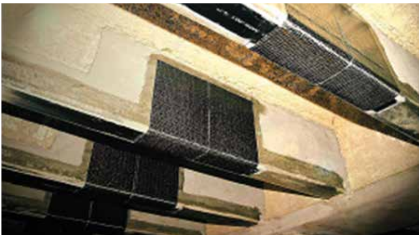
Fot. 2. Wzmocnienie belek zbrojeniem powierzchniowym za pomocą taśm CFRP zakotwionych matą CFRP [4]
