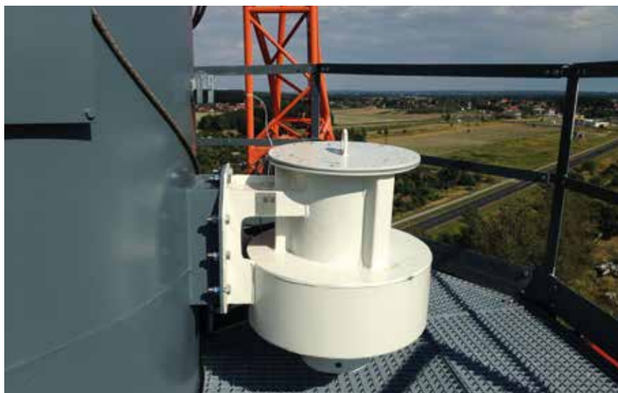
Fot. 1. Przykład zabudowy masowego tłumika drgań na kominie stalowym
