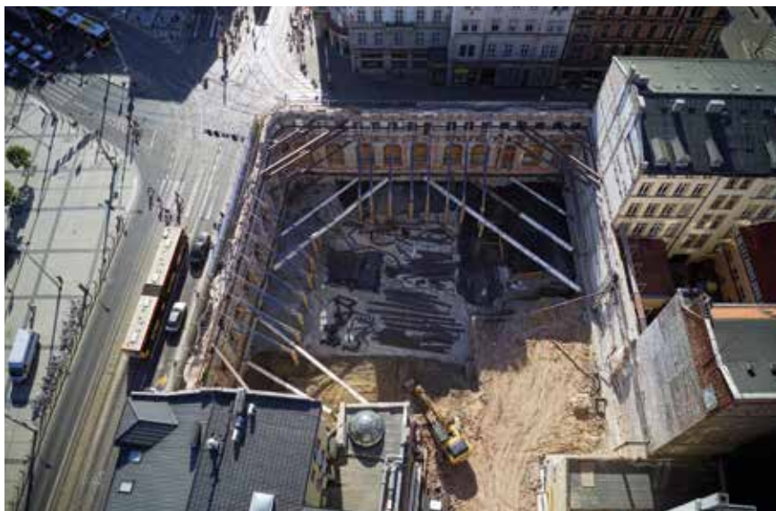
Fot. 1. Prace geotechniczne podczas rewitalizacji Hotelu Grand we Wrocławiu
