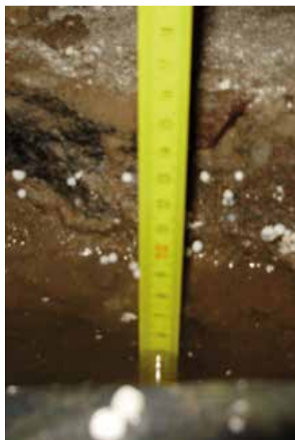
Fot. 6, 7. Zalana piwnica po wykonaniu prac renowacyjnych to często skutek braku analizy warunków gruntowo-wodnych i zaprojektowania izolacji przeciwwilgociowej
