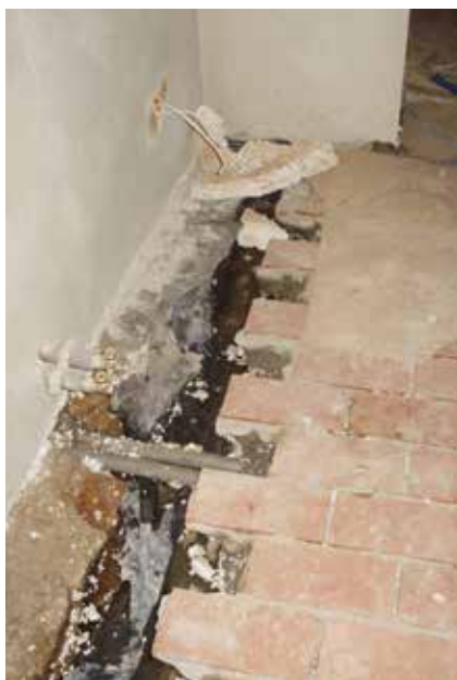
Fot. 6, 7. Zalana piwnica po wykonaniu prac renowacyjnych to często skutek braku analizy warunków gruntowo-wodnych i zaprojektowania izolacji przeciwwilgociowej
