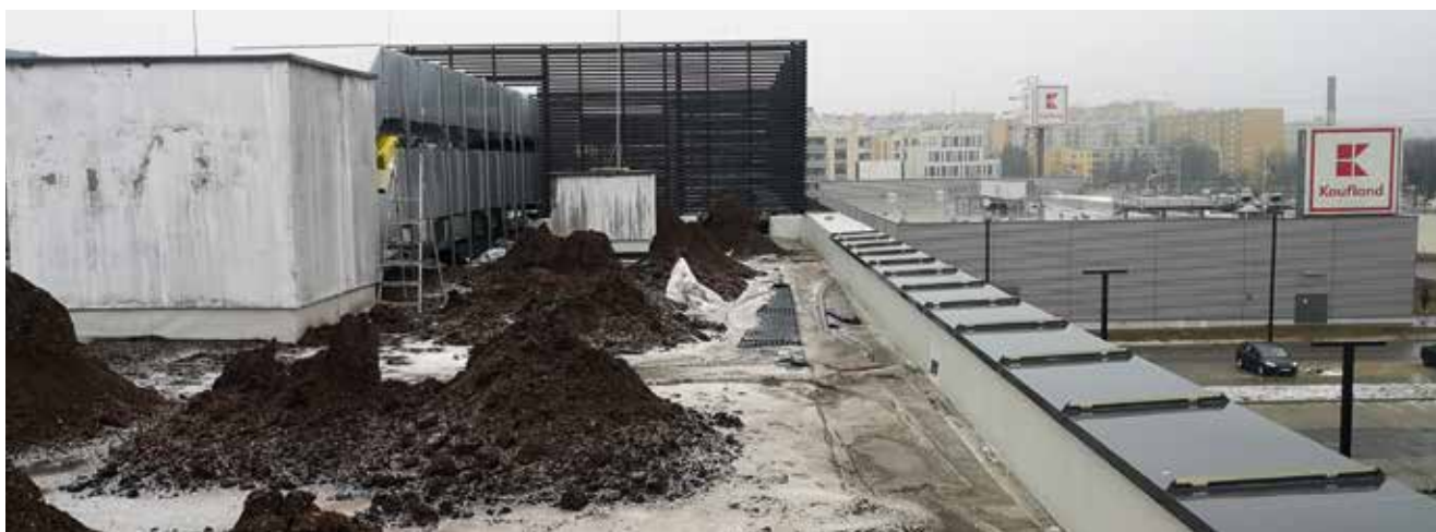
Fot. 3. Instalacja substratu zimą – zamrożony substrat i geowłókniny na dachu
