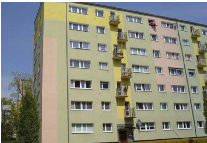
Fot. 4. Widok budynku z bardzo małymi balkonami występującymi powyżej kondygnacji parteru – system PBU, Poznań, 2023 r.
