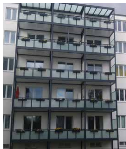
Fot. 5. Widok balkonów o konstrukcji dostawnej do budynku [6]
