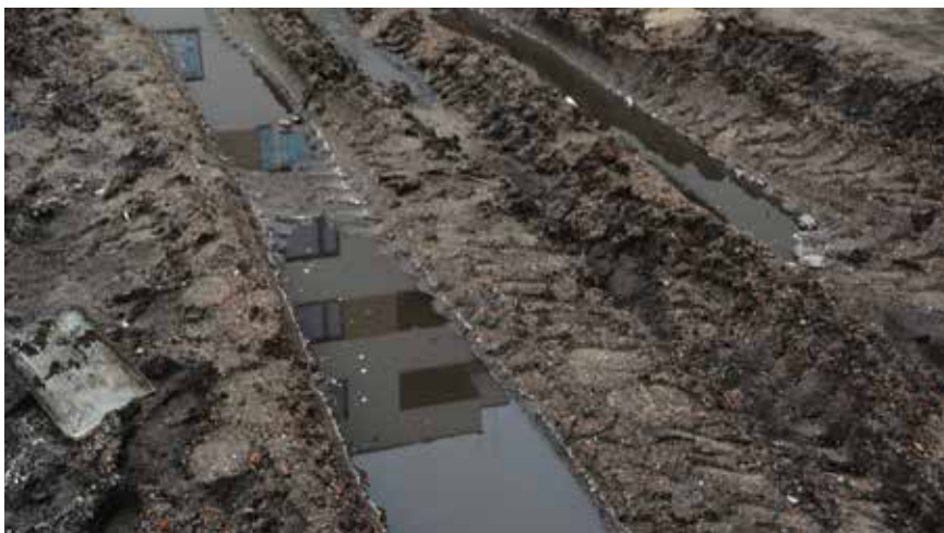
Fot. 4. Kolejny po kołach ładowarki – nieprawidłowa instalacja substratu
