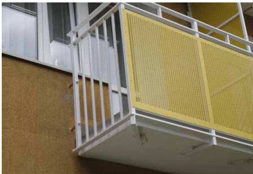
Fot. 7. Balkon niewielkich rozmiarów po wykonanym remoncie. Widoczna nowa balustrada zamocowana do spodu płyty balkonowej – system Winogrady, Poznań, 2022 r.
