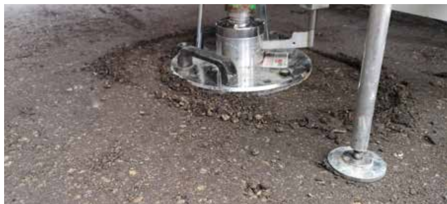
Fot. 2. Badanie zagęszczenia specjalnego substratu przeznaczonego na drogi pożarowe na dachach zielonych
