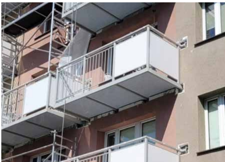
Fot. 6. Widok balkonów podwieszanych do budynku [7]
