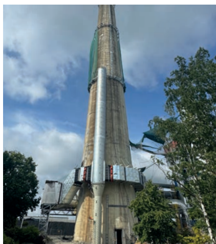
Przebudowa i modernizacja komina przemysłowego w EC Polkowice
