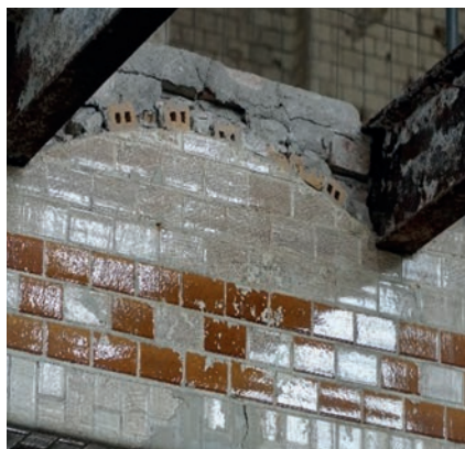
Fot. 2. Strop rozebrany – widoczny zarys łuku z kształtek ceramicznych
