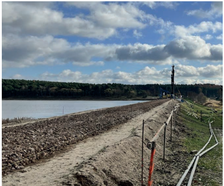
Fot. 6. Platforma robocza na koronie zapory czołowej
