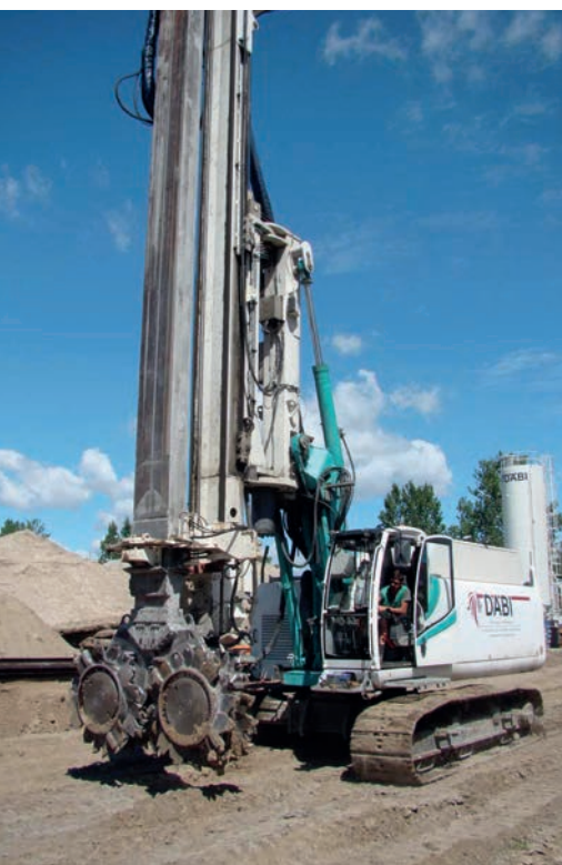
Fot. 2. Technologia CSM do realizacji przesłon przeciwfiltracyjnych
