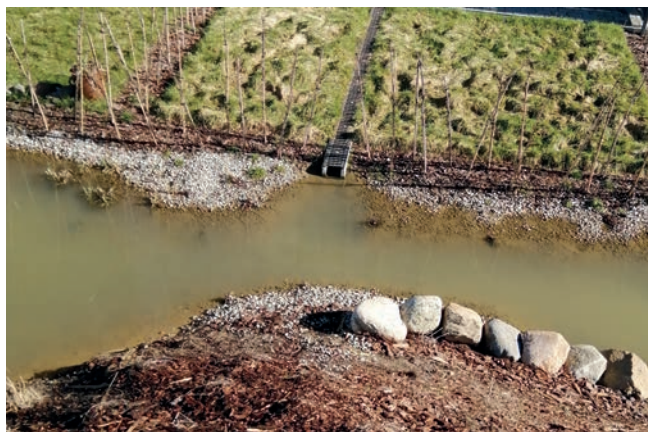
Fot. 3. Skutki nieefektywnego odprowadzenia wód opadowych
