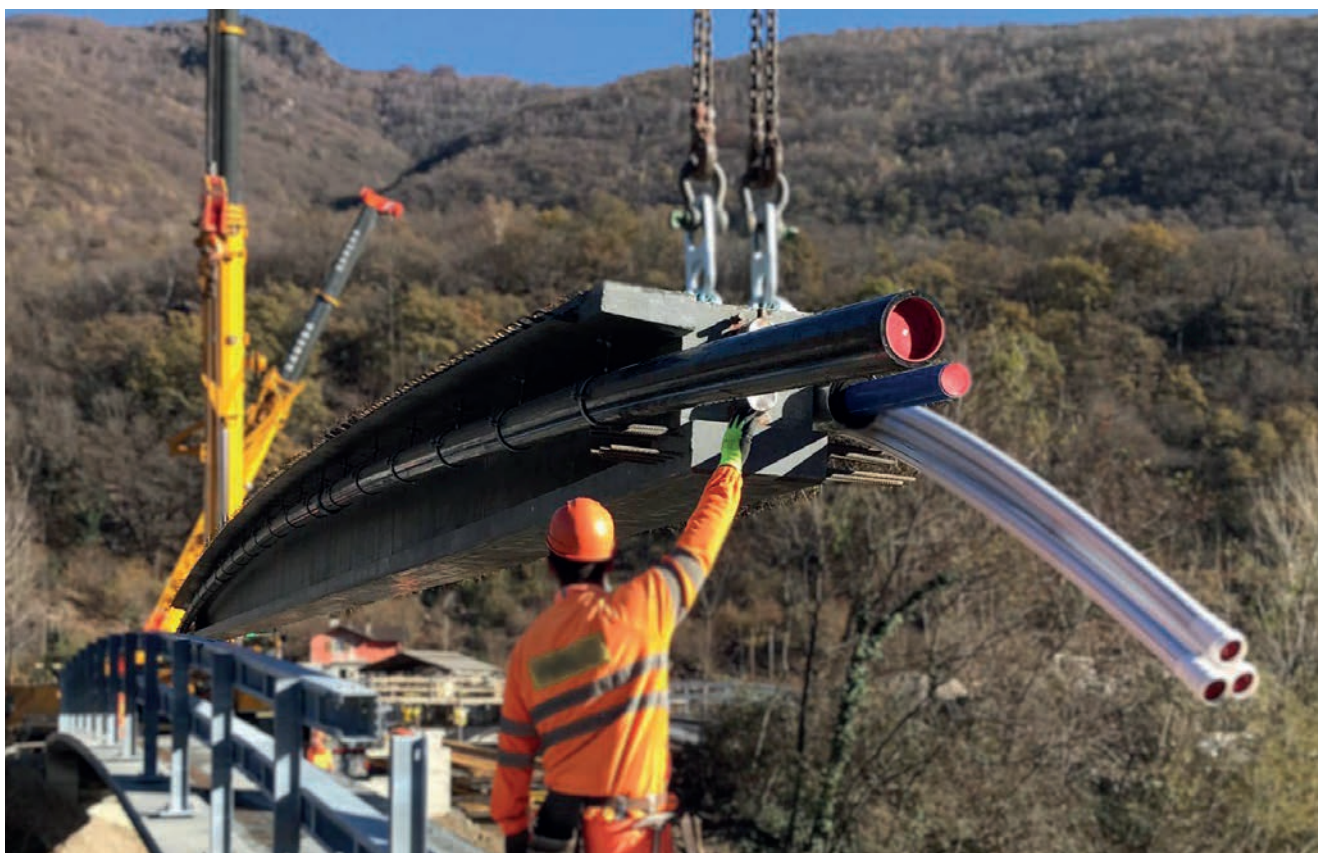
Fot. 1. Przykład asymetrycznego, dwuteowego, prefabrykowanego dźwigara mostowego z UHPFRC zaprojektowanego wg SIA 2052
