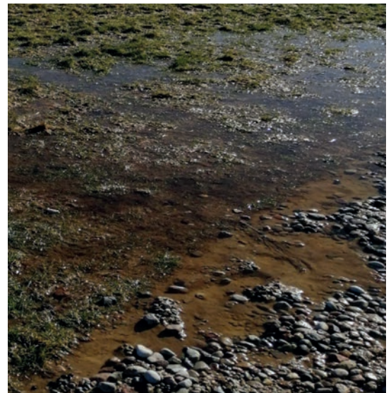
Fot. 4. Woda opadowa długotrwale pozostająca na powierzchni terenu
