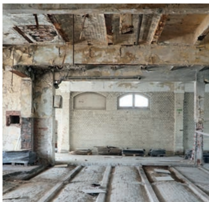
Fot. 1. Oczyszczony strop „Mamuta” i przygotowany do wykonania wzmocnienia
