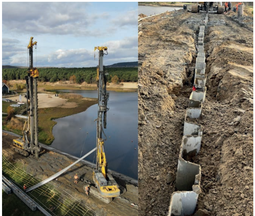
Fot. 7. Realizacja przesłony w technologii HPP
