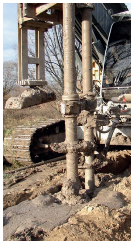
Fot. 1. Technologia DSM do realizacji przesłon przeciwfiltracyjnych
