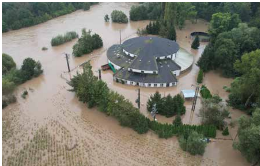
Fot. 1. Miejska Oczyszczalnia Ścieków w Paczkowie, powiat Nysa, woj. opolskie, w okresie przejścia fali powodziowej
