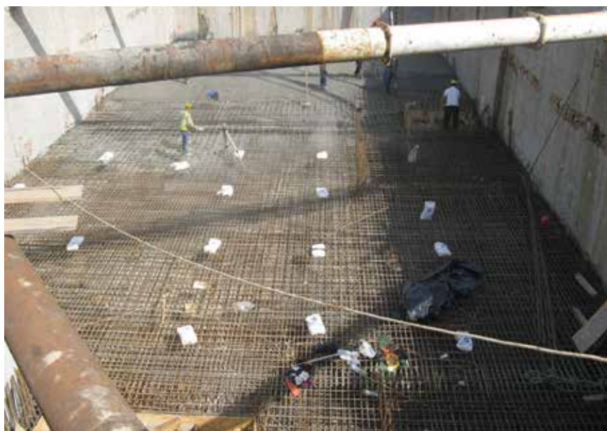
Fot. 1. Płyta parkingu podziemnego w trudnych warunkach wodno-gruntowych. Widoczne nanoszenie Hydrostopu-Mieszanki prowadzone równocześnie z betonowaniem płyty
