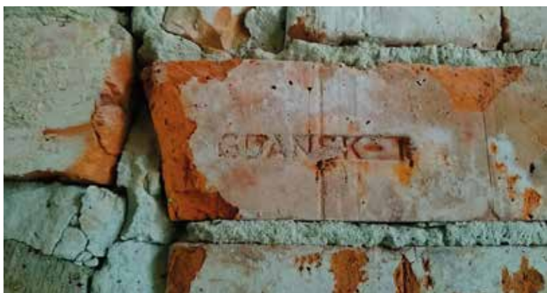
Fot. 11. Historyczne cegły w ścianach budynku przy ul. Na Stoku 35
