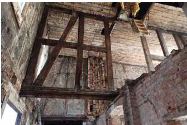
Fot. 5. Fragment starej ściany budynku przy ul. Na Stoku 12B
