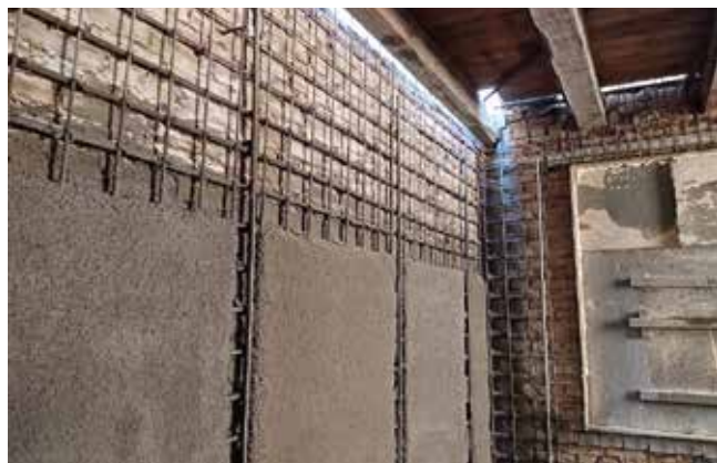
Fot. 8. Torkretowanie ścian budynku przy ul. Biskupiej 17
