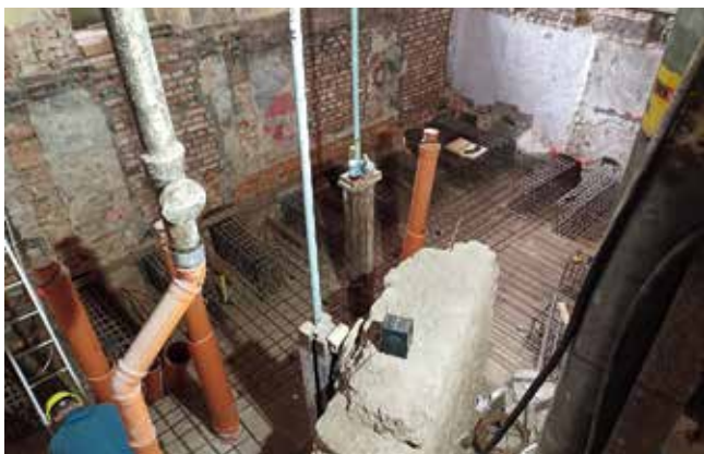
Fot. 3. Wzmocnienie fundamentu budynku przy ul. Biskupiej 27
