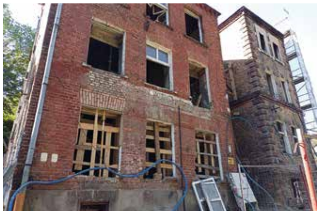
Fot. 1. Budynek mieszkalny przy ul. Na Stoku 25 w trakcie rewitalizacji
