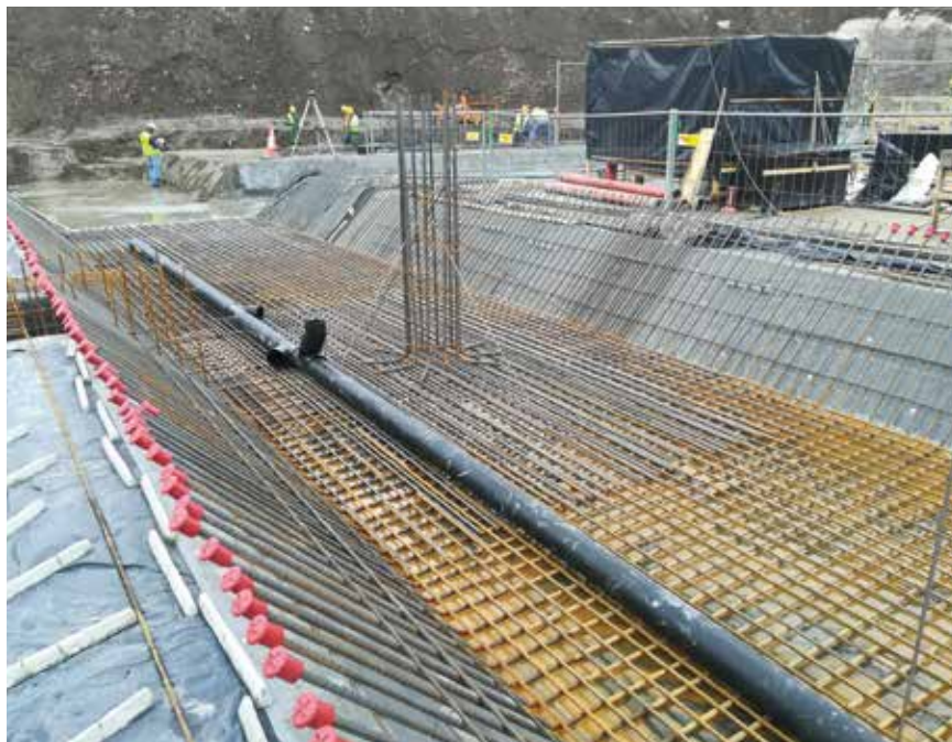
Fot. 2. Przegłębienie w płycie fundamentowej. Widoczna Hydrostop-Mata Penetrująca
