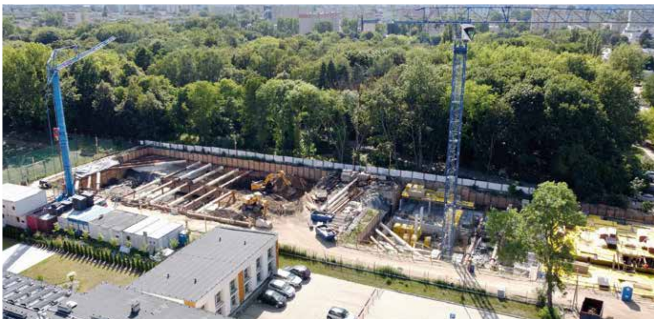
Fot. 3. Budowa zespołu budynków wielorodzinnych w mieście Łódź. Izolacja płyty – Hydrostop-Mieszanka 203 na powierzchni ok. 3600 m 2
