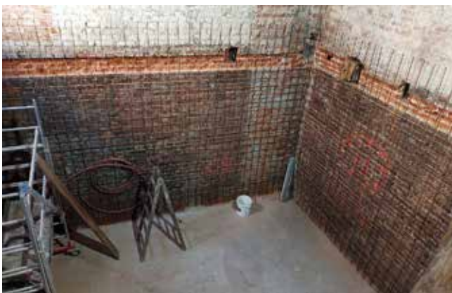
Fot. 7. Wzmocnienie ścian piwnic budynku przy ul. Biskupiej 8A
