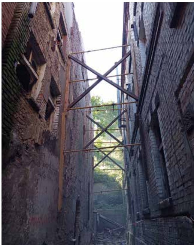
Fot. 9. Budynki mieszkalne przy ul. Na Stoku 25 i 23 w trakcie rewitalizacji
