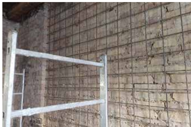
Fot. 6. Wzmocnienie ścian budynku przy ul. Biskupiej 17
