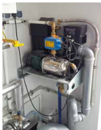
Fot. 4–6. Przykład prawidłowo wykonanej wewnętrznej dualnej instalacji wody deszczowej
