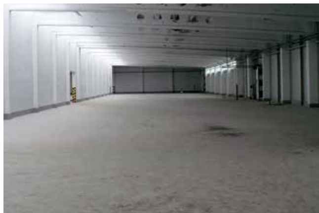
Fot. 7. Przykład silnie zanieczyszczonej posadzki
