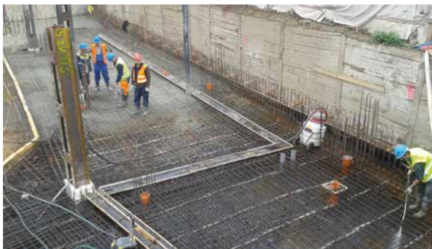
Fot. 2. Przygotowanie stropu rozpięającego
