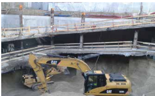
Fot. 3. Strop rozpięający, I etap wykopu
