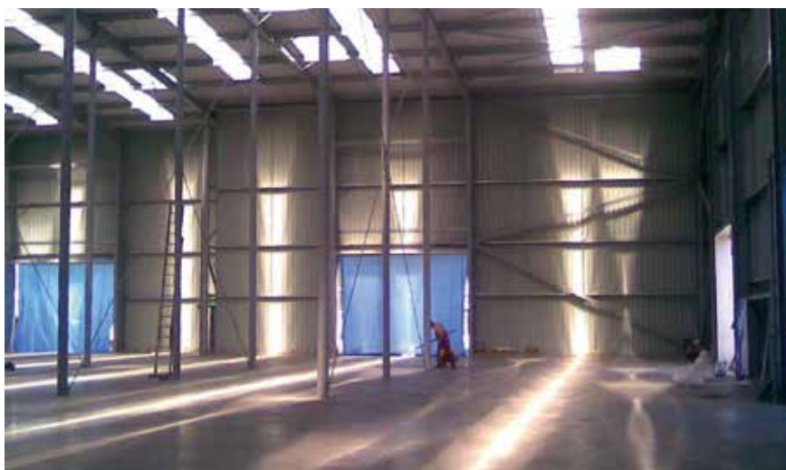
Fot. 5. Zabezpieczenie obiektu w okresie dojrzewania posadzki
