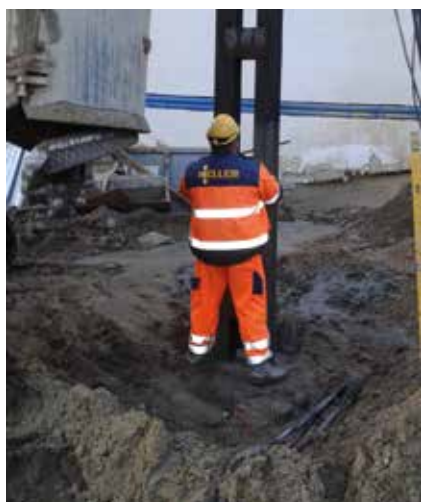
Fot. 1. Pograżanie słupów tymczasowych
