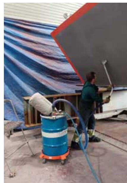
Fot. 6. Proces zdejmowania z powłoki etylokrzemianowej wysokocynkowej suchego natrysku
