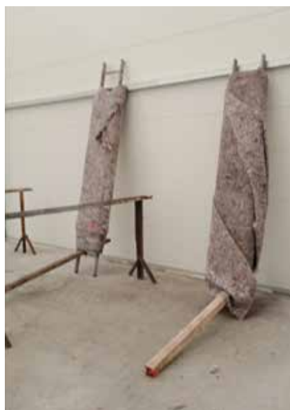
Fot. 5. Osłony pozwalające utrzymać właściwą wilgotność powietrza przy nakładaniu powłok etylokrzemianowych wysokocynkowych
