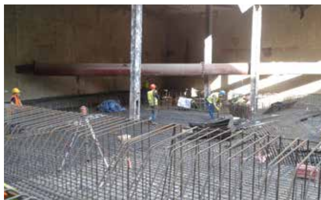
Fot. 4. Płyta fundamentowa w trakcie robót zbrojarskich
