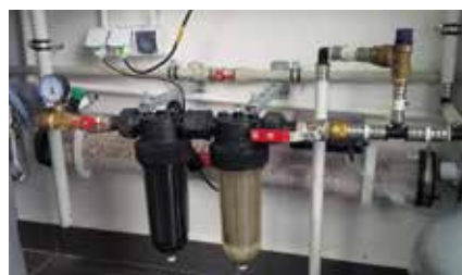
Fot. 4–6. Przykład prawidłowo wykonanej wewnętrznej dualnej instalacji wody deszczowej
