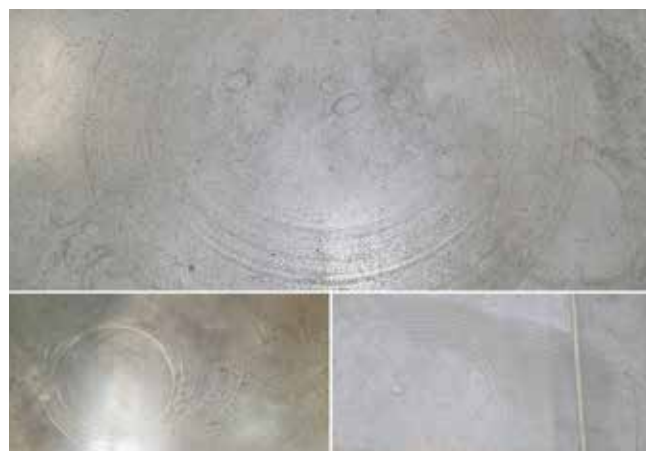
Fot. 15. Rezultaty nieodpowiedniego czyszczenia podłogi
