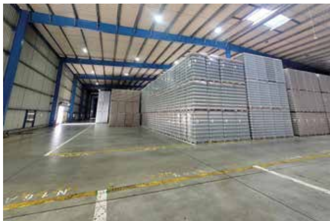
Fot. 1. Podłoga w technologii DST użytkowana nieprzerwanie przez ponad 25 lat
