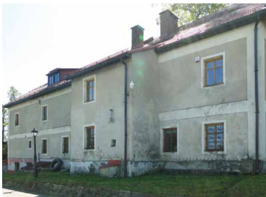
Fot. 1. Widok budynku od strony północnej
