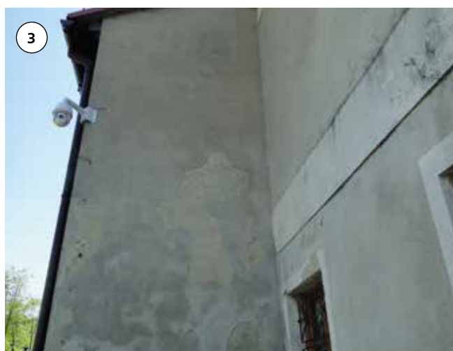
Fot. 3–4. Przebarwienia i odspojenia tynku na ścianie północnej
