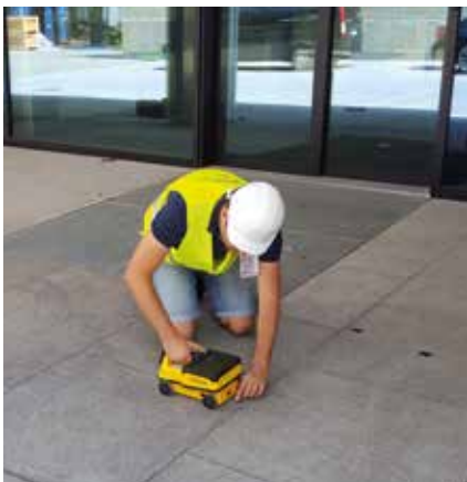
Fot. 1. Skanowanie georadarem zbrojenia w posadzce pod montaż bramek radiometrycznych na lotnisku Balice w Krakowie [5]
