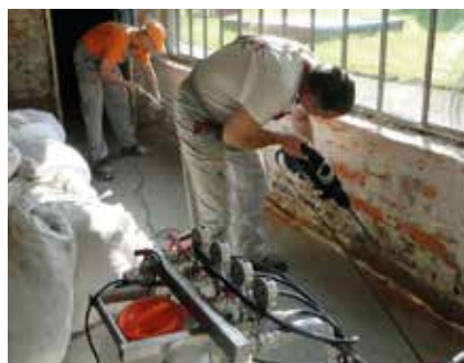
Fot. 5. Wykonywanie otworów iniekcyjnych
