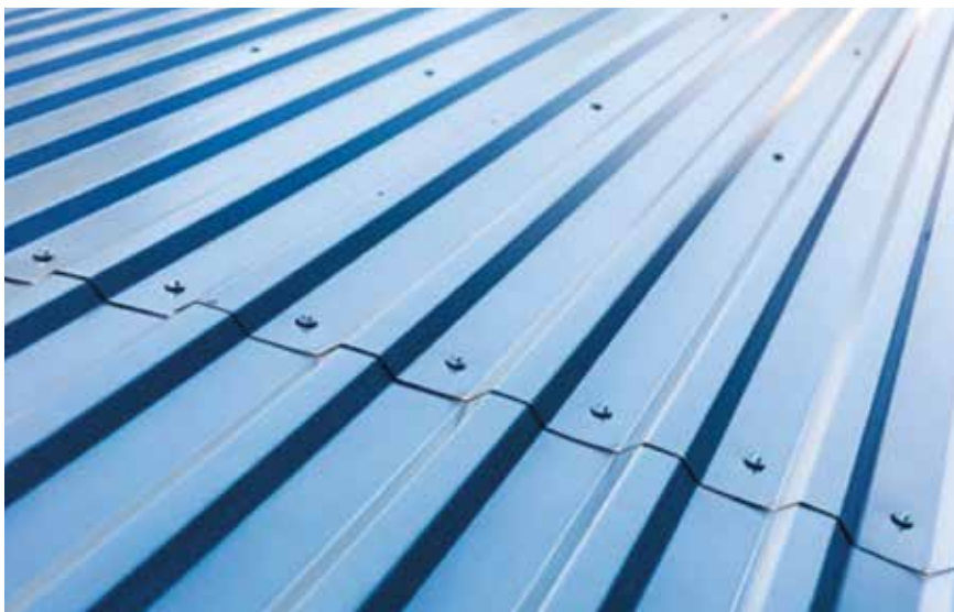
Fot. 3. Łączenie blach profilowanych za pomocą nitów [6]
