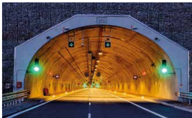
Fot. 2. Tunel TS-23 w ciągu drogi S-3 na odcinku pomiędzy Bolkowem a Kamienną Górą
