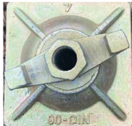
Fot. 4. Nakrętka ściągu z widocznym oznaczeniem klasy nośności zgodnie z DIN 18216
