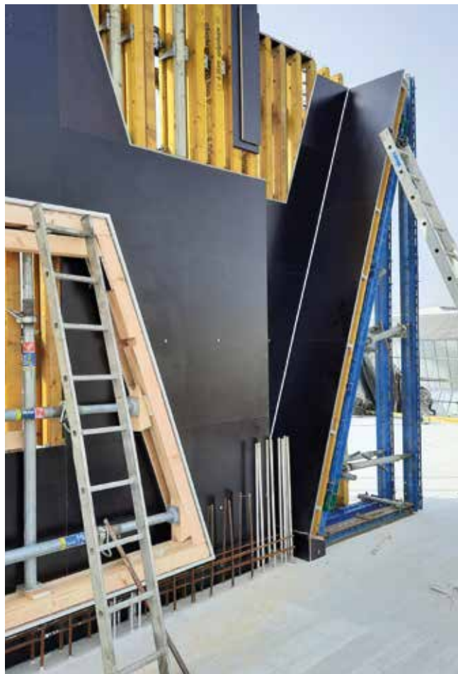
Fot. 2. Na budowie prefabrykowane panele trafiają bezpośrednio do systemów szalunkowych Doki. Precyzyjne dopasowanie elementów umożliwia minimalizację czasu montażu, ułatwia realizację skomplikowanych kształtów konstrukcji żelbetowych i gwarantuje jakość powierzchni betonu po rozszalowaniu
