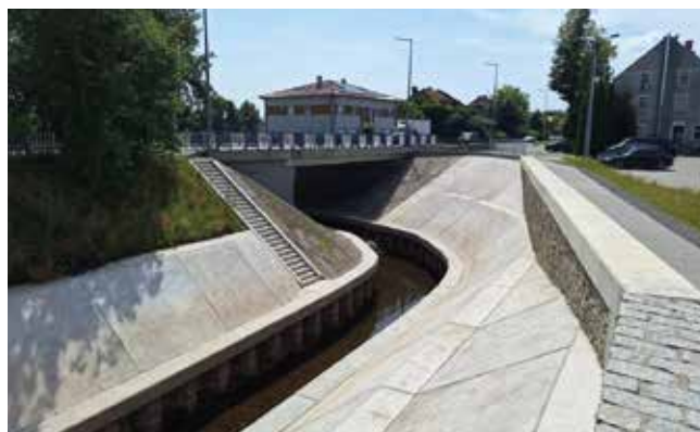
Fot. 3. Zabezpieczenie przed powodzią miasta Krosno Odrzańskie
