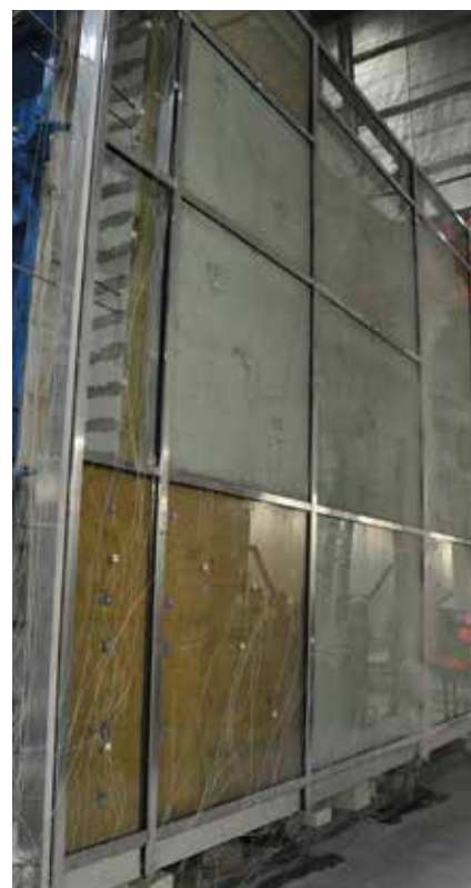
Fot. 3. Widok nienagrzewanej powierzchni elementu próbnego przeszklonej ściany osłonowej podczas badania w zakresie odporności ogniowej, w przypadku nagrzewania od wewnątrz
