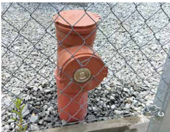
Fot. 5. Tuba z kluczami ułatwiająca wejście osób upoważnionych na teren stacji
