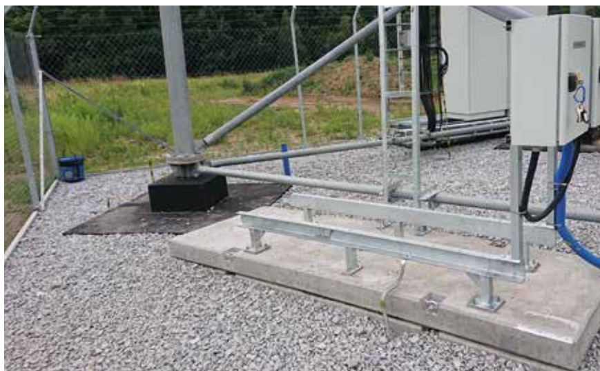
Fot. 2. Warstwa grys przy obiekcie zmniejszająca porost roślin
