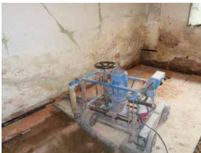
Fot. 2. Podcinanie muru piłą łańcuchową
