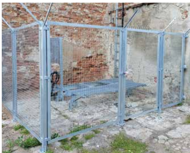
Fot. 3. Ogrodzenie terenu zapobiegające wejściu na teren stacji
