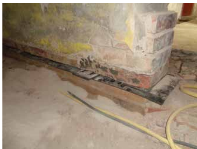
Fot. 3. Membrana hydroizolacyjna umieszczona w nacięciu muru
