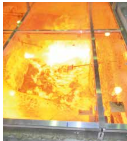
Fot. 6. Widok nienagrzewanej powierzchni dachu przeszklonego podczas badania w zakresie odporności ogniowej
