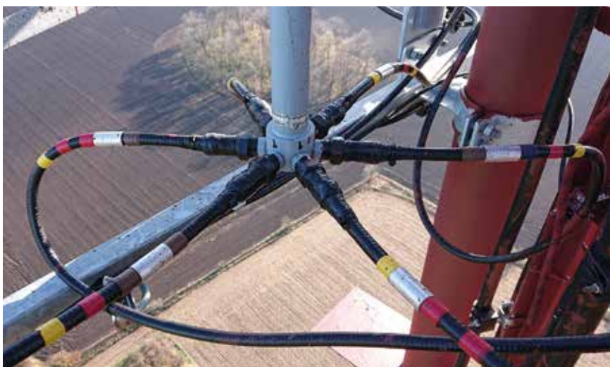
Fot. 13. W sytuacji, gdy dzielnik ma niekorzystne położenie, odpowiednia izolacja złączy zapobiega awariom
