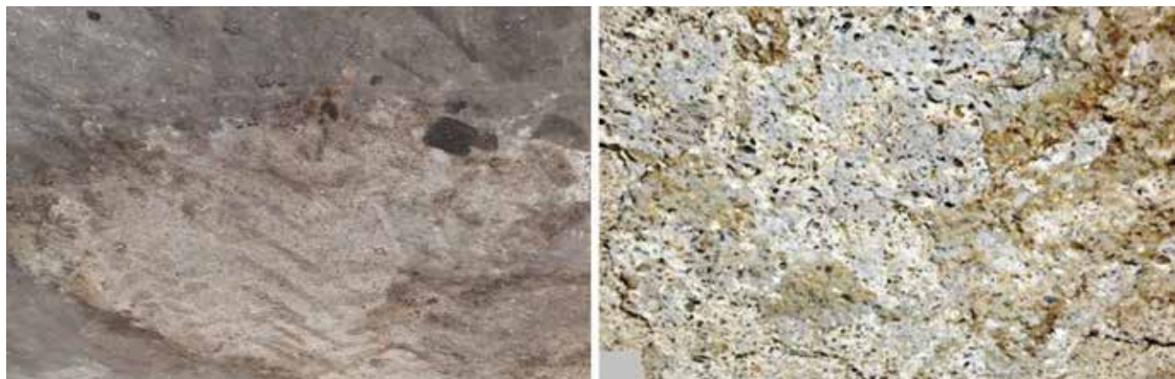
Fot. 1. Przykłady występowania uszkodzeń wywołanych obciążeniami chemicznymi
