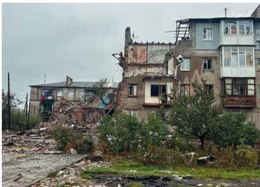
Fot. 2. Obiekt mieszkalny w Łymanie w Ukrainie zniszczony na skutek uderzenia raketowego
