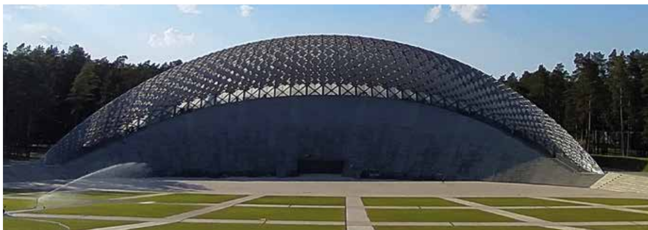
Fot. 2. Stalowa konstrukcja plenerowej sceny w Mežaparks ma 38,5 m wysokości
