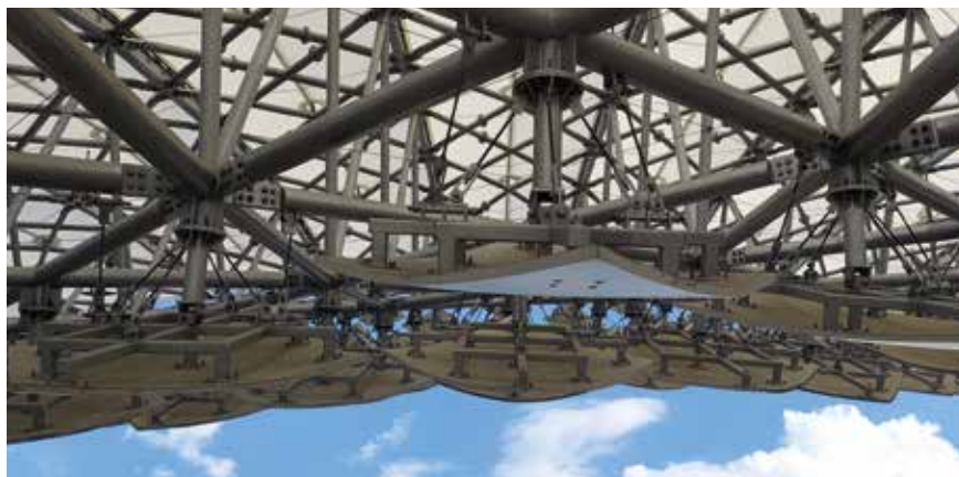
Fot. 1. Dobrą słyszalność na całej widowni zapewnia 510 ekranów akustycznych mocowanych do konstrukcji
