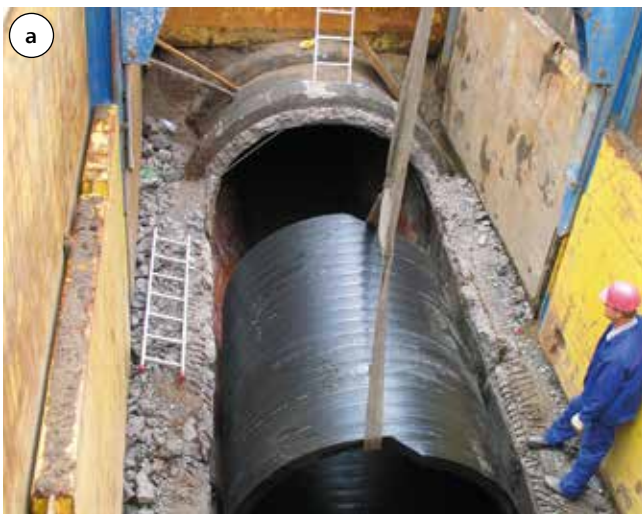
Fot. 4. Przykładowe renowacje metodą reliningu krótkiego, z wykonaniem wykopu startowego i rozburzeniem fragmentu istniejącego rurociągu (a) oraz bez wykopu startowego – tu moduły podawane przez studzienkę kanalizacyjną (b)
