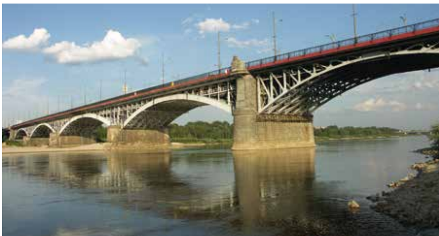
Fot. 3. Most Poniatowskiego w Warszawie z 1913 r. po przebudowie
