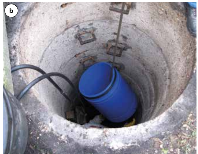
Fot. 4. Przykładowe renowacje metodą reliningu krótkiego, z wykonaniem wykopu startowego i rozburzeniem fragmentu istniejącego rurociągu (a) oraz bez wykopu startowego – tu moduły podawane przez studzienkę kanalizacyjną (b)
