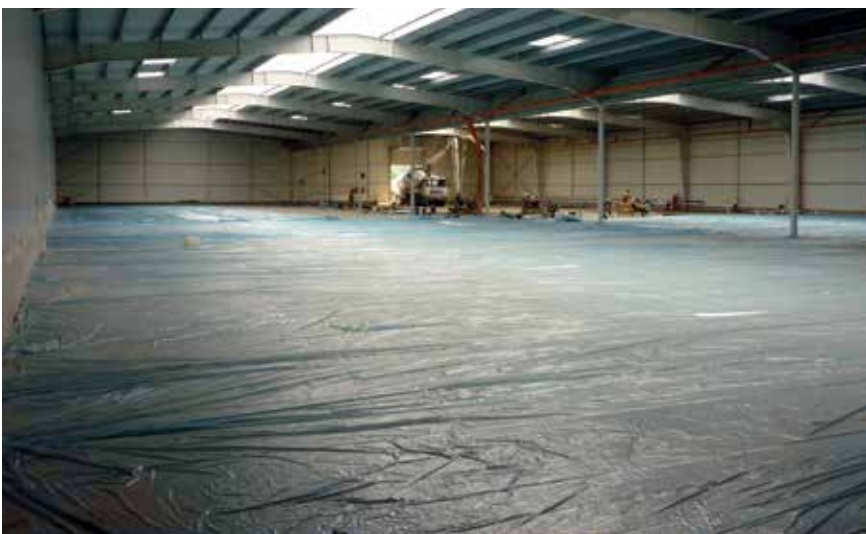
Fot. 5. Pielęgnacja płyty posadzki przez przykrycie folią
