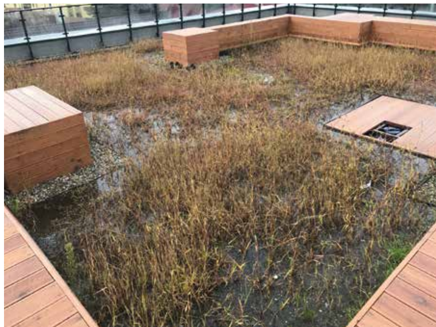
Fot. 1. Zastoiska wody na dachu zielonym (tu intensywnym) to konsekwencja źle dobranych wpustów oraz zastosowania w funkcji separatorów pomiędzy opaskami żwirowymi a warstwą substratu ekobordów zamiast profili perforowanych
