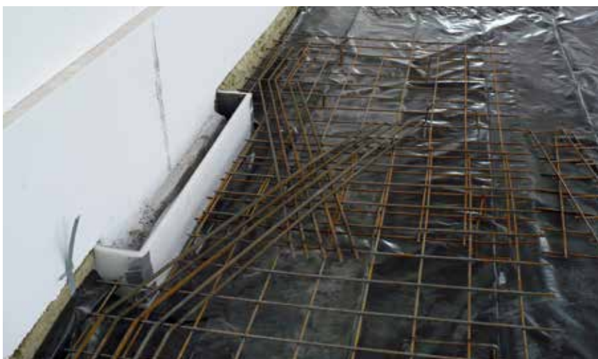
Fot. 3. Zbrojenie posadzki przy otworze
