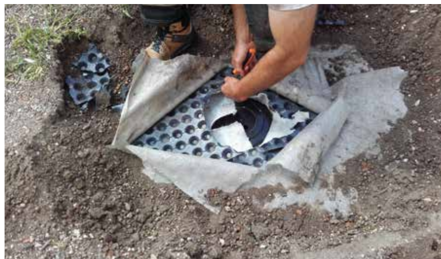
Fot. 2. Taras zielony w trakcie prac naprawczych polegających na odsłonięciu wpustu i zamontowaniu nadstawki rewizyjnej nad wpustem
