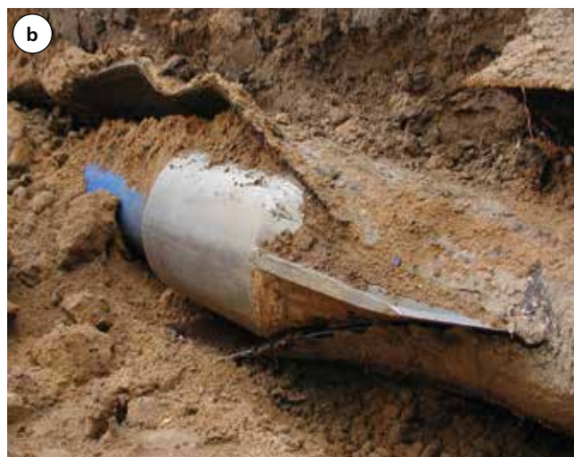
Fot. 3. Zastosowanie wkładów odcinkowych z blach stalowych jako przykład metody naprawy (kofrinie wewnętrzne widoczne w wycinku rury [zdjęcie wykonane na Targach WOD-KAN w Bydgoszczy]) (a) i kraking statyczny jako przykład metody wymiany rurociągów (b)
