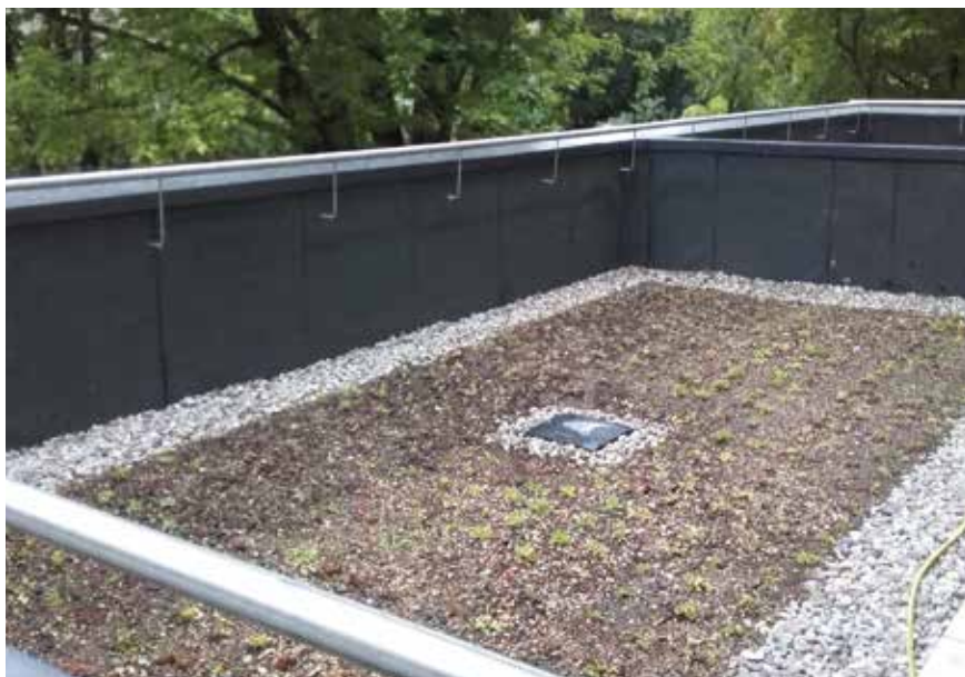
Fot. 3. Prawidłowo zamontowany wpust wraz z nadstawką rewizyjną
