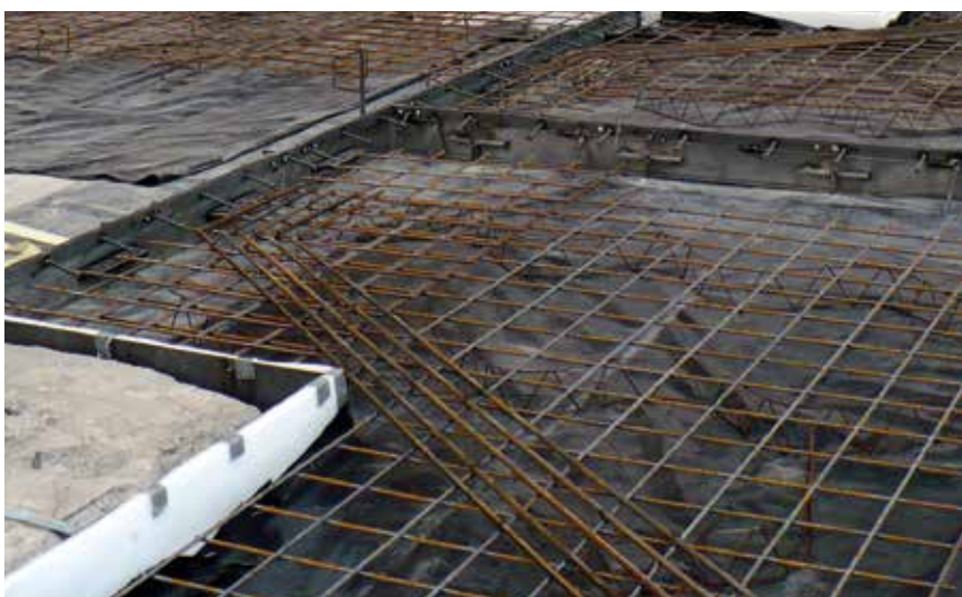
Fot. 4. Profile dylatacyjne ograniczające pola robocze i zbrojenie posadzki w rejonie słupów
