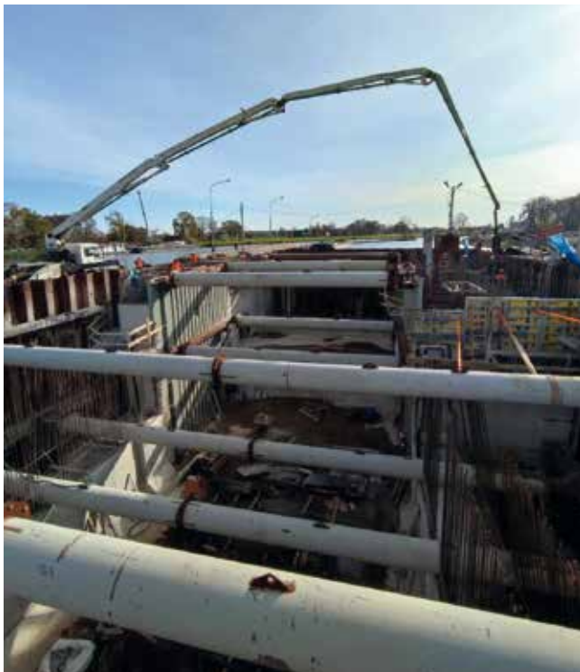
Fot. 2. Betonowanie elementów śluzy Januskowice, 2022 r.
