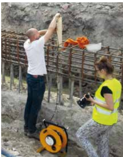
Fot. 1. Pomiar inklinometryczny ściany szczelinowej
