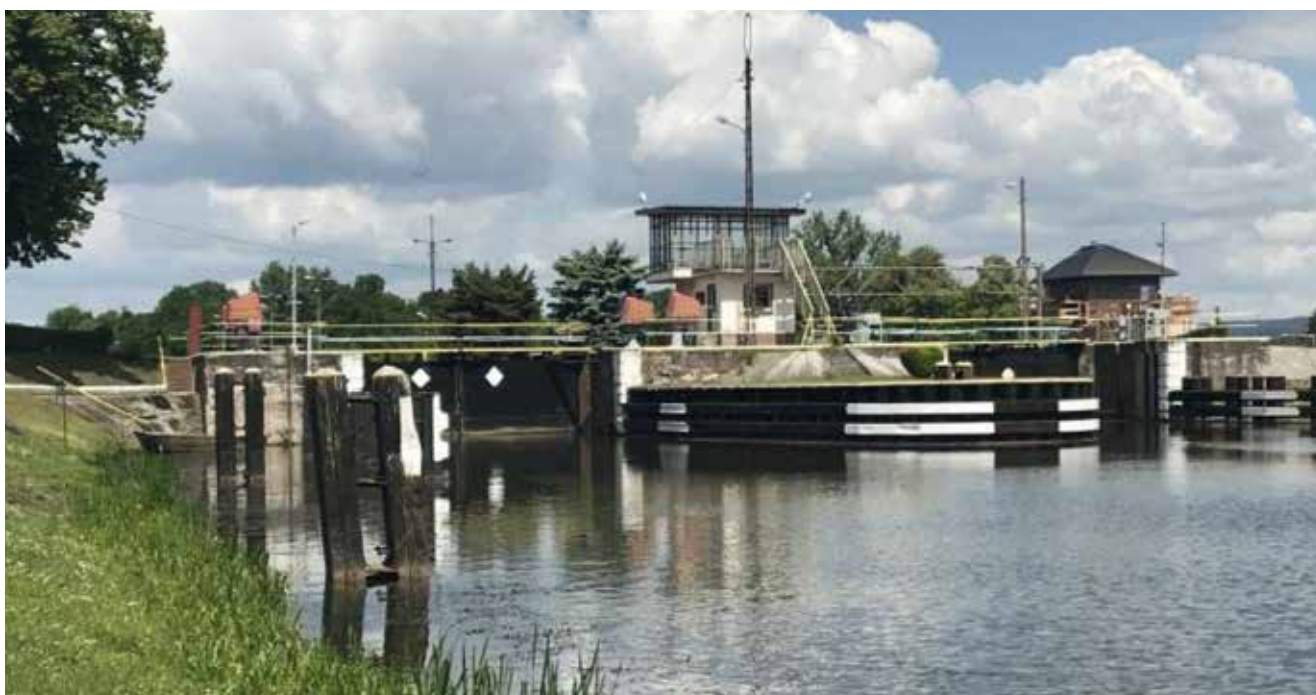
Fot. 1. Wrota i sterownia śluzy od strony wody górnej
