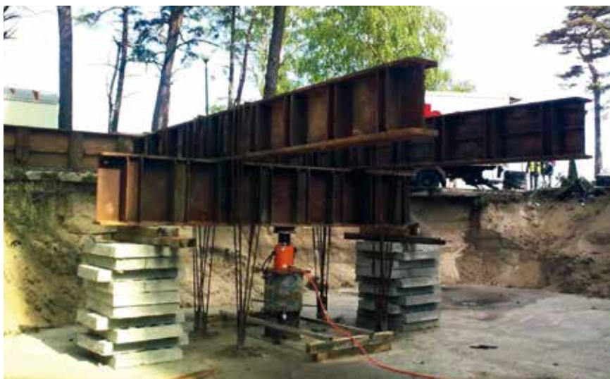
Fot. 2. Próbné obciążenie pala fundamentowego
