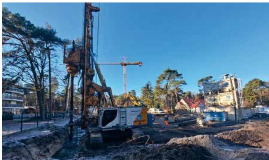
Fot. 2. Wykonanie sieciowej palisady z kolumn DSM
