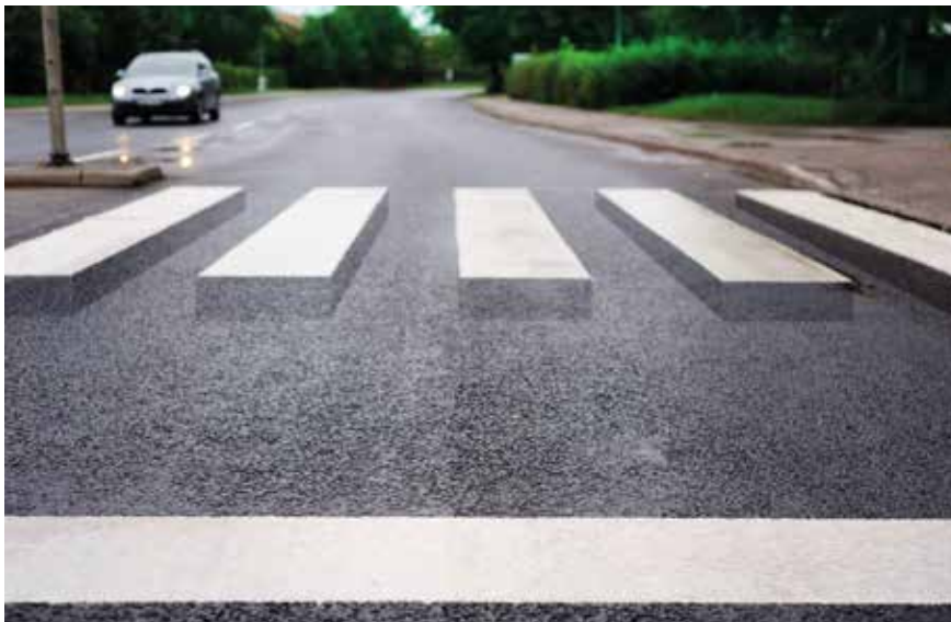
Fot. 3b. Oznakowanie 3D w postaci pasów „zebra” na przejściu dla pieszych [5]
