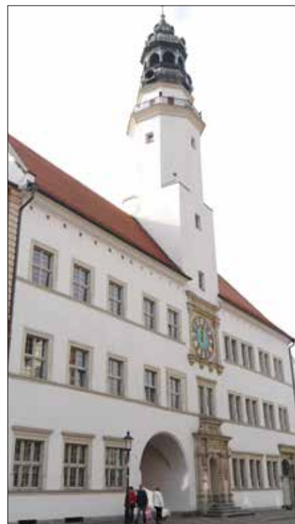
Fot. 1. Widok ogólny budynku ratusza, w którym przeprowadzono badania fizyko-chemiczne tynków
