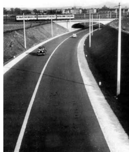
Fot. 1. Linie oznakowania poziomego malowane na jezdni dróg na początku XX w. [2]
