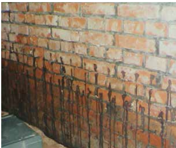
Fot. 1. Ściana murowana z cegły czerwonej z poziomą przeponą iniekcyjną wykonaną z użyciem produktu Hydrostop-Iniekcyjny nr 721
