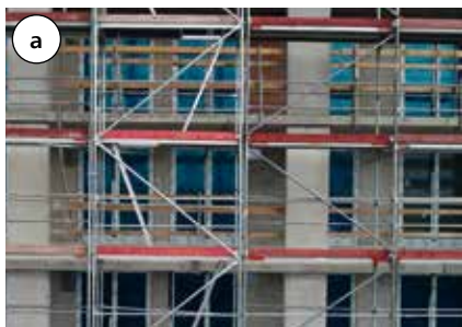
Fot. 4. Analizowane rusztowanie – budowa budynku mieszkalnego: a) widok ogólny na fragment pionu stężającego, b) widok na uszkodzoną deskę krawężnikową
