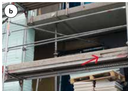
Fot. 4. Analizowane rusztowanie – budowa budynku mieszkalnego: a) widok ogólny na fragment pionu stężającego, b) widok na uszkodzoną deskę krawężnikową
