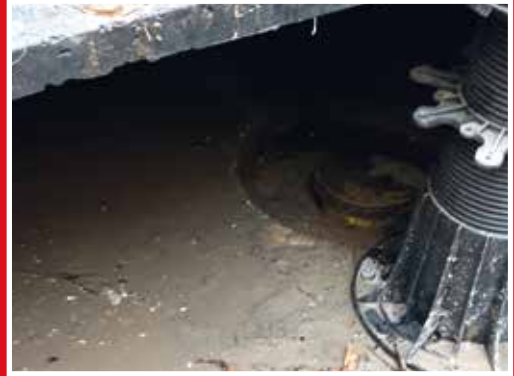
Wykonanie wpustu odwodnieniowego
