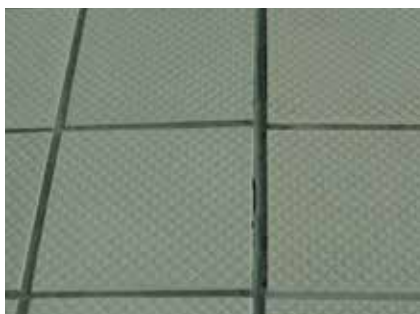
Fot. 3–5. Do wykonania przelewów i plaży należy stosować wyłącznie ceramikę basenową przeznaczoną do tego celu
