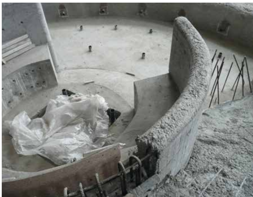
Fot. 1. Przygotowanie podłoża to jeden z podstawowych wymogów mających wpływ na poprawność wykonanych robót w basenach
