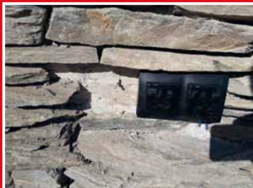
Obróbka gniazdek osadzonych w elewacji z kamienia łupkowego
