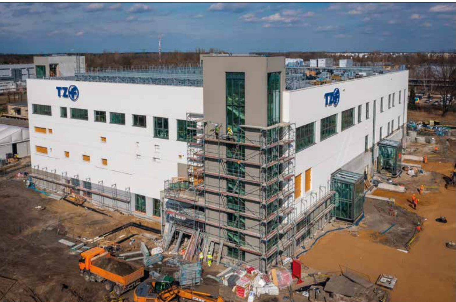
Stan budowy w marcu 2023 r.
