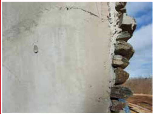
Elewacja – beton architektoniczny i kamień łupkowy
