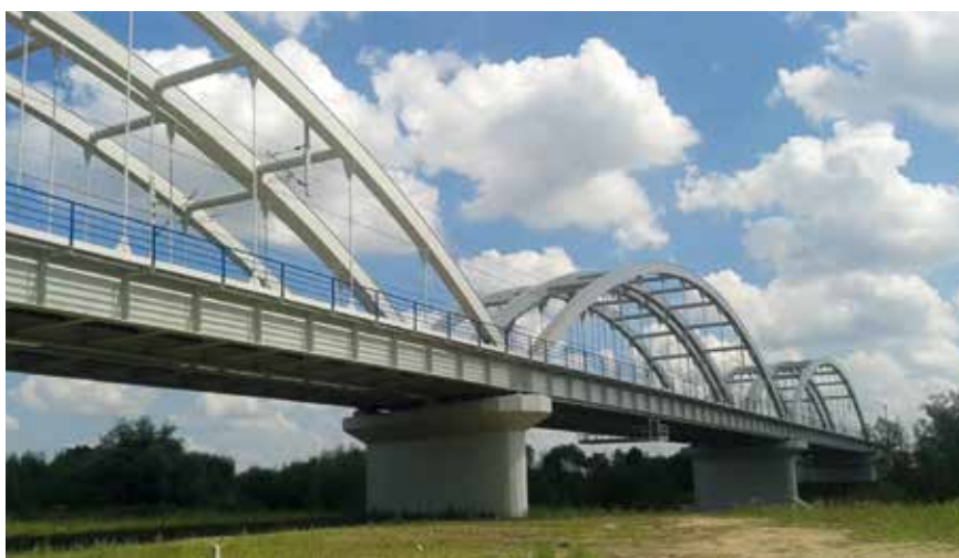
Fot. Widok ogólny mostu nad rzeką Wisłoka w pobliżu miasta Dębica na linii E30
