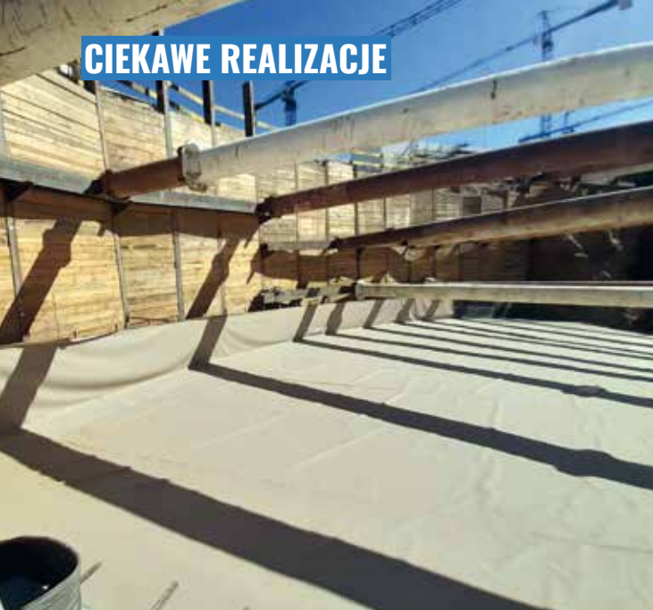
Fot. 4. Izolacja ciężka płyty fundamentowej
