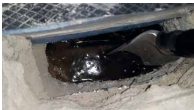
Fot. 1-2. Odkrycia w podłożu budynku niepodpiwniczonego – widoczna warstwa wody to skutek zastosowania przypadkowych materiałów hydroizolacyjnych
