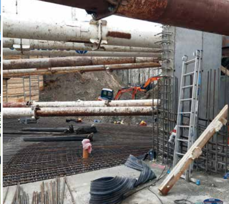
Fot. 5. Realizacja wykopów i płyty fundamentowej
