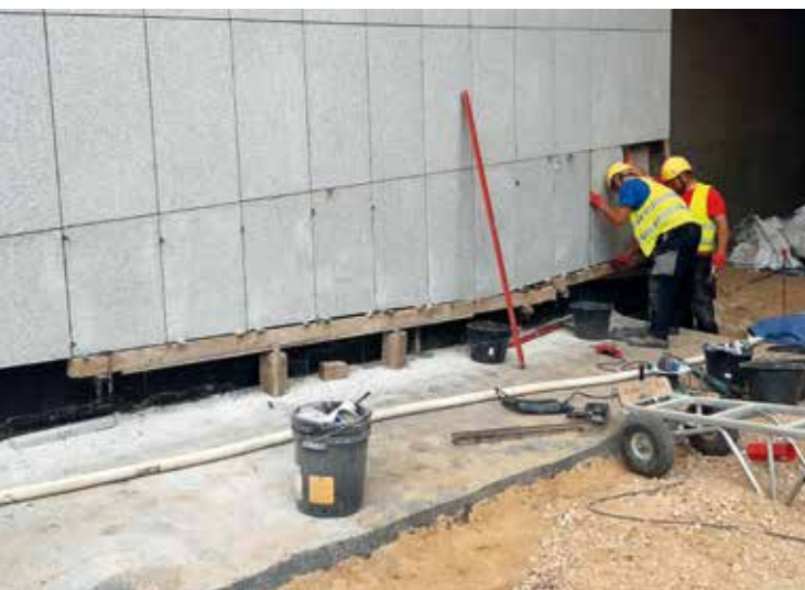
Fot. 14. Okładzina granitowa ścian wjazdu
