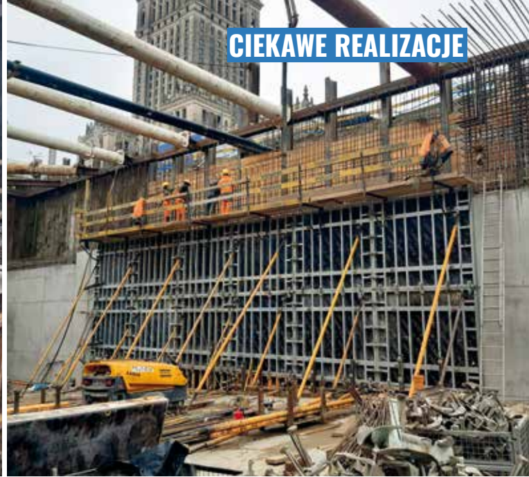
Fot. 9. Wykonanie ścian tunelu
