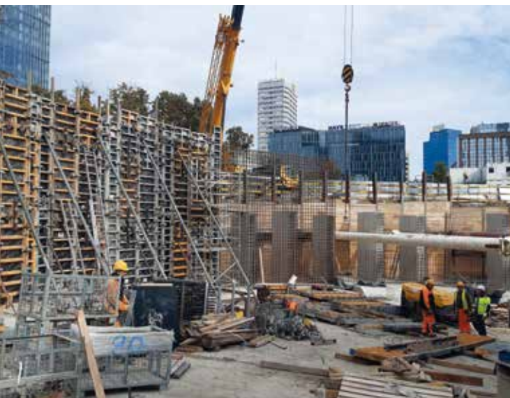
Fot. 6. Zbrojenie i deskowanie żeber i ścian
