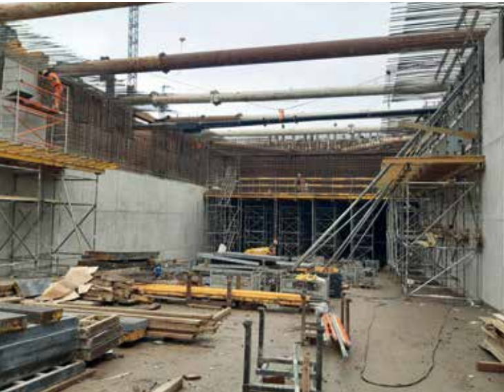
Fot. 10. Rusztowanie stropu tunelu
