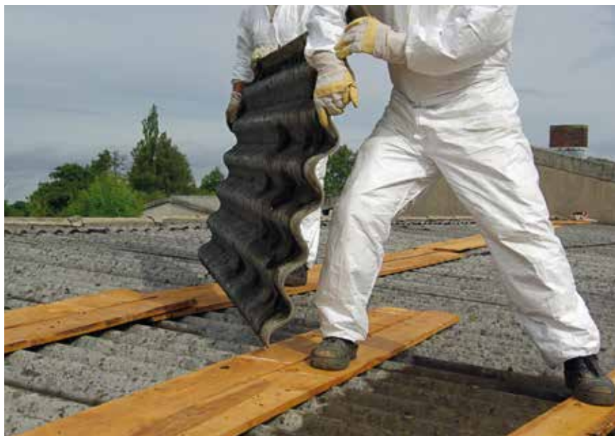
Fot. 1. Ocenę stanu i możliwości bezpiecznego użytkowania wyrobów zawierających azbest powinno się przeprowadzać w cyklach co najmniej rocznych. Na zdjęciu: usuwanie pokrycia dachowego zawierającego azbest
