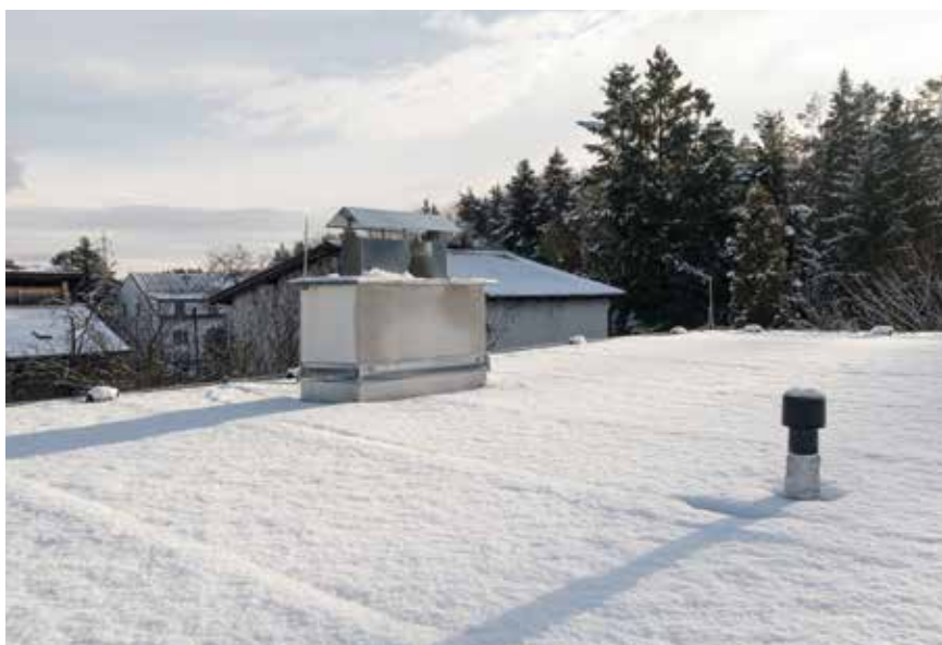
Fot. 3. Dachy powinny bezpiecznie przenosić obciążenie zmieniającym się w czasie ciężarem pokrywy śnieżnej
