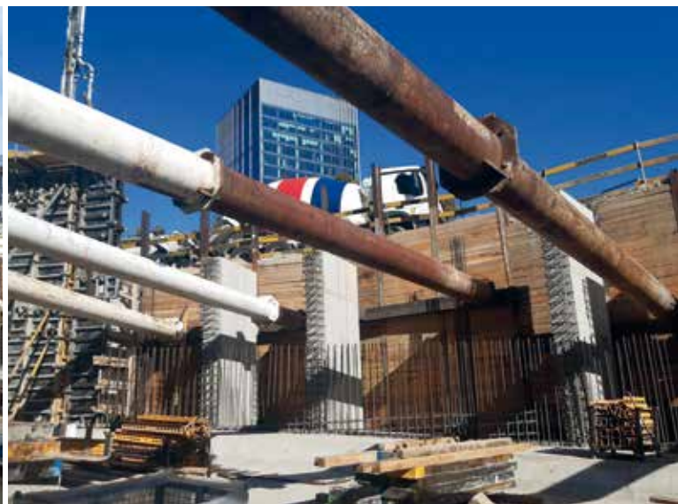
Fot. 7. Betonowanie ścian
