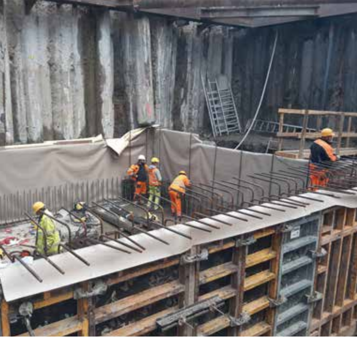
Fot. 8. Realizacja zbiornika retencyjnego i przepompowni
