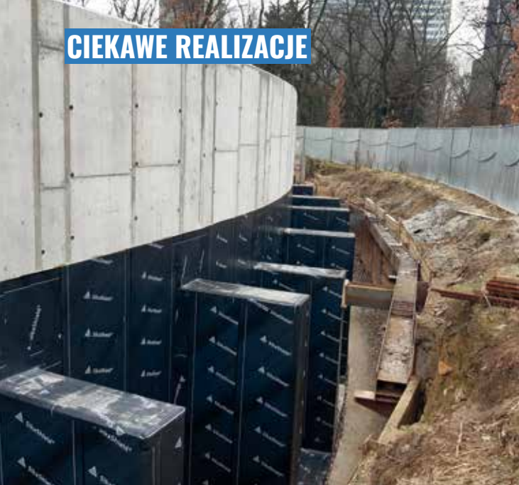
Fot. 12. Izolacja ścian zewnętrznych wjazdu
