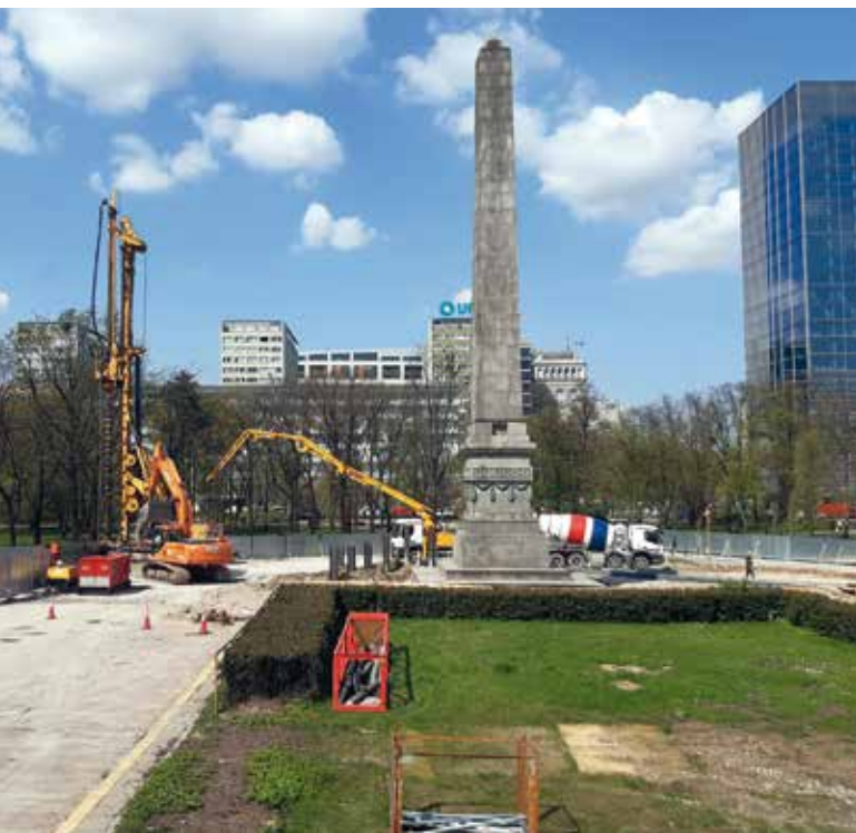
Fot. 2. Realizacja pali ścianki berlińskiej
