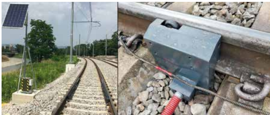
Fot. 1. Smarownica listwowa CL-E1 z zasilaniem solarnym oraz mechaniczny moduł napędowy zasilający urządzenie CL-E1
