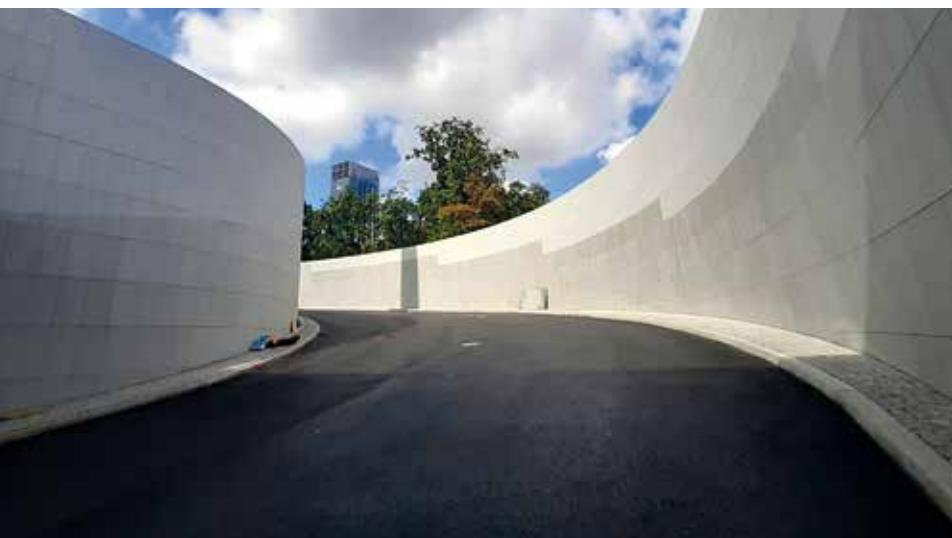
Fot. 16. Wjazd z tunelu
