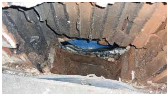
Fot. 1-2. Odkrycia w podłożu budynku niepodpiwniczonego – widoczna warstwa wody to skutek zastosowania przypadkowych materiałów hydroizolacyjnych
