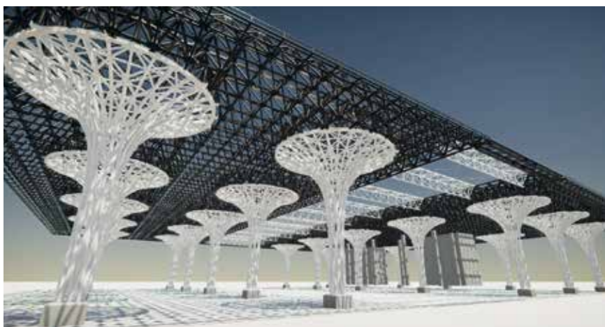
Rys. 9. Konstrukcja stalowa budynku głównego dworca [5]
