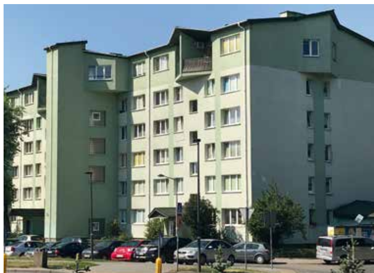
Fot. 2. Budynek wielokopłytowy po modernizacji i dobudowie zewnętrznego szybu windowego
