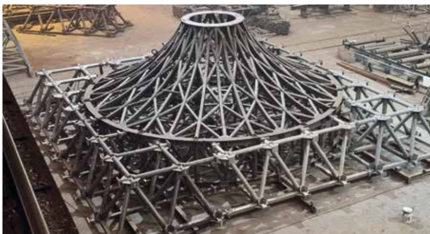
Fot. 3. Widok korony stupa w trakcie prefabrykacji
