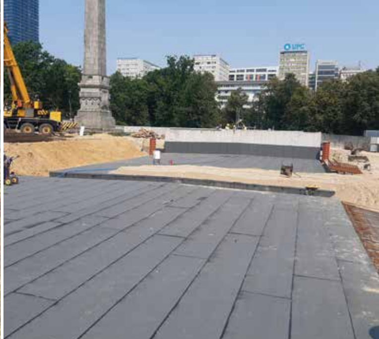
Fot. 13. Izolacja stropu tunelu
