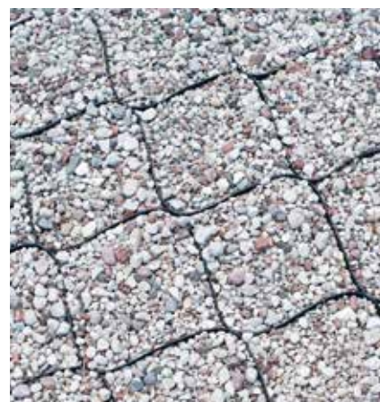
Fot. 1. Przykład zastosowania geokraty do wzmocnienia nawierzchni parkingu [6]
