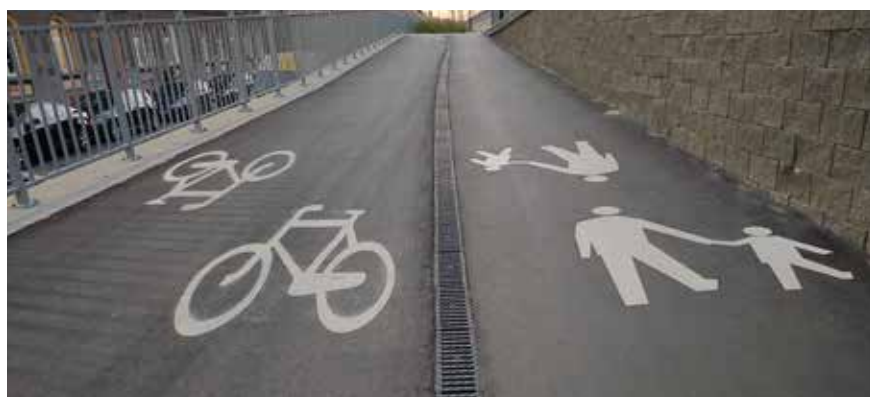
Fot. 4. Zastosowanie odwodnienia liniowego oddzielającego powierzchnie o różnym zastosowaniu
