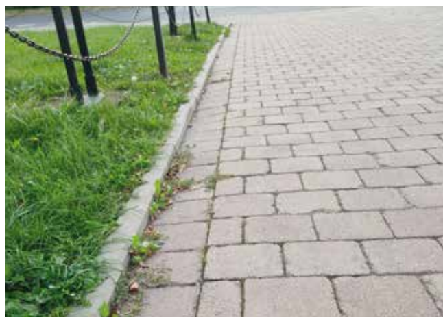
Fot. 2. Nadanie poprzecznego pochylenia drodze dla pieszych umożliwiającego odpływ wody do ścieku przykrawężnikowego
