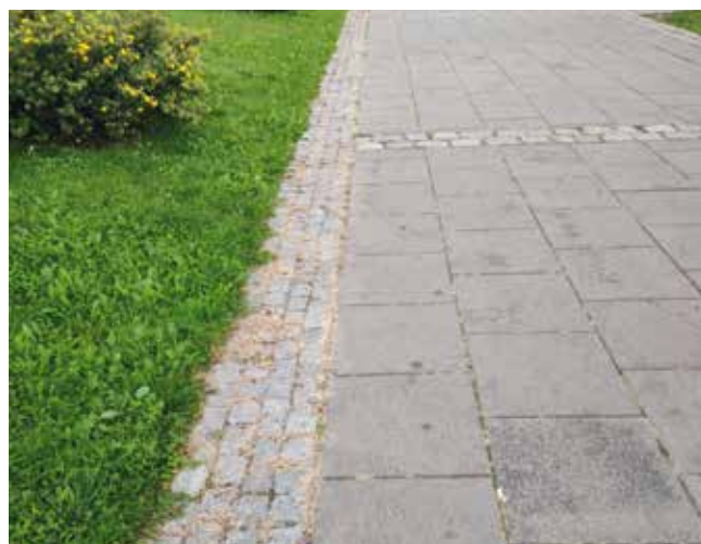
Fot. 6. Zastosowanie ścieku muldowego odprowadzającego drogę dla pieszych
