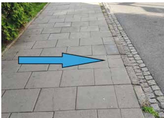
Fot. 1. Nadanie poprzecznego pochylenia drodze dla pieszych umożliwiającego odpływ wody na jezdnię
