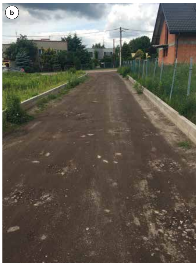
Fot. 1. Fragment wykonanej nawierzchni drogi wewnętrznej (a) oraz nawierzchnia gruntowa podbudowy bez warstwy ścieralnej i z elementami krawężniowymi (b)
