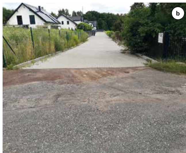
Fot. 2. Wykonana nawierzchnia drogi wewnętrznej (a) oraz brak połączenia drogi wewnętrznej z drogą publiczną (b)
