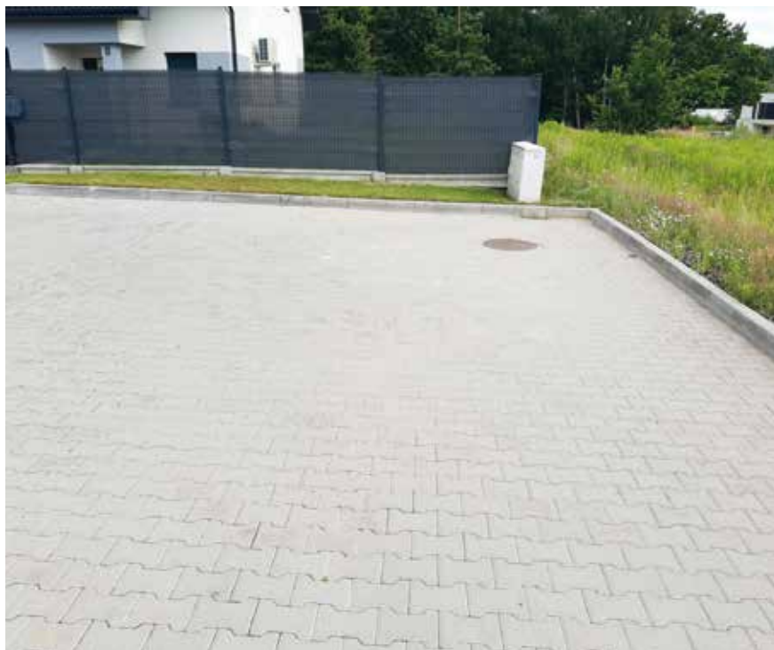
Fot. 3. Powierzchnia bezodpływowa, do której kierowane były wody opadowe z całej powierzchni komunikacyjnej
