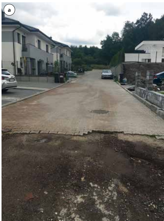
Fot. 1. Fragment wykonanej nawierzchni drogi wewnętrznej (a) oraz nawierzchnia gruntowa podbudowy bez warstwy ścieralnej i z elementami krawężniowymi (b)
