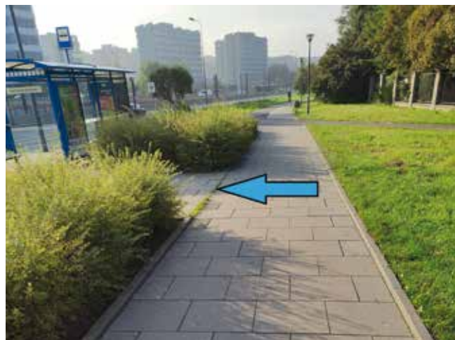
Fot. 8. Przerwa w terenie zielonym umożliwiająca odpływ wody
