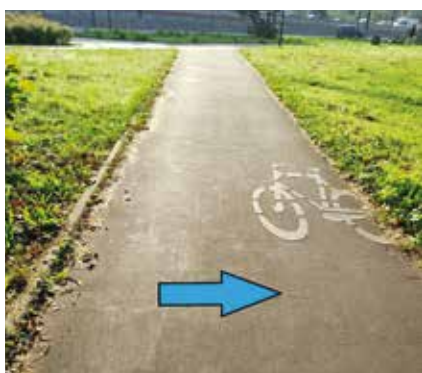
Fot. 3. Nadanie poprzecznego pochylenia drodze dla rowerów umożliwiającego odpływ wody na teren zielony
