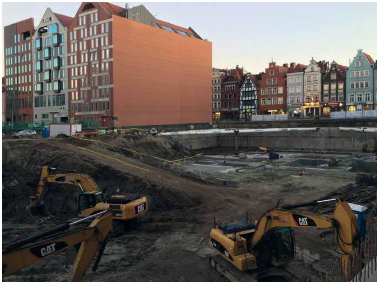
Fot. 1. Wykop w Gdańsku na Wyspie Spichrzów 80 m od koryta Martwej Wisły. Powierzchnia uszczelniana produktem Hydrostop-Mata Penetrująca to ponad 10 000 m 2
