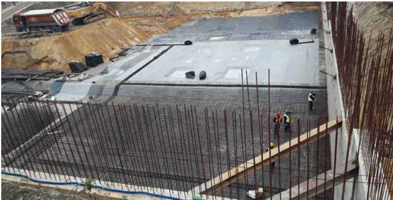
Fot. 2. Hydroizolacja płyty fundamentowej osiedla mieszkaniowego w Katowicach. Powierzchnia uszczelniana produktem Hydrostop-Mata Penetrująca to ponad 6000 m 2 . Widoczne są częściowo rozłożone taśmy PVC w liniach podziału pól szachownicy betonowania
