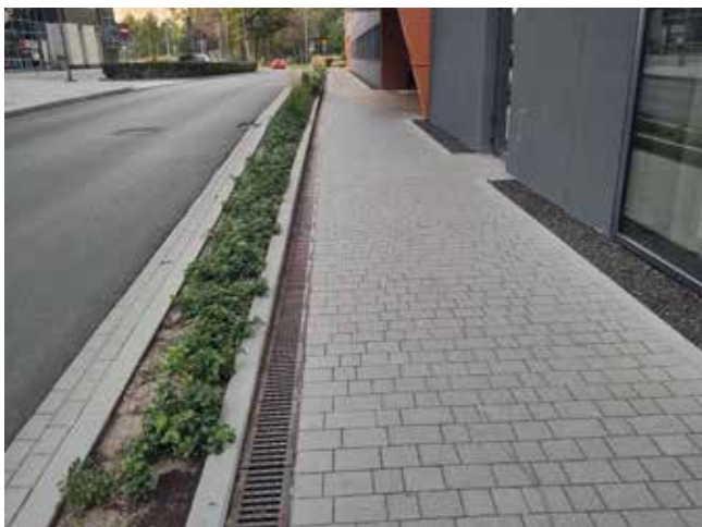
Fot. 7. Zastosowanie ścieku korytkowego odwadniającego drogę dla pieszych
