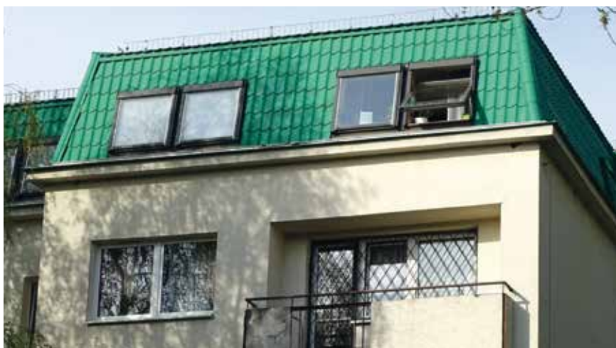
Fot. 3. Przykład nadbudowy kondygnacji
