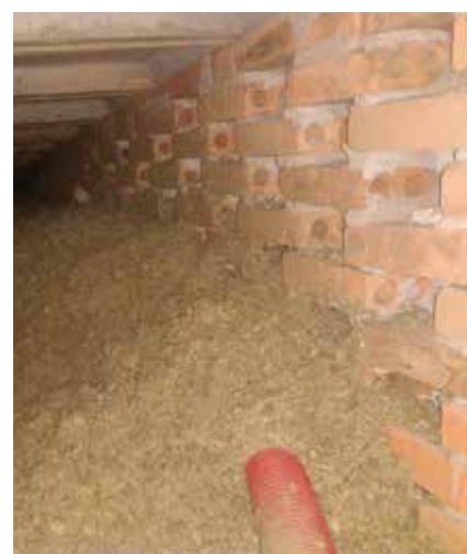
Fot. 9. Układanie izolacji metodą wdmuchiwania
