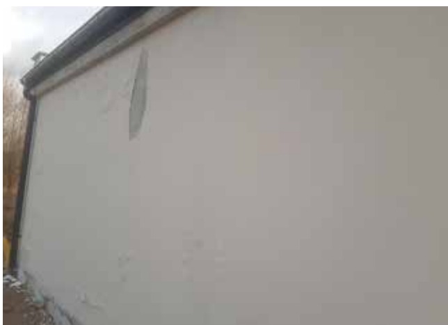
Fot. 3-4. Odspojenia wyprawy tynkarskiej spowodowane podwyższoną wilgotnością podłoża
