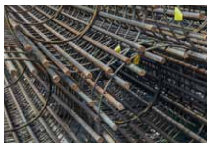
Fot. 2. Prefabrykowane zbrojenie
