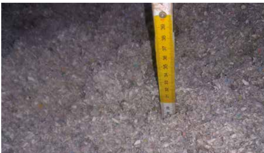
Fot. 10. Punktowy pomiar grubości izolacji podczas wykonywania prac
