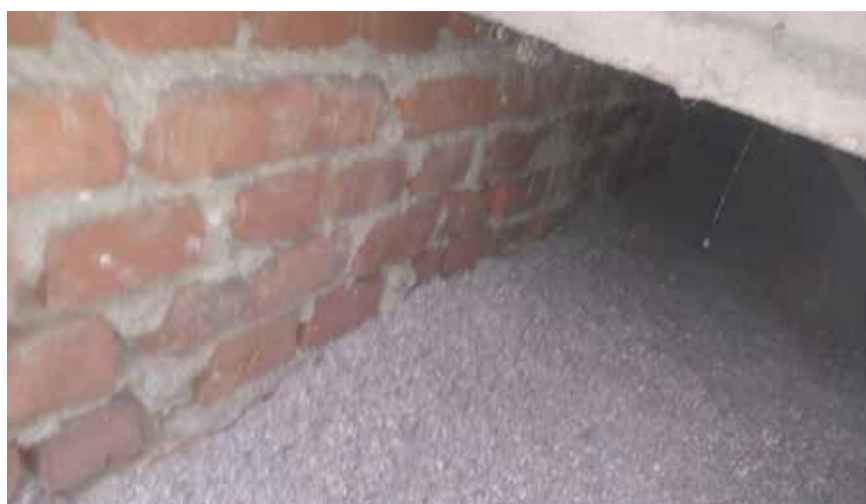
Fot. 8. Jednolita warstwa izolacji (celuloza) w przestrzeni stropodachu
