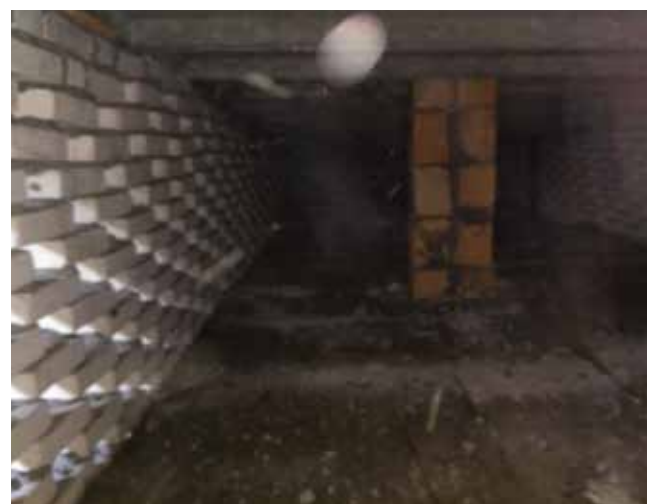
Fot. 2-3. Dwudzielny stropodach wentylowany ocieplony metodą dmuchiwania; na zdjęciach widoczne ścianki ażurowe
