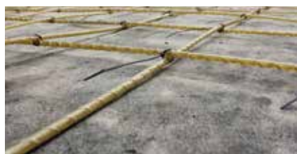
Fot. 1. Zbrojenie niemetaliczne
