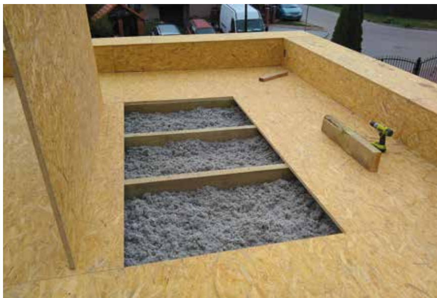
Fot. 1. Celuloza jako ocieplenie stropodachu w konstrukcji drewnianej
