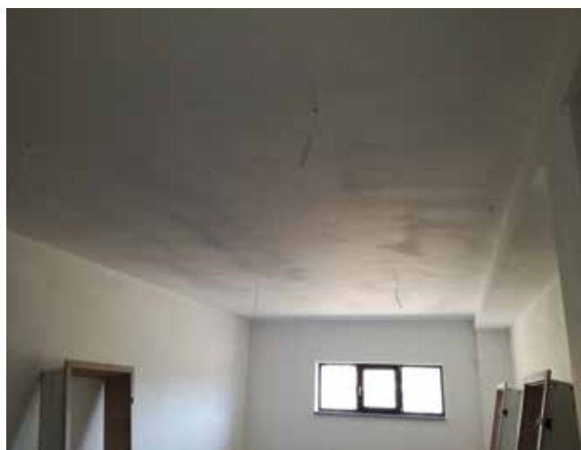
Fot. 1–2. Smugi na powierzchni sufitu i ściany
