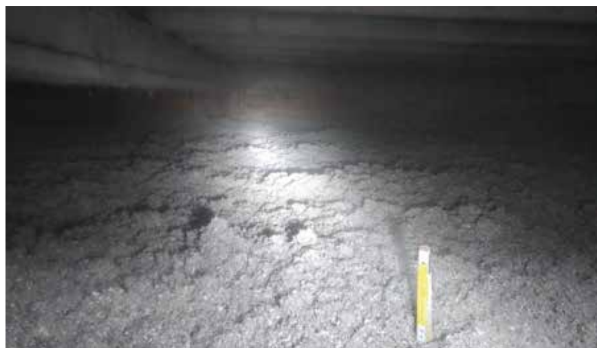
Fot. 11. Celuloza wdmuchiwana na stropie przekrywa całość przestrzeni homogeniczną warstwą ocieplenia
