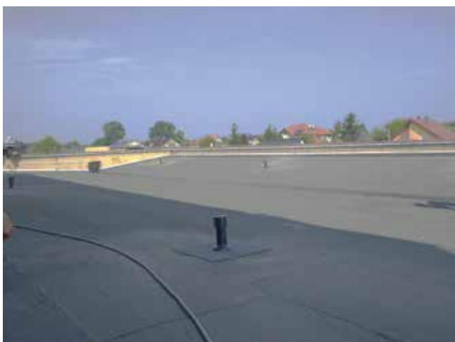
Fot. 4. Zabezpieczenie otworów technicznych z użyciem kominów wentylacyjnych
