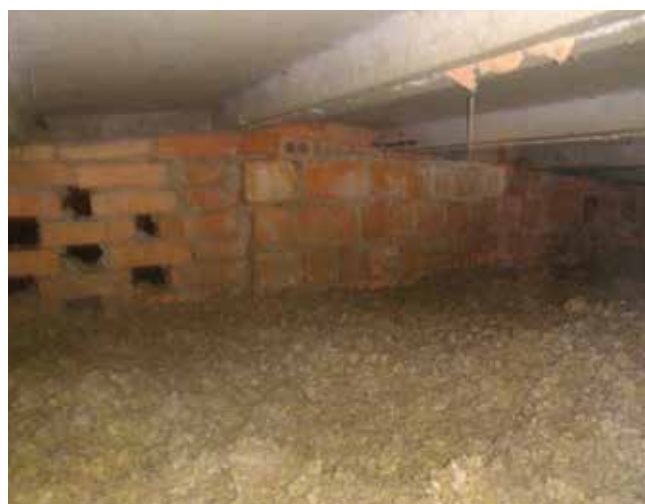
Fot. 2-3. Dwudzielny stropodach wentylowany ocieplony metodą dmuchiwania; na zdjęciach widoczne ścianki ażurowe
