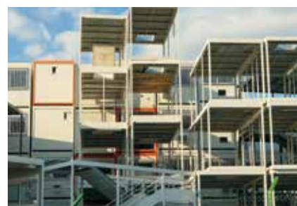
Fot. 3. Budownictwo modułowe
