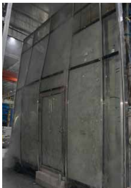
Fot. 3. Jednoskrzydłowe, aluminiowe, profilowe drzwi zamontowane w stowarzyszonej konstrukcji mocującej (przeszklonej ścianie osłonowej) w trakcie badania w zakresie odporności ogniowej
