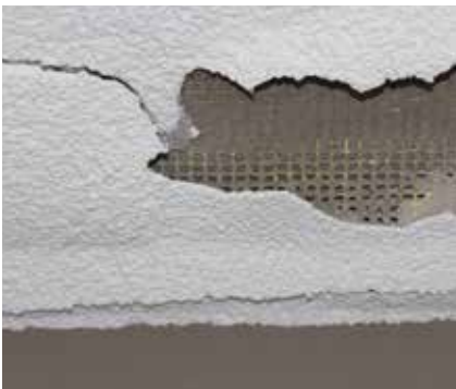
Fot. 3. Miejsce łączenia siatek wykonywane metodą mokre na mokre
