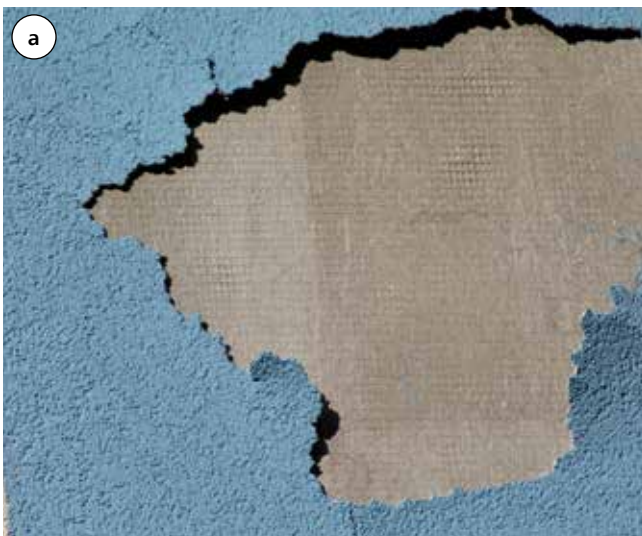
Fot. 4. Oczka siatki nie mogą być widoczne na powierzchni warstwy zbrojącej
