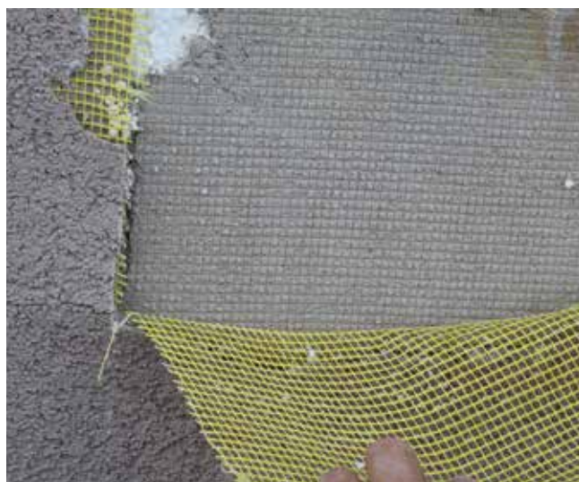
Fot. 1. Wynik wykonania warstwy zbrojącej w dwóch zabiegach
