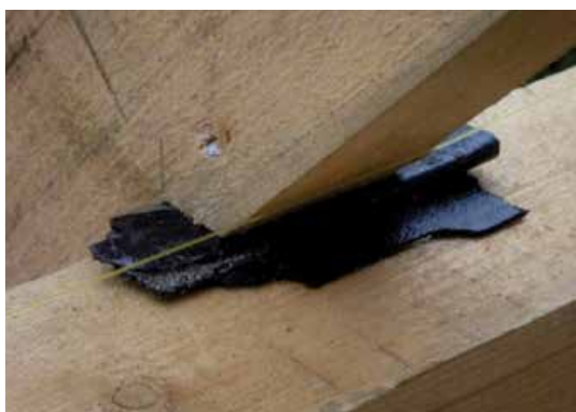
Fot. 6. Niefrasobliwe zaciosy w węzłach podporowych i nieudolne „naprawianie” płytkami kątowymi
