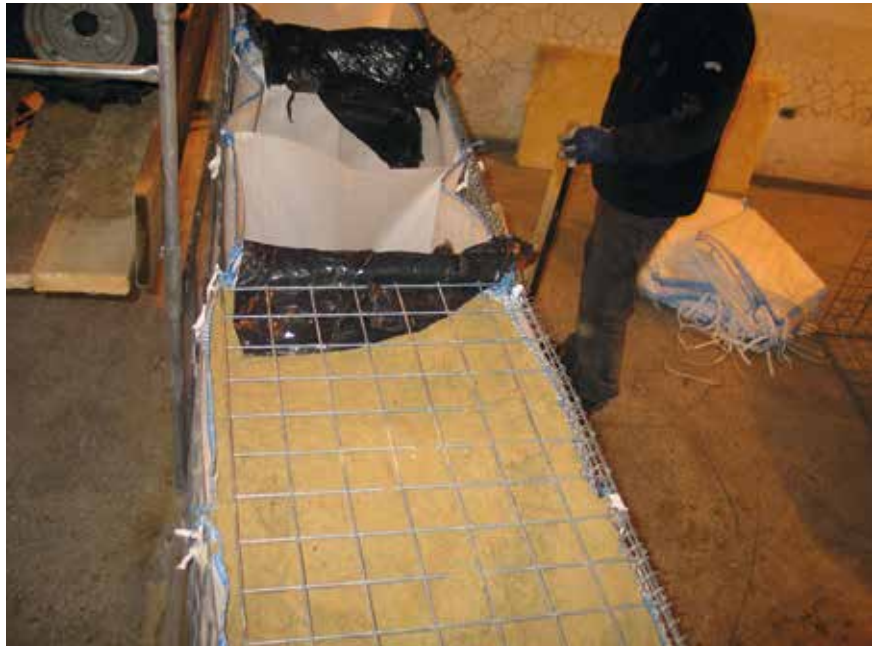
Fot. 2. Widok przykładowej próbki ekranu akustycznego w postaci gabionów. Zdjęcie wykonano na etapie montażu próbki [5]
