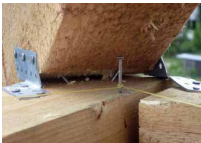
Fot. 5. Pęknięcia krokwi
