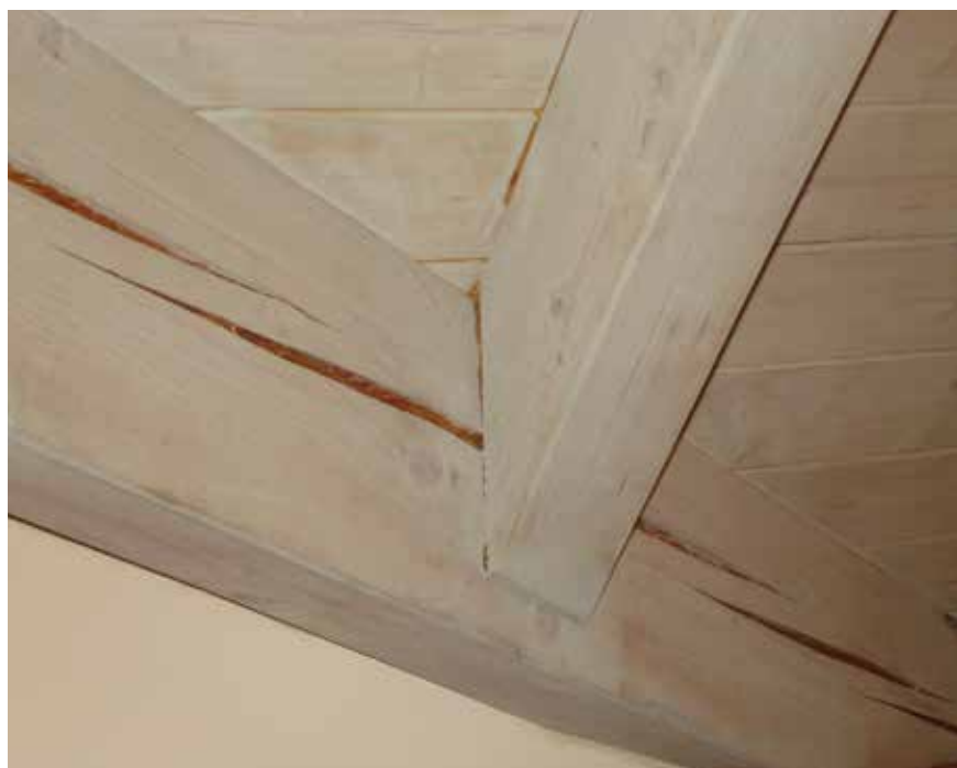
Fot. 5. Pęknięcia krokwi
