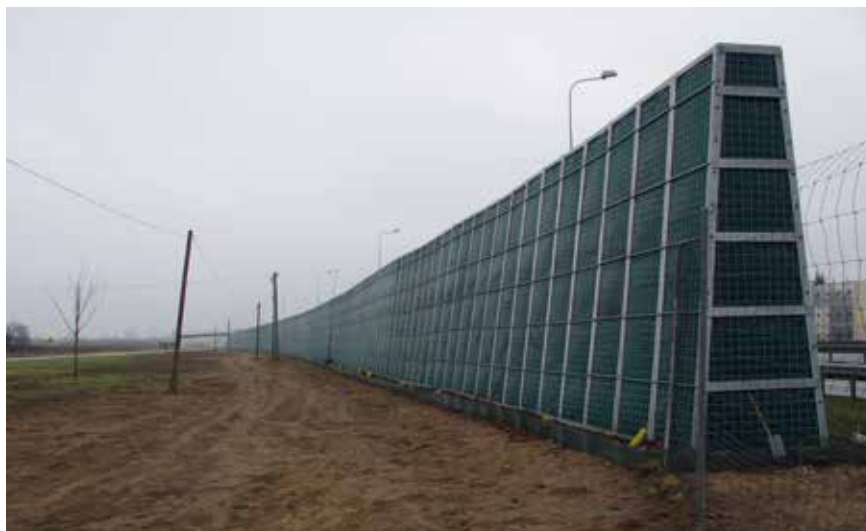
Fot. 3. Widok badanego ziemnego ekranu akustycznego EA-1
