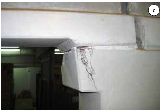
Fot. 8. Uszkodzenia stref podporowych: a) oparcie płaty na dźwigarze, b) oparcie zebra płyty TT na wsporniku belki, c) oparcie dźwigara na wsporniku stupa, d) oparcie belki na wsporniku stupa
