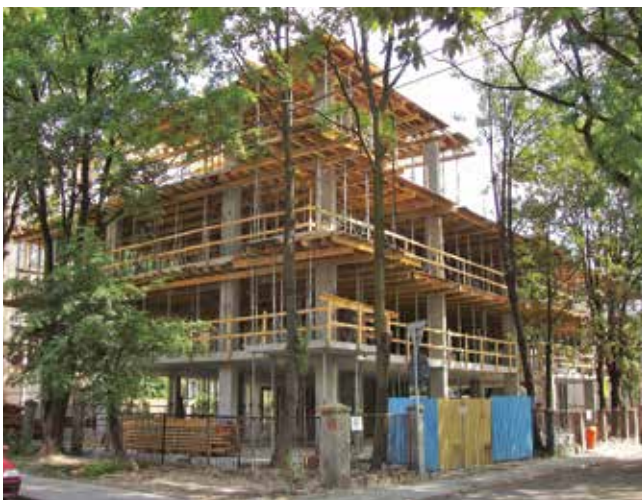
Fot. 1. Widok budynku podczas budowy
