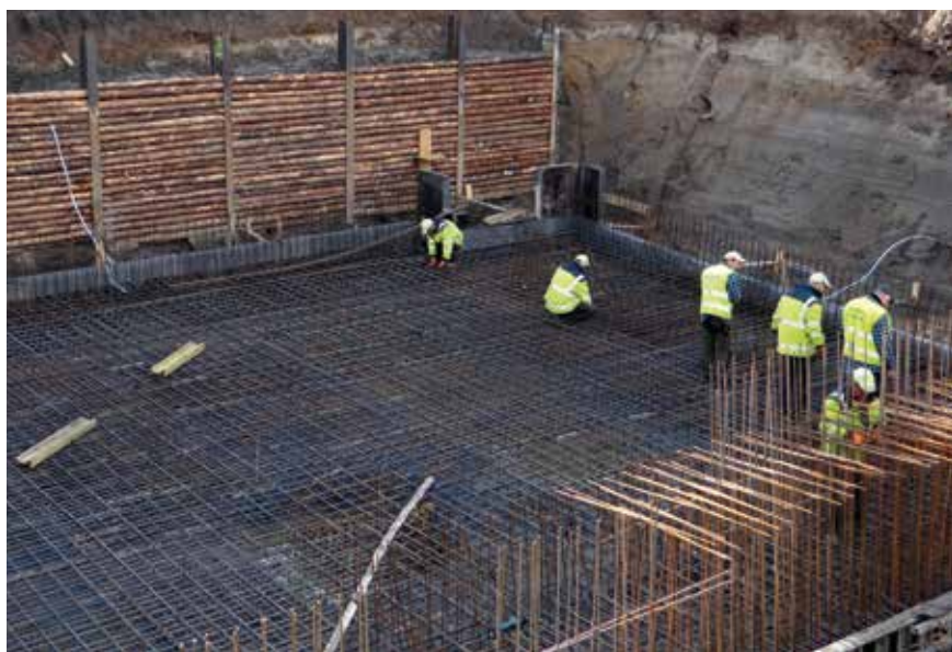
Montaż zbrojenia dolnej płyty fundamentowej
