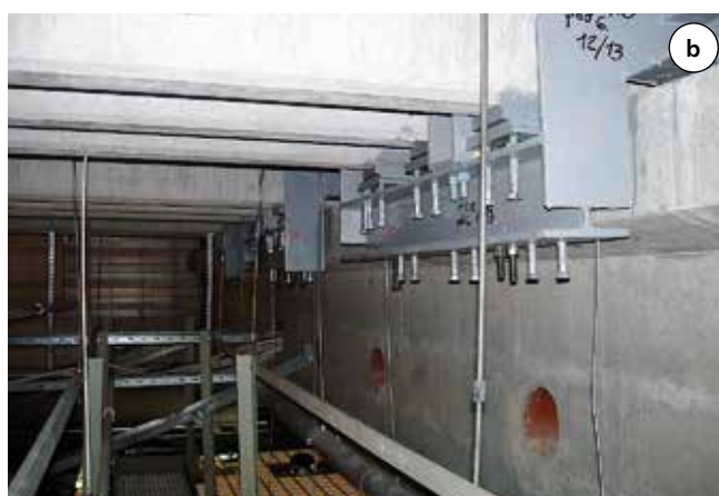
Fot. 8. Uszkodzenia stref podporowych: a) oparcie płaty na dźwigarze, b) oparcie zebra płyty TT na wsporniku belki, c) oparcie dźwigara na wsporniku stupa, d) oparcie belki na wsporniku stupa
