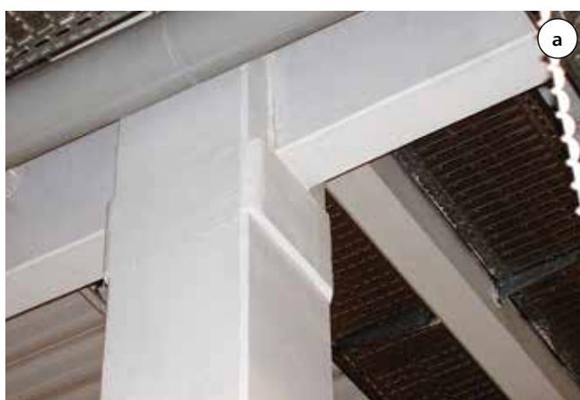
Fot. 9. Wzmocnienia stref podporowych: a) maty kompozytowe, b) wsporniki stalowe
