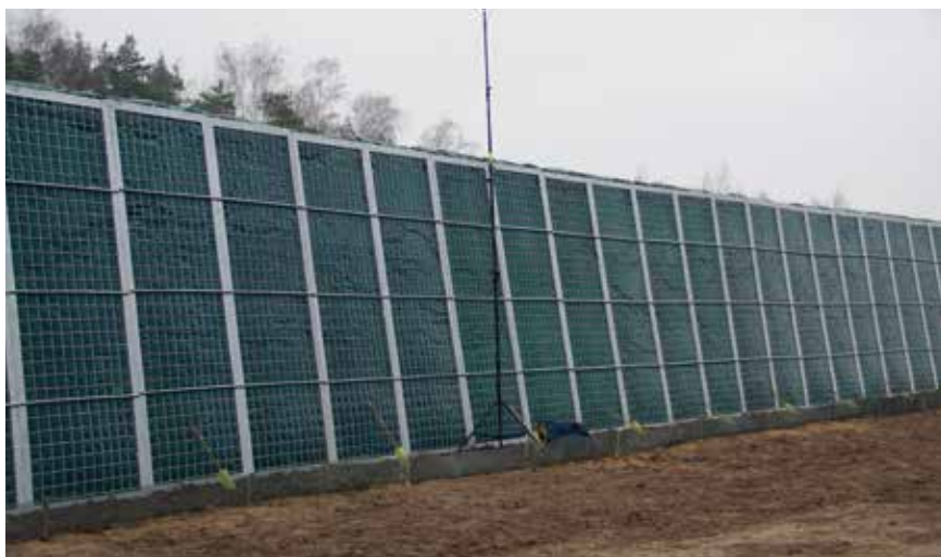
Fot. 4. Widok badanego ziemnego ekranu akustycznego EA-2
