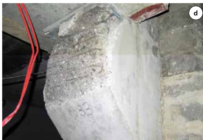
Fot. 8. Uszkodzenia stref podporowych: a) oparcie płaty na dźwigarze, b) oparcie zebra płyty TT na wsporniku belki, c) oparcie dźwigara na wsporniku stupa, d) oparcie belki na wsporniku stupa
