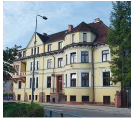
Budynek, w którym mieści się siedziba Biura Terenowego w Wałczu
