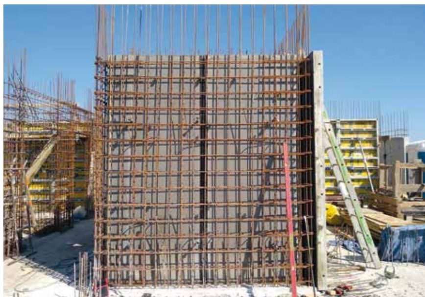
Fot. 2. Montaż zbrojenia i deskowania
