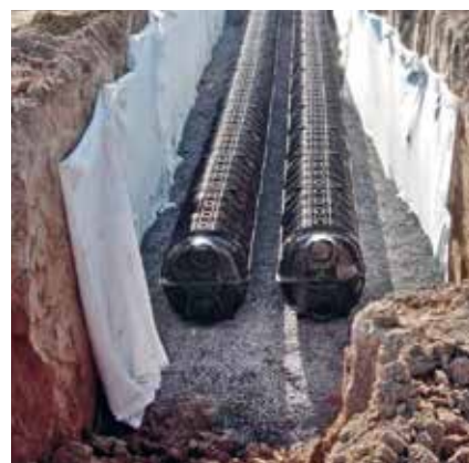
Fot. 9. Komora drenażowa [5]
