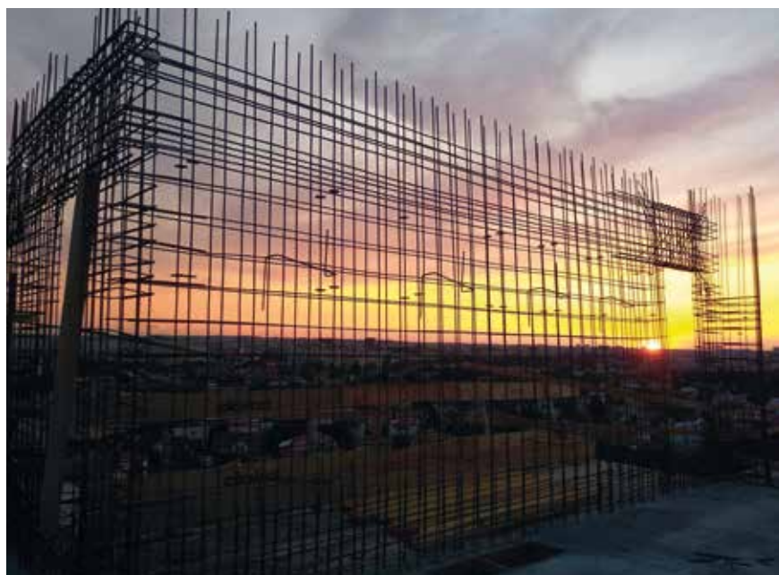
Fot. 1. Rozpoczęcie montażu zbrojenia
