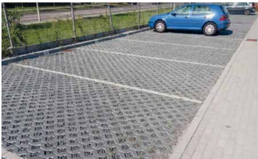
Fot. 7. Przykład zastosowania ażurowych płyt na miejscach postojowych
