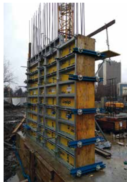
Fot. 3. Zakończenie montażu deskowania
