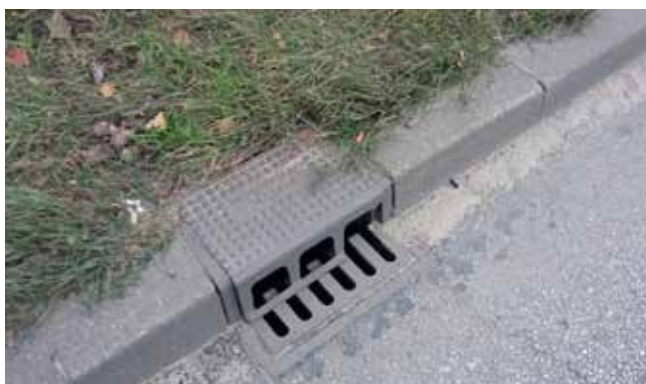
Fot. 5. Przykład wpustu krawężnikowo-jezdniowego
