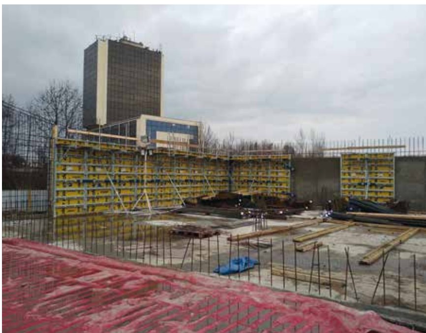
Fot 4. Stopniowy demontaż deskowania
