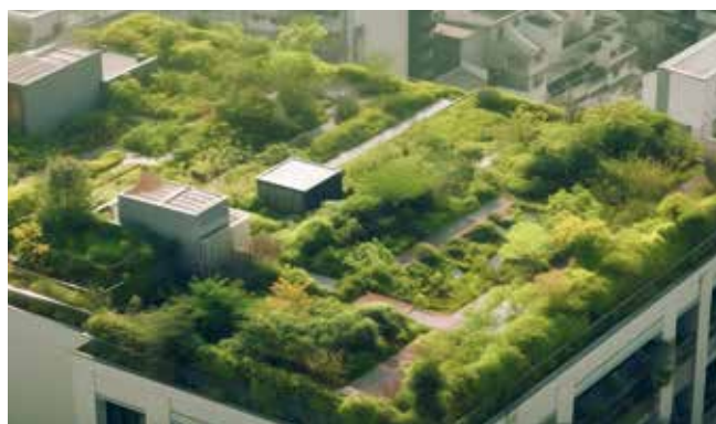
Fot. 6. Przykład rozwiązania dachu zielonego
