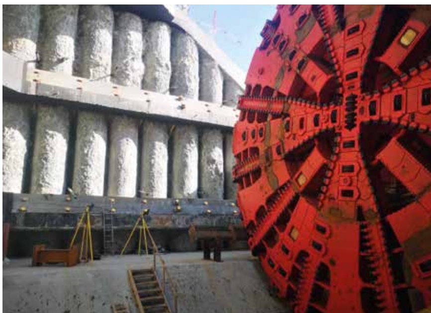
Fot. 1. Głowica tarczy zmechanizowanej przygotowana do drążenia tunelu T-1
