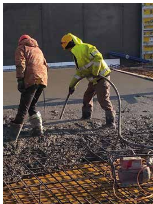
Fot. 10. Wibrowanie mieszanki betonowej za pomocą wibratora buławowego
