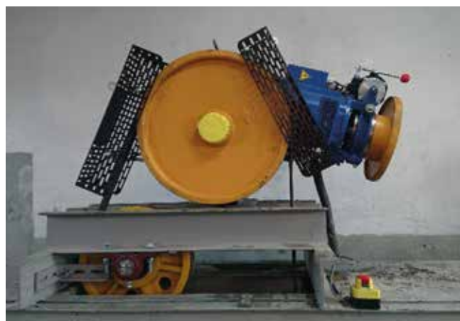
Fot. 2. Maszynownia z wciągarką reduktorową
