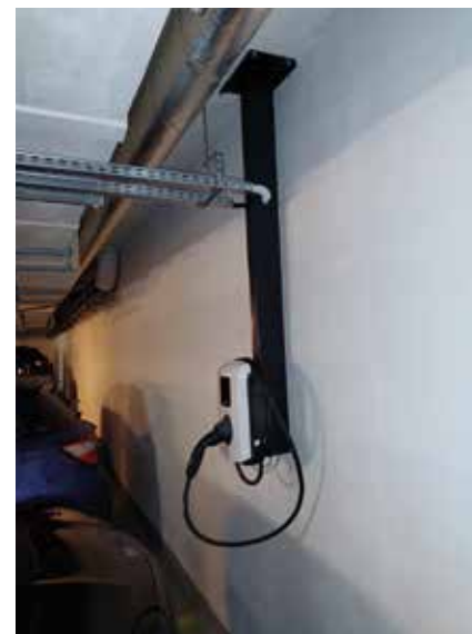
Fot. 2 i 3. Stacje ładowania zamontowane na słupkach przytwierdzonych do sufitu
