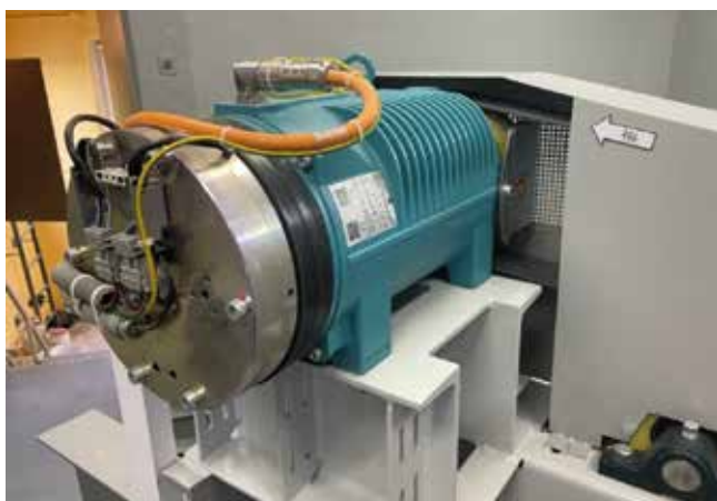
Fot. 1. Maszynownia z wciągarką bezreduktorową
