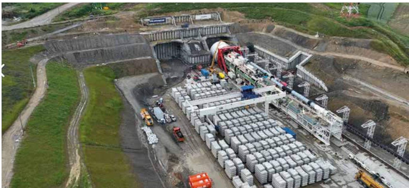
Fot. 3. Budowa tunelu T-1, Luboń Mały
