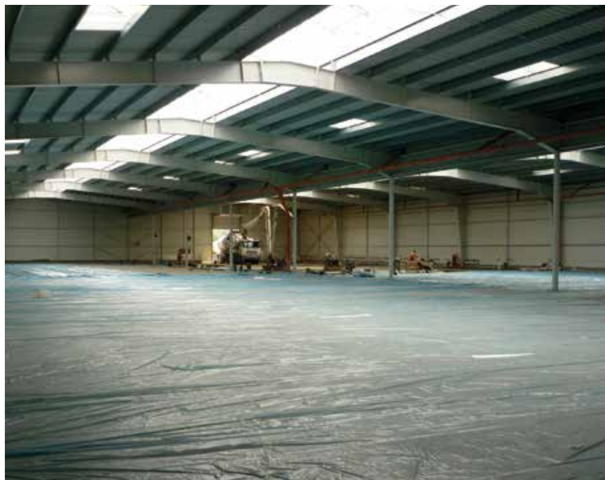
Fot. 8. Pielęgnacja płyty posadzki poprzez przykrycie folią
