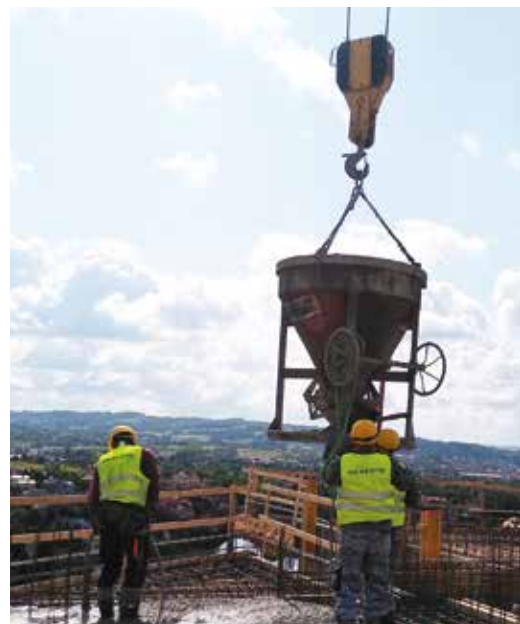
Fot. 4. Wyładunek mieszanki betonowej z pojemnika na beton
