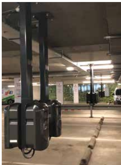
Fot. 2 i 3. Stacje ładowania zamontowane na słupkach przytwierdzonych do sufitu
