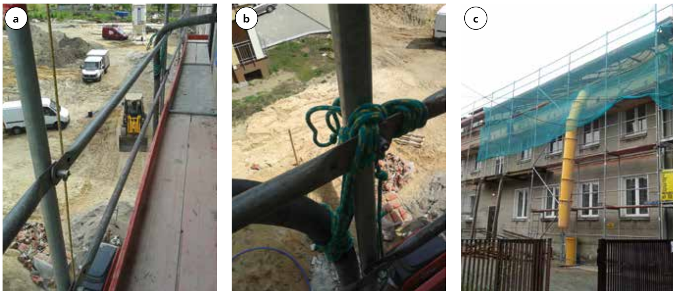
Fot. 4. Urządzenia wywołujące drgania rusztowania: a–b) przewód pomp do torkretowania, c) zsyp
