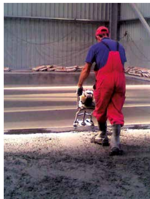
Fot. 11. Wibrowanie posadzki betonowej za pomocą wibratora powierzchniowego
