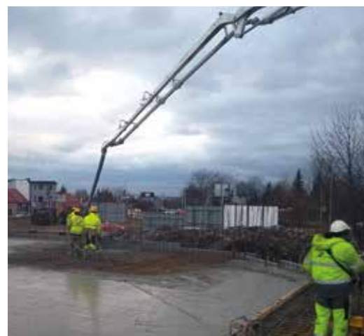
Fot. 6. Betonowanie płyty stropowej z użyciem pompy do betonu
