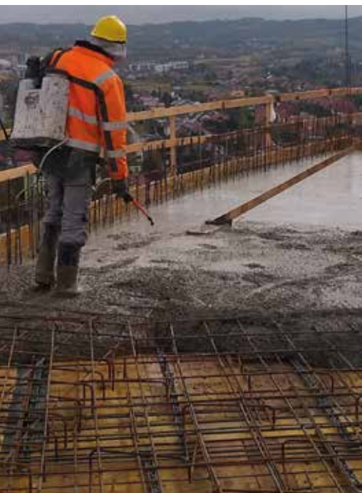
Fot. 7. Nakładanie powłoki zabezpieczającej przed parowaniem wody z betonu
