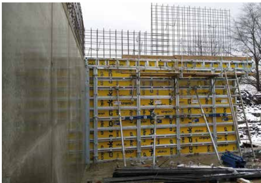
Fot. 12. Konstrukcja ścian z częściowo zdemontowanym deskowaniem
