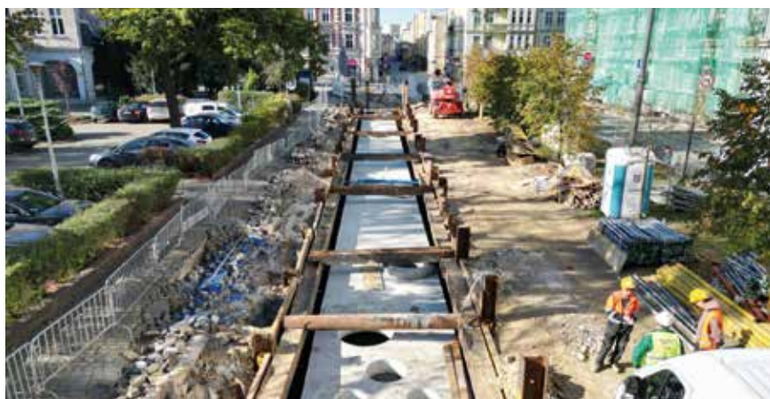
Fot. 2. Budowa zbiornika w ciągu ul. Mickiewicza
