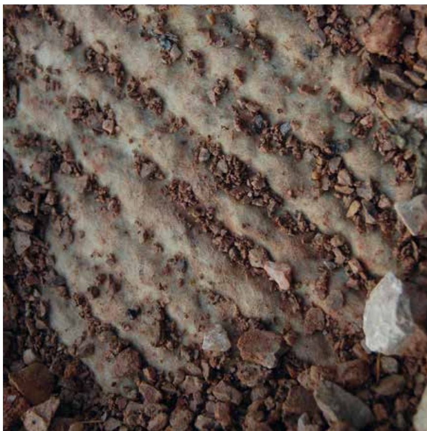
Fot. 4. Geowłóknina rozciągnięta na drenażu
