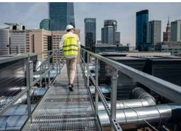
Ścieżki komunikacyjne na budynku mieszkalnym w Warszawie, wykonane przez Walraven
