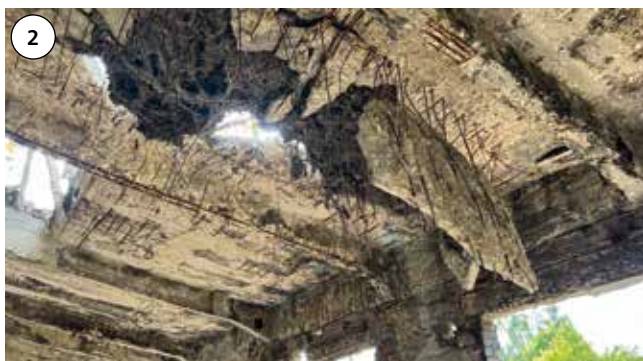
Fot. 2–3. Skutki degradacji korozyjnej konstrukcji żelbetowej
