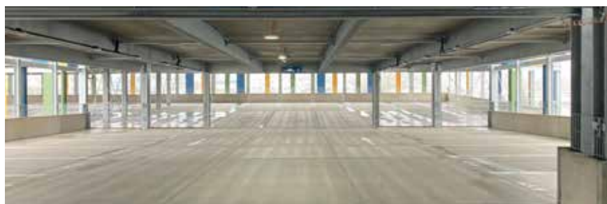
Fot. 4. Przestrzeń bezsłupowa w parkingach GOLDBECK
