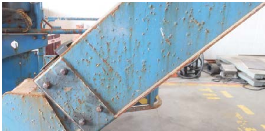
Fot. 1. Zardzewienie konstrukcji powyżej stopnia Ri3
