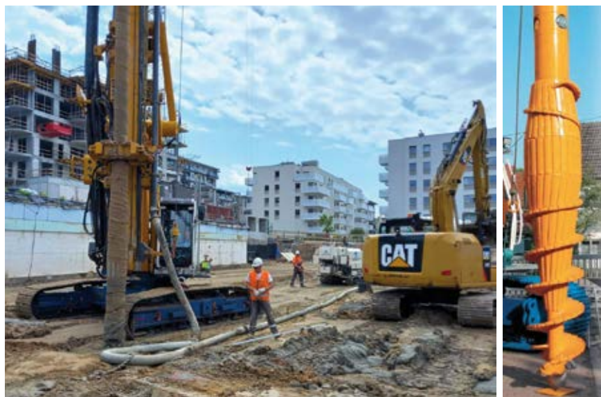
Fot. 2. Wiercenie kolumn FDC i świdra FDP/FDC, kompleks Plaza w Kielcach – etap III
