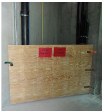
Fot. 2. Zabezpieczenie szachtu instalacyjnego
