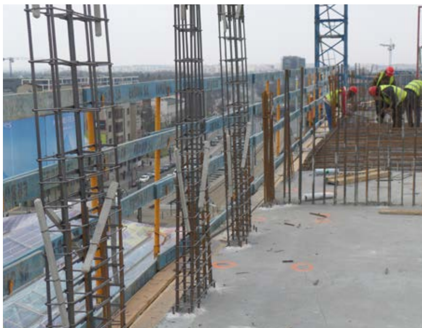
Fot. 3. Zabezpieczenie osób podczas zbrojenia stropu
