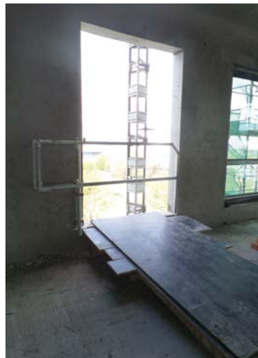
Fot. 1. Zabezpieczenie otworu stanowiącego dojście do windy budowlanej
