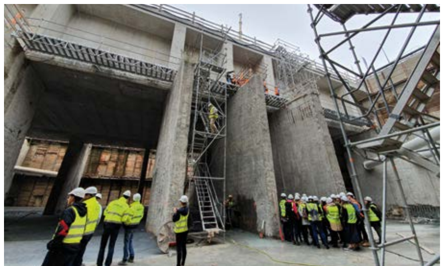
Fot. 2. Konstrukcja wzmacniająca przejścia drogi ekspresowej pod tunelem metra po odkopaniu
