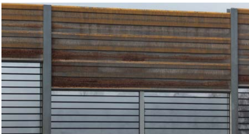
Fot. 8. Powłoki proszkowe zdegradowane całkowicie po roku eksploatacji z powodu niewłaściwego doboru systemu do warunków korozyjnych
