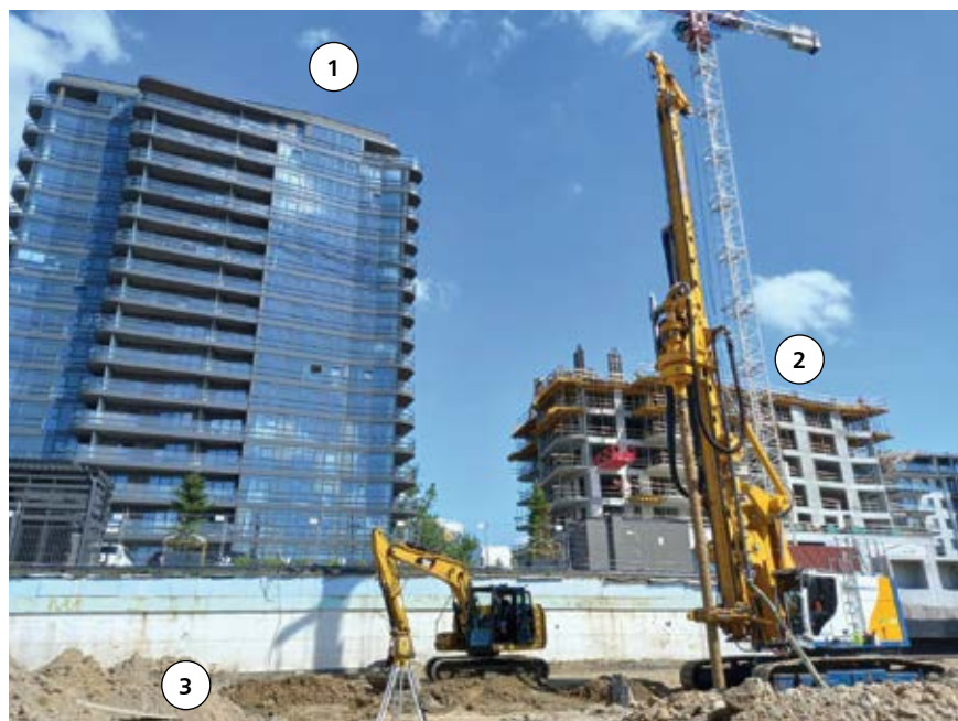
Fot. 1. Wzmocnienie podłoża gruntowego poprzez wiercenie kolumn FDC w kompleksie Plaza w Kielcach: 1 – etap I – ok. 570 szt. kolumn FDC, 2 – etap II – ok. 550 szt. kolumn FDC, 3 – etap III – ok. 230 szt. kolumn FDC
