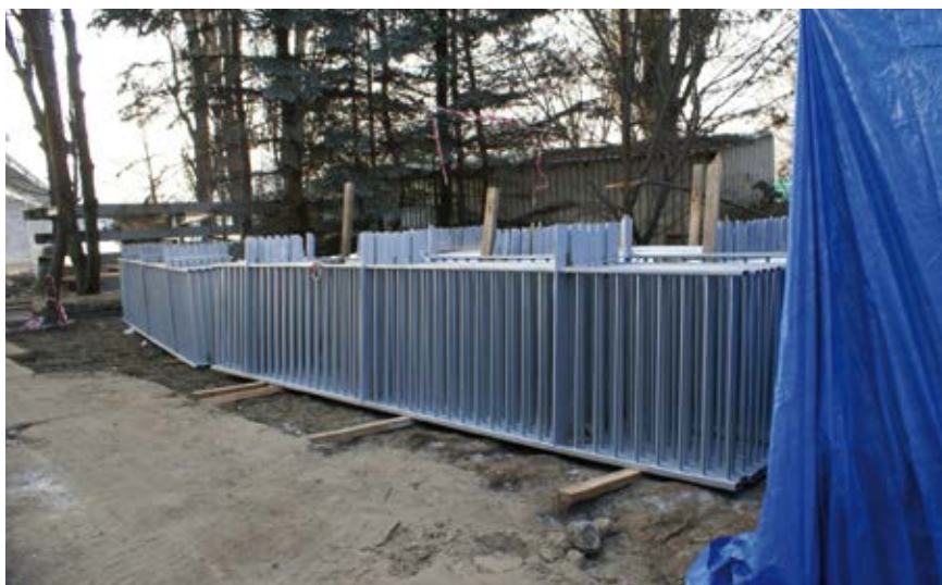
Fot. 5. Niewłaściwie utwardzone powłoki malarskie, które wymagały dodatkowego utwardzenia na placu budowy
