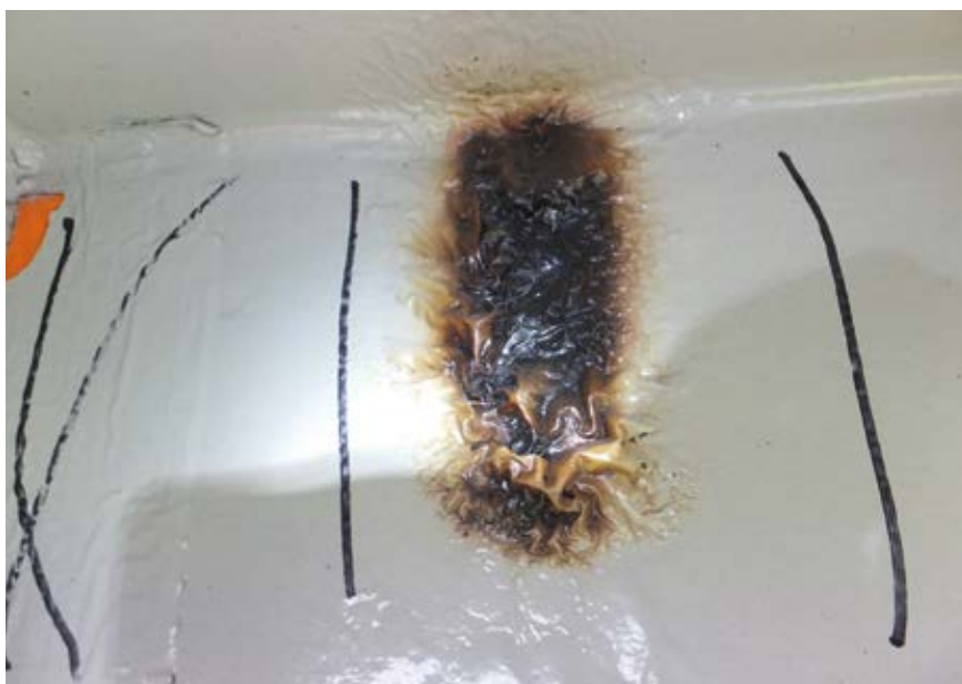
Fot. 4. Brak prawidłowego harmonogramu pracy skutkujący zniszczeniem powierzchni malowanych; po drugiej stronie powierzchni wykonywano spawanie i przedwcześnie pomalowane powierzchnie po przeciwnej stronie uległy przepaleniu
