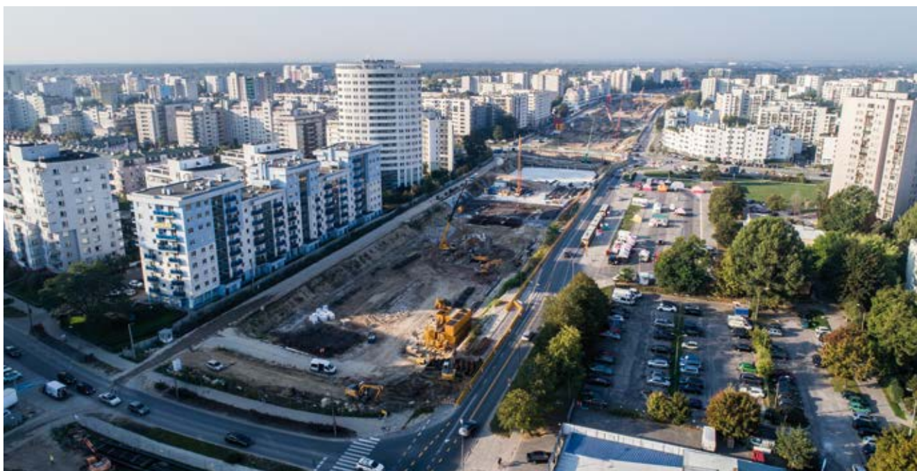
Fot. 3. Budowa tunelu POW w centrum Ursynowa
