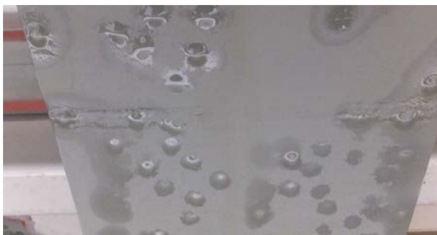
Fot. 2. Kondensacja pary wodnej na konstrukcji
