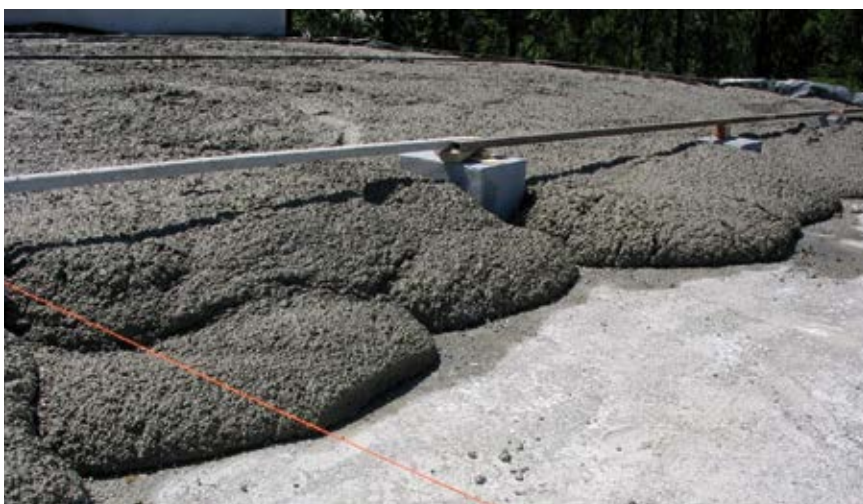
Rys. 7. Kształtowanie spadku stropodachu z użyciem lekkiej zaprawy styropianobetonowej [5]
