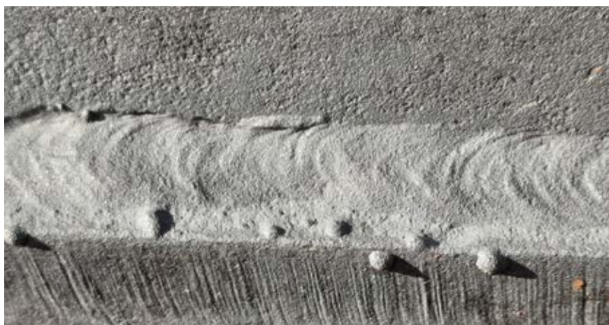
Fot. 3. Wady przygotowania wskazane do usunięcia przez inspektora ds. antykorozyjnych
