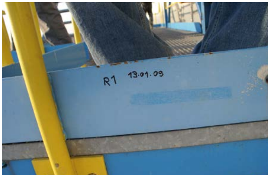
Fot. 7. Kredowanie powłoki nawierzchniowej
