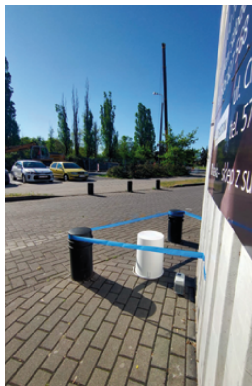
Fot. 2. Monitoring budynku – niewłaściwie umiejscowiony czujnik pomiarowy
