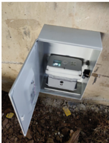
Fot. 3. Czujnik drgań zainstalowany w skrzynce zabezpieczającej przed przypadkowymi uderzeniami
