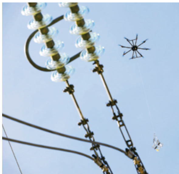
Wykorzystanie dronów w budownictwie elektroenergetycznym
