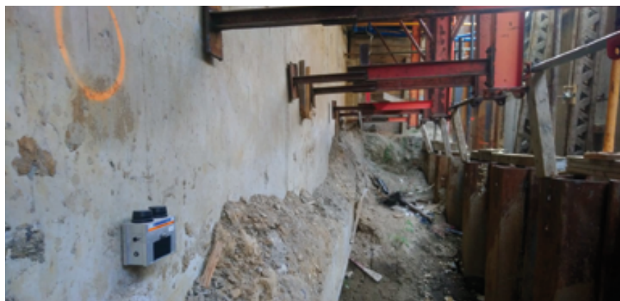
Fot. 4. Pomiar drgań budynku podczas prac budowlanych w bezpośrednim sąsiedztwie
