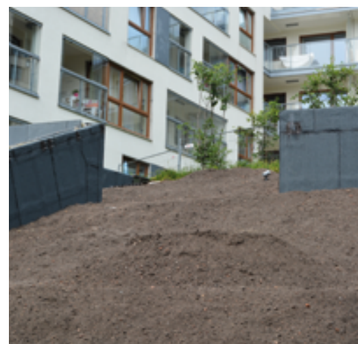
Fot. 2. Dach intensywny na tarasie przechodzi w dach ekstensywny na skarpie
