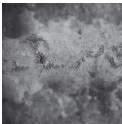
Fot. 2. Zaawansowany proces krystalicznego uszczelniania rysy
