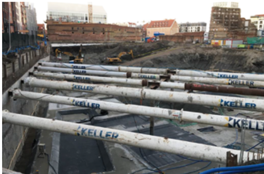
Fot. 3. Uszczelnienie produktem Hydrostop-Mata Penetrująca płyty dennej budowli na Wyspie Spichrzów przy rzece Motława w Gdańsku (wysoki poziom wód gruntowych)
