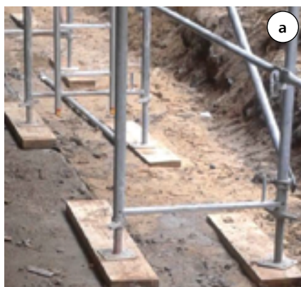
Fot. 2. Skrajnie różne warunki posadowienia rusztowania w kierunku prostopadłym do elewacji: a) posadowienie w obrębie stropu garażu podziemnego, b) posadowienie w obrębie opaski budynku
