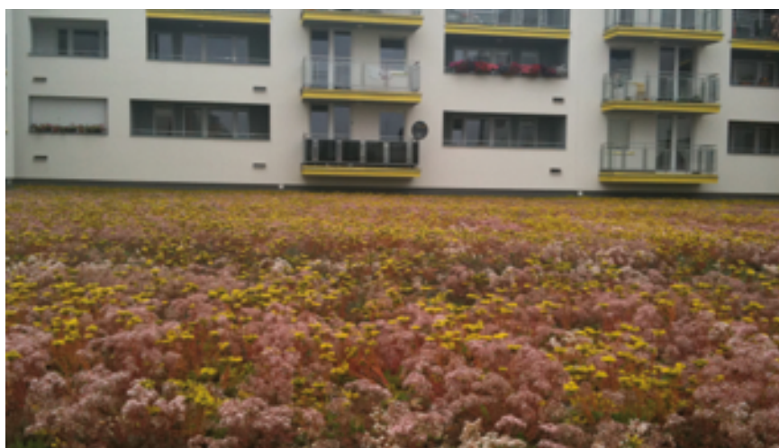
Fot. 7. Dach zielony ekstensywny nieużytkowy jako zadarnienie stropu nad garażem podziemnym
