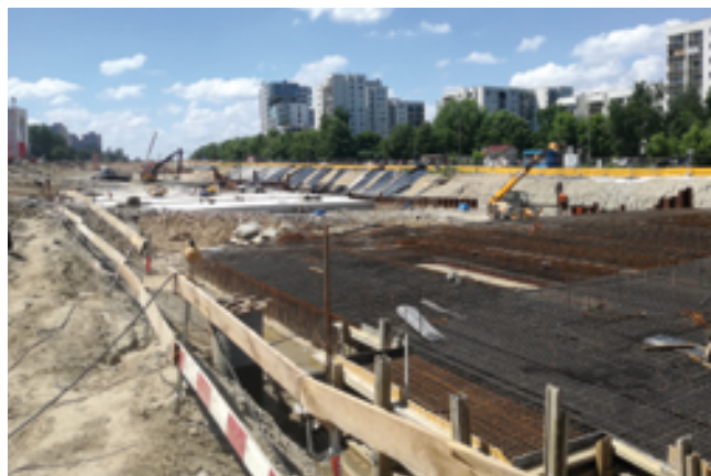
Fot. 2. Płyta stropowa tunelu
