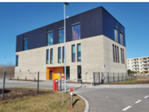
Fot. 7. Budynek Centrum Zarządzania Tunelem
