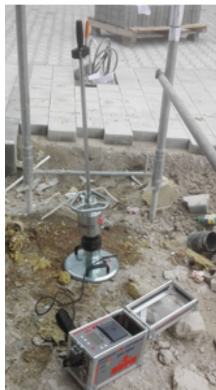
Fot. 3. Badanie podłoża płytą dynamiczną VD
