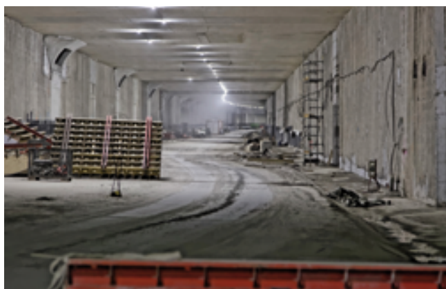
Fot. 5. Nawa ruchowa w kierunku zachodnim – stan surowy
