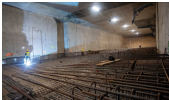
Fot. 4. Zbrojenie płyty dennej
