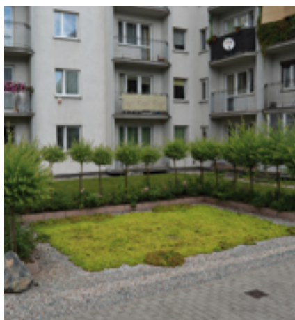
Fot. 5. Wyspa z roślinnością ekstensywną w żwirze obok chodnika na stropie
