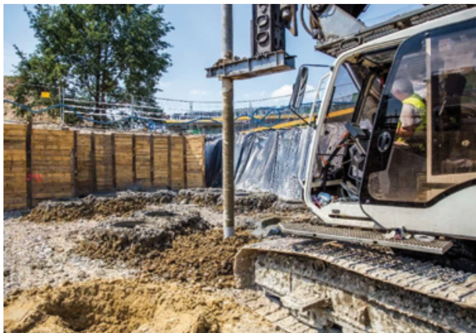
Fot. 1. Zabezpieczenie wykopu obudową oraz membraną
