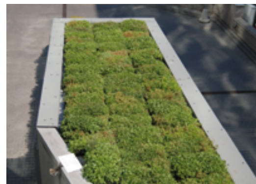
Fot. 4. Dach ekstensywny wykonany przy zastosowaniu gotowych, zazielenionych kulek
