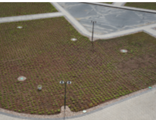
Fot. 8. Roślinność ekstensywna na stropie garażu podziemnego w obszarze użytkowym
