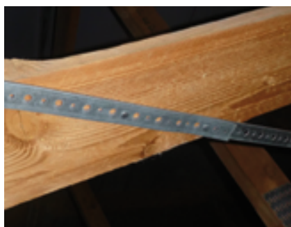
Fot. 10. Połączenie taśm na długości przez przybicie do deski stężenia
