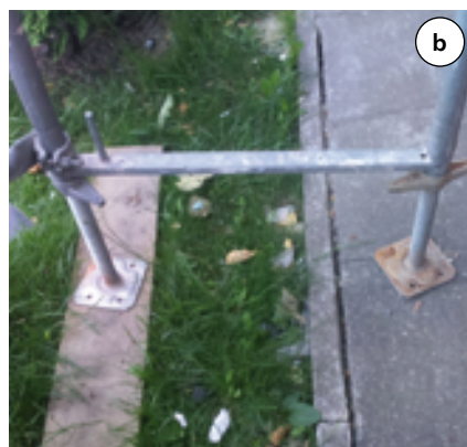
Fot. 2. Skrajnie różne warunki posadowienia rusztowania w kierunku prostopadłym do elewacji: a) posadowienie w obrębie stropu garażu podziemnego, b) posadowienie w obrębie opaski budynku
