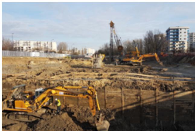
Fot. 1. Prace ziemne
