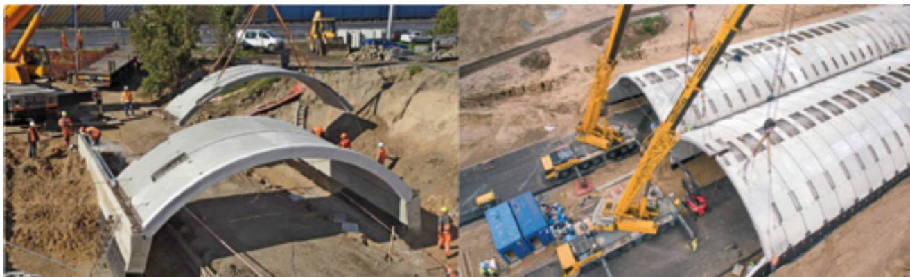
Fot. 1. Przykłady wykorzystania prefabrykatów łukowych do budowy obiektów mostowych (źródło: https://optem.pl/ )
