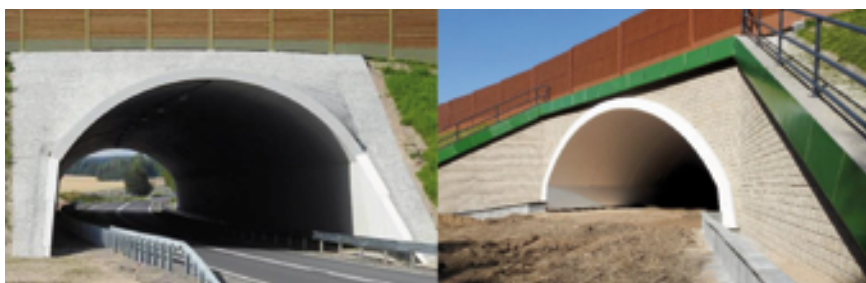
Fot. 6. Prefabrykaty łukowe wbudowane w rzeczywiste obiekty mostowe (źródło: https://optem.pl/ )
