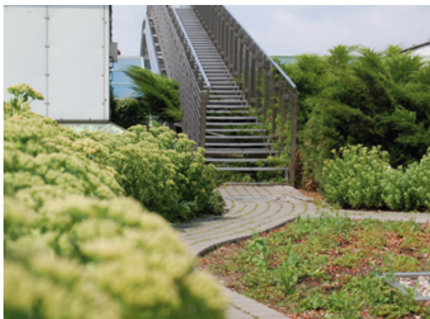
Fot. 6. Wyspa z roślinnością ekstensywną w chodniku na dachu intensywnym
