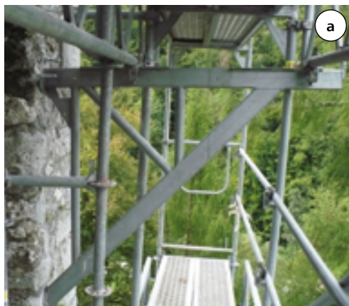
Fot. 4. Rusztowanie podwieszone: a) wspornik, b) oparcie na wsporniku między węzłami dźwigara, c) zawieszenie stojaka na dźwigarze na jednym złączu
