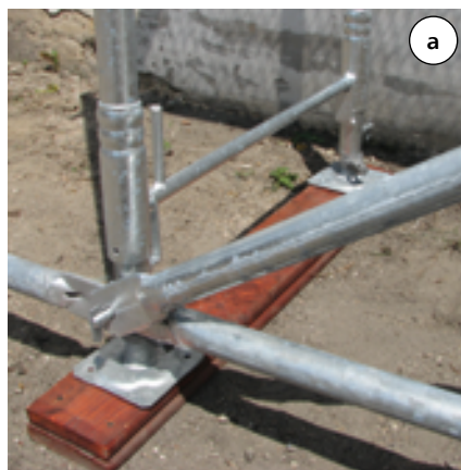
Fot. 1. Posadowienie na gruncie: a) prawidłowe, b) nieprawidłowe
