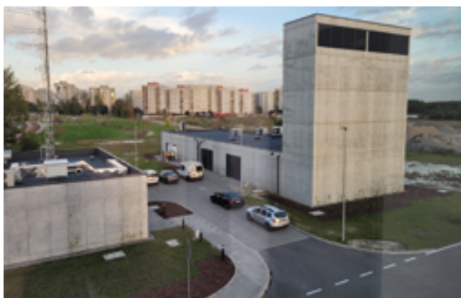
Fot. 6. Zachodnia stacja wentylatorów
