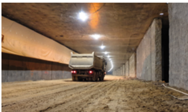
Fot. 3. Wydobywanie gruntu spod płyty stropowej
