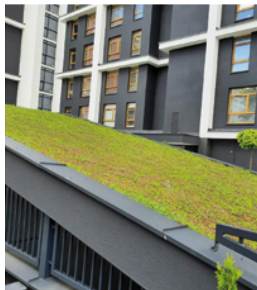
Fot. 1. Dach ekstensywny nad wjazdem do garażu podziemnego
