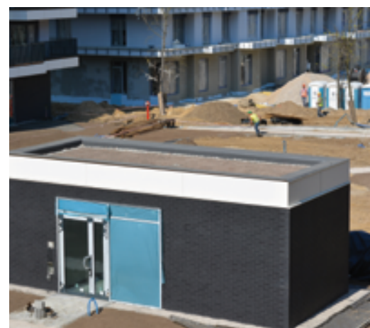
Fot. 3. Mały dach ekstensywny na obiekcie usytuowanym na stropie garażu podziemnego
