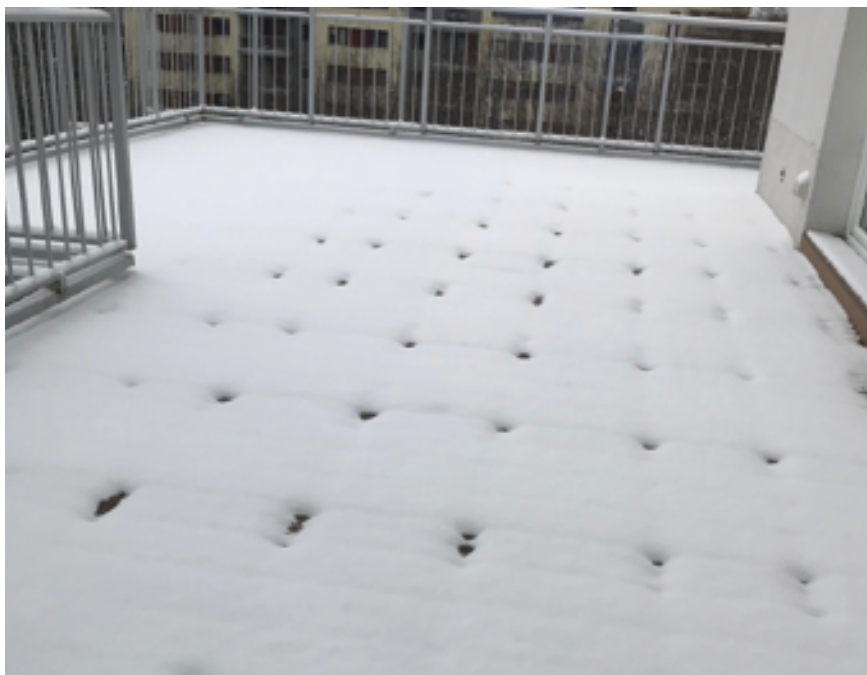
Fot. 1. Skutek mostków termicznych – punktowe topnienie śniegu, opis w tekście
