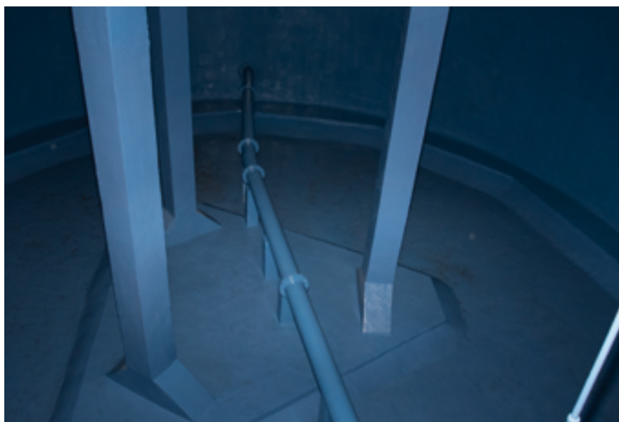
Fot. 4. Zbiorniki po renowacji z zastosowaniem powłoki żywicznej
