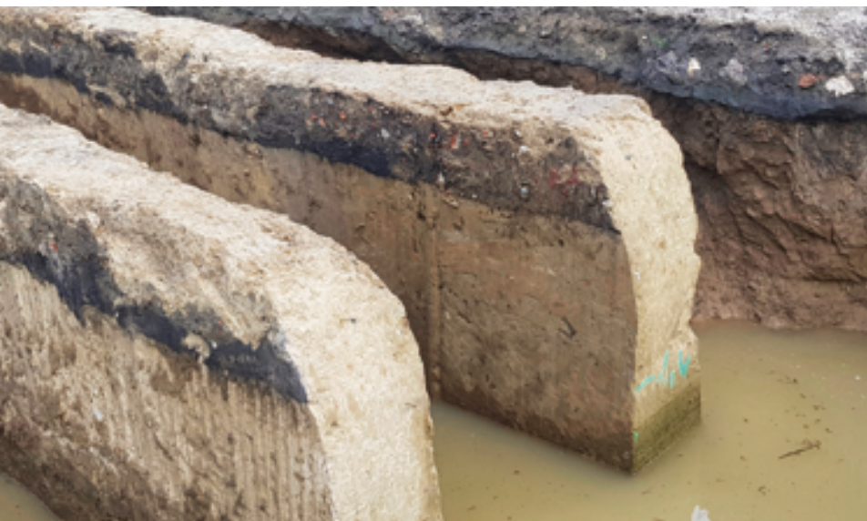
Odkopane ściany DLM wykonane narzędziem Grunwald
