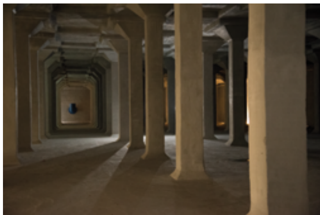
Fot. 3. Zbiorniki po renowacji z zastosowaniem powłok mineralnych
