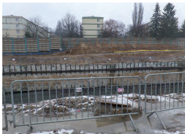
Fot. 3. Balustrady ochronne na krawędzi wykopu
