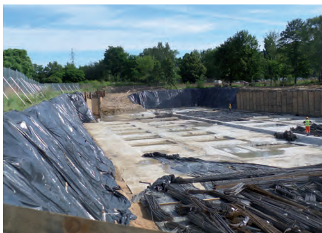
Fot. 2. Zabezpieczenie ścian wykopów przed osunięciem gruntu
