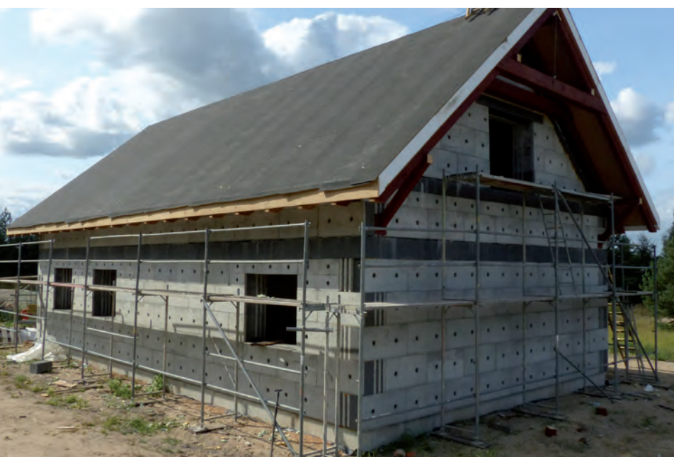
Fot. 2. Budynek wykonany z wielkowymiarowych elementów murowych EKOBLOK
