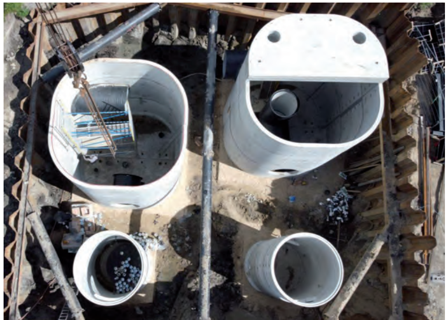
Fot. 1. Układ dwóch osadników wirowych dwukomorowych z komorą zatrzymania części pływających EOW-2L w czasie montażu na budowie w Chojnicach; przepustowość nominalna układu urządzeń – 1120 \text{ dm}^3/\text{s} ( 2 \times 560 \text{ dm}^3/\text{s} ), przepustowość maksymalna układu urządzeń – 11\,200 \text{ dm}^3/\text{s} ( 2 \times 5600 \text{ dm}^3/\text{s} )
