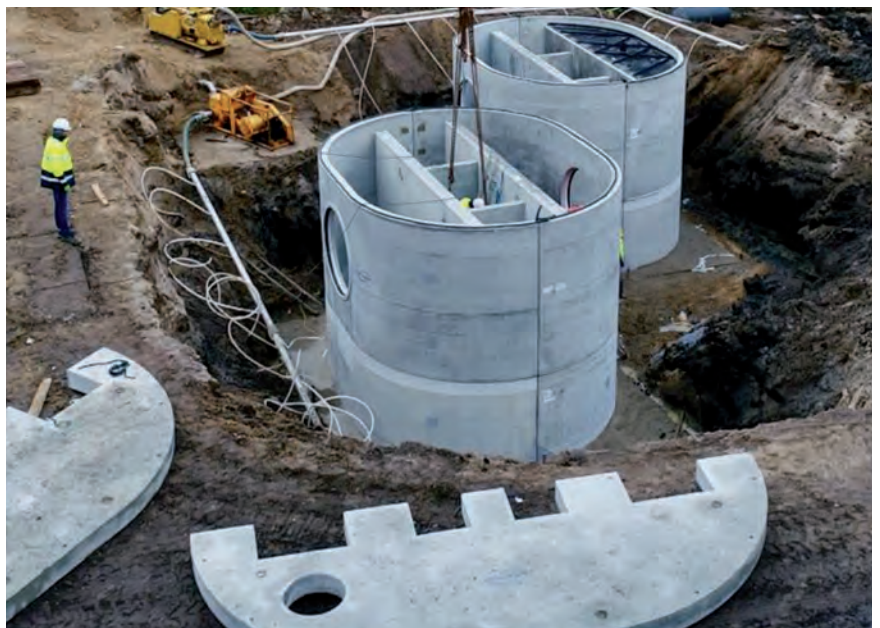
Fot. 2. Układ dwóch lamelowych separatorów substancji ropopochodnych ESL-Z w czasie montażu na budowie w Chojnicach; przepustowość nominalna układu urządzeń – 1120 \text{ dm}^3/\text{s} ( 2 \times 560 \text{ dm}^3/\text{s} ), przepustowość maksymalna układu urządzeń – 11\,200 \text{ dm}^3/\text{s} ( 2 \times 5600 \text{ dm}^3/\text{s} )
