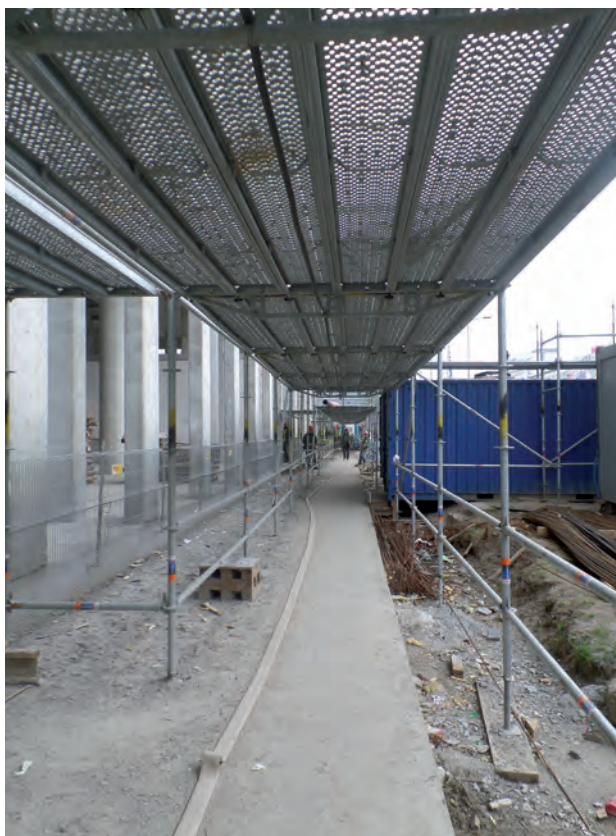
Fot. 4. Zadaszenie ciągu dla pieszych pracowników na terenie budowy
