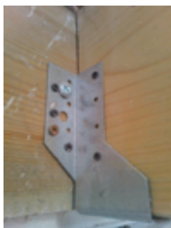
Fot. 2. Niepoprawne łączniki do złączy: gwoździe, wkręt do płyt g-k, wkręt do drewna, gwoździe pseudopierścieniowy
