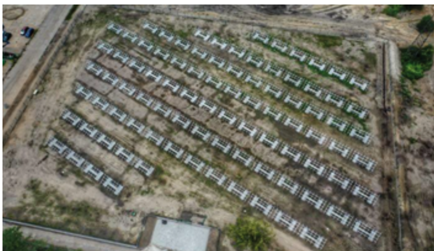
Fot. 3. Laguny osadowe po rekultywacji
