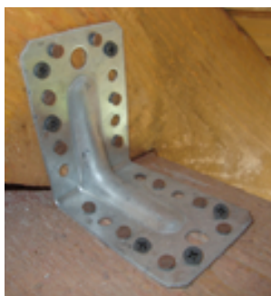
Fot. 1. Błędnie zamontowane złącza ciesielskie
