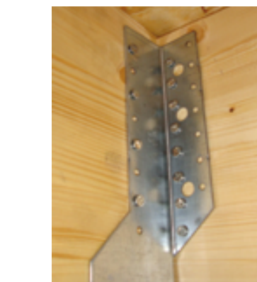
Fot. 4. Złącza zamontowane zgodnie ze schematami gwoździowania częściowego
