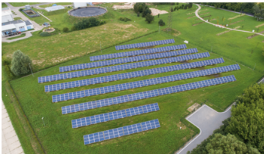
Fot. 1. Farma fotowoltaiczna oczyszczalni ścieków w Chrzanowie Dużym
