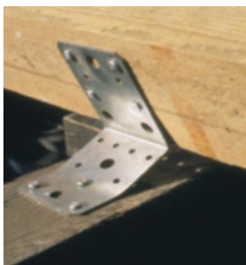
Fot. 5. Montaż niezgodny ze schematami gwoździowania częściowego
