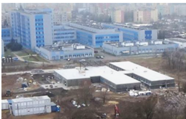
Fot. 4. Realizacja oddziału szpitalnego na potrzeby zapobiegania i przeciwdziałania Covid-19 przy Wojewódzkim Szpitalu Specjalistycznym w Legnicy. Oddział wykonany w technologii modułowej, zaprojektowanie, zrealizowanie i przekazanie go użytkownikowi zajęło zaledwie dwa miesiące od podpisania umowy [4] ( www.szpital.legnica.pl )
