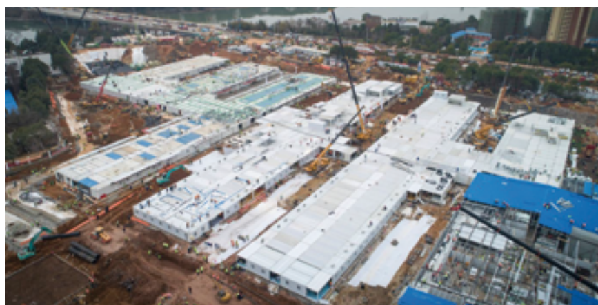
Fot. 3. Budowa kontenerowego szpitala w Wuhan, 2020 r. (www.timesofisrael.com)
