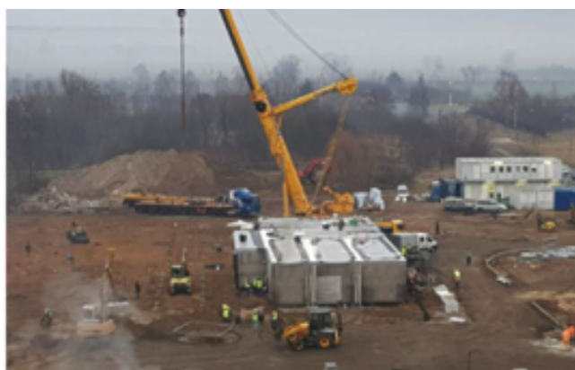
Fot. 4. Realizacja oddziału szpitalnego na potrzeby zapobiegania i przeciwdziałania Covid-19 przy Wojewódzkim Szpitalu Specjalistycznym w Legnicy. Oddział wykonany w technologii modułowej, zaprojektowanie, zrealizowanie i przekazanie go użytkownikowi zajęło zaledwie dwa miesiące od podpisania umowy [4] ( www.szpital.legnica.pl )
