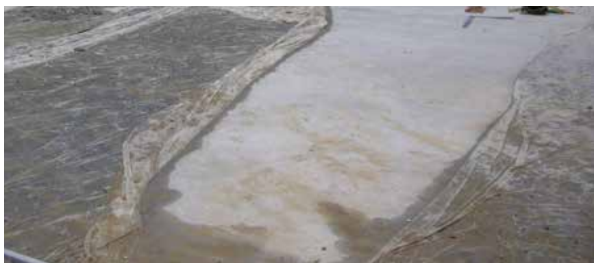
Fot. 3. Wadliwa pielęgnacja płyty
