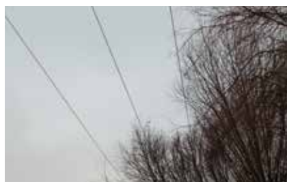
Fot. 3. Gałęzie drzew podczas deszczu i silnego wiatru dotykają kabli linii energetycznej średniego napięcia
