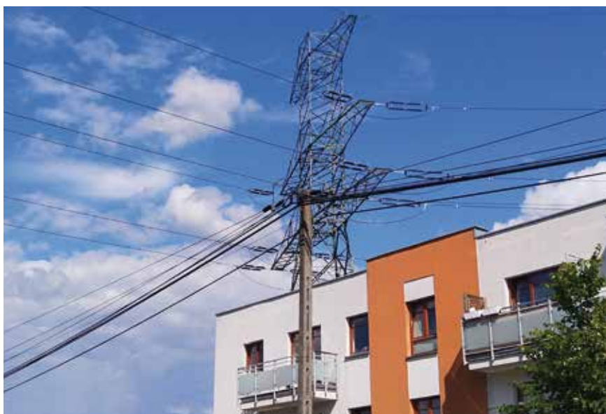
Fot. 2. Linie napowietrzne energetyczne wysokiego napięcia i telekomunikacyjne
