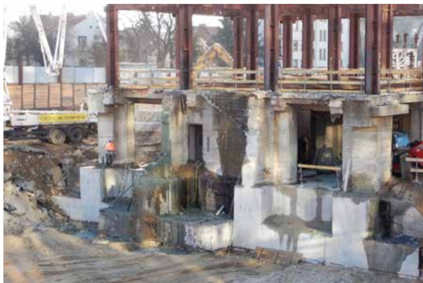
Fot. 3. Odsłonięta skrzynia fundamentowa części „A” – dawnego „Szkieleto”. Wiertnice wjeżdżają na pierwszy poziom skrzyni i wykonują otwory przez płytę, tak aby możliwa była iniekcja jet grouting (archiwum STRABAG)
