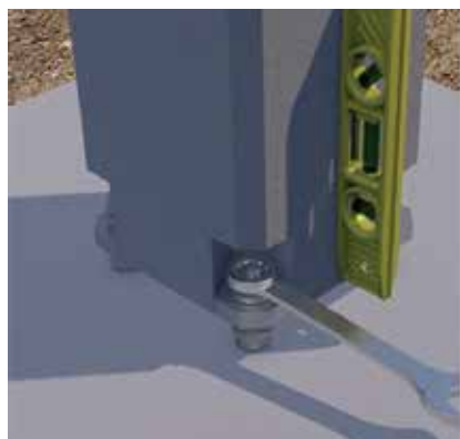
Rys. 1. Rektyfikacja i zalewanie zaprawą słupa prefabrykowanego
