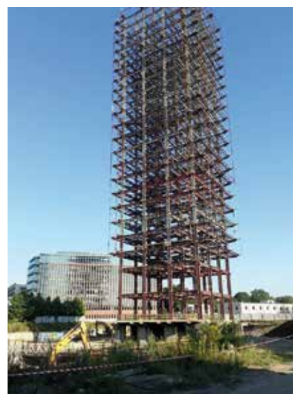
Fot. 2. Stan obiektu na dzień przejścia placu budowy
