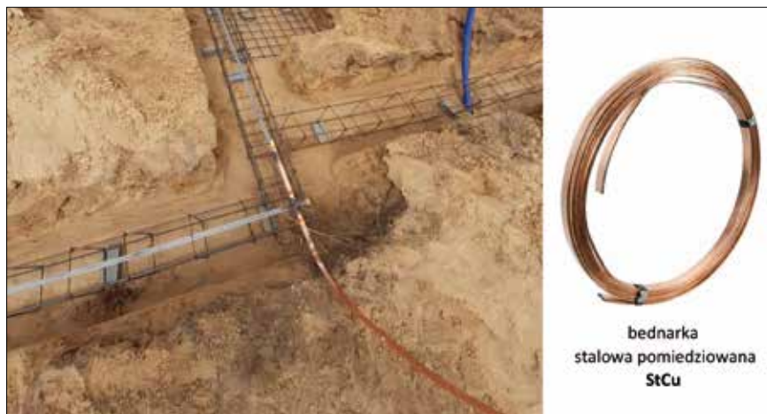
Rys. 1. Prawidłowy dobór materiałów uziomu fundamentowego – sztuczny uziom fundamentowy wykonany z bednarki ze stali czarnej, połączonej ze zbrojeniem, oraz z wyprowadzeniem do ziemi przewodów uziemiających wykonanych z bednarki pomiedziowanej
