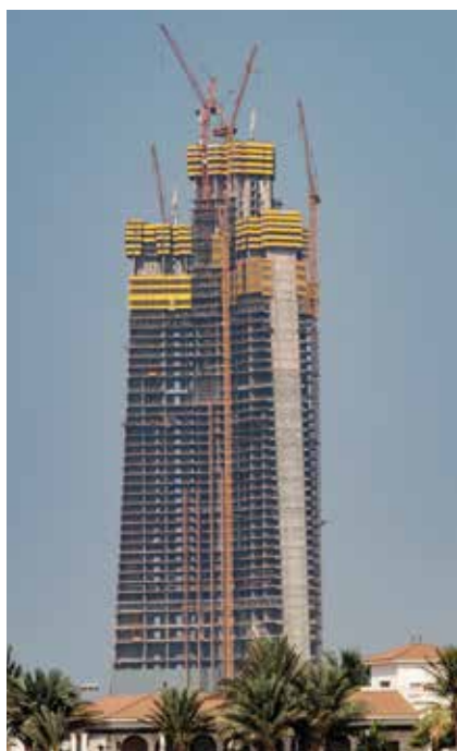
Fot. 4. Budowa The Jeddah Tower, Arabia Saudyjska, 2019 (fot. © leo morgen – stock.adobe.com)
