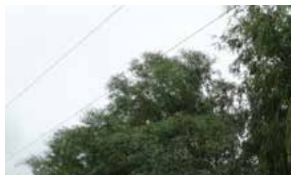
Fot. 4. Przyrost długości gałęzi drzew w krótkim czasie jest na tyle duży, że trzeba je dość często sprawdzać i w razie konieczności przycinać. Trzeci przewód na dole między gałęziami
