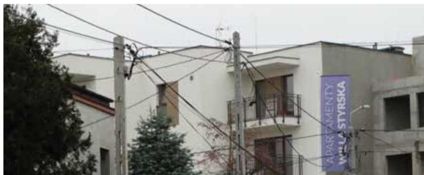
Fot. 5. Rosnąca liczba kabli podwieszonych do słupów energetycznych
