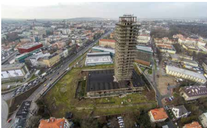
Fot. 1. „Szkieletor” przed pracami rozbiórkowymi, 2017 r.
