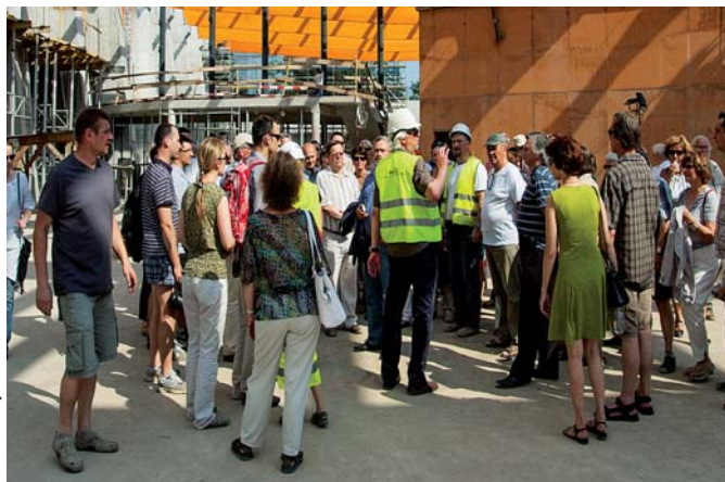
Wycieczka na budowę Afrykarium, Wrocław, czerwiec 2013
