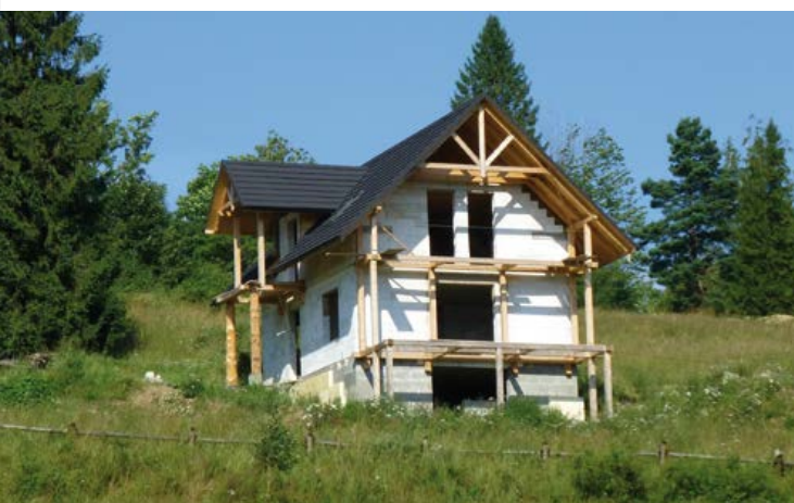
Fot. 3. Zbudowany w górskiej okolicy dom ma ściany wymurowane z bloczków betonu komórkowego oraz żelbetowe, monolityczne stropy
