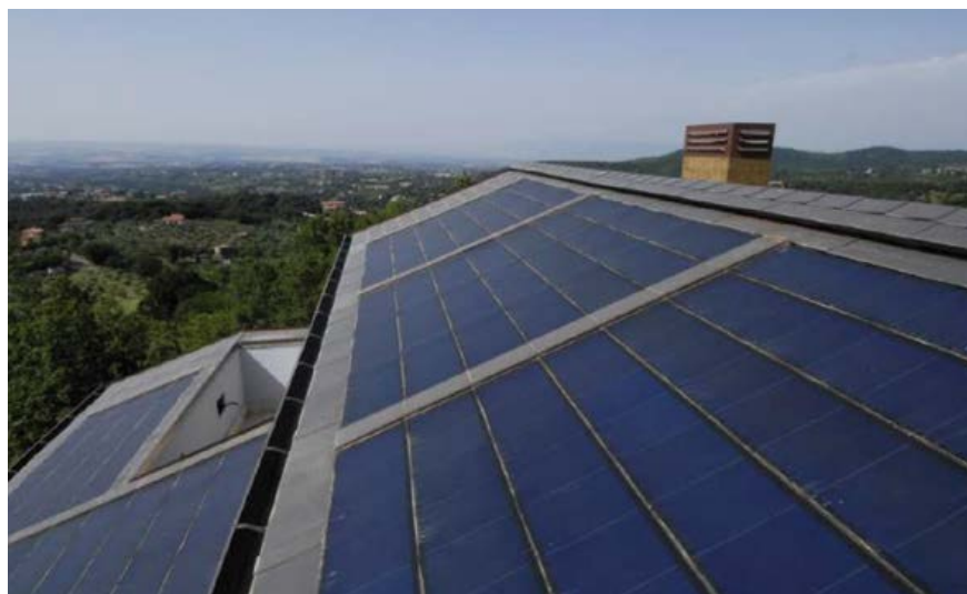
Fot. 4. Przykład dachówki solarnej (źródło własne)
