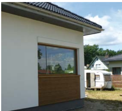
Fot. 9. Zamiast naturalnego drewna do wykonania detali elewacyjnych można użyć drewnopodobnych, elastycznych okładzin plastikowych
