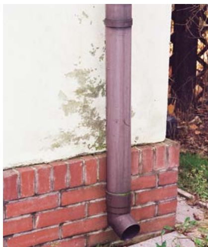
Fot. 16. Za niszczenie elewacji może też odpowiadać zatkana rura spustowa – pomagają jej w tym wysunięte cokoły źle sprawdzające się w polskich warunkach klimatycznych
