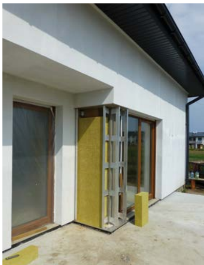
Fot. 8. Detale z naturalnych desek montuje się na metalowym ruszcie i ociepla wełną mineralną
