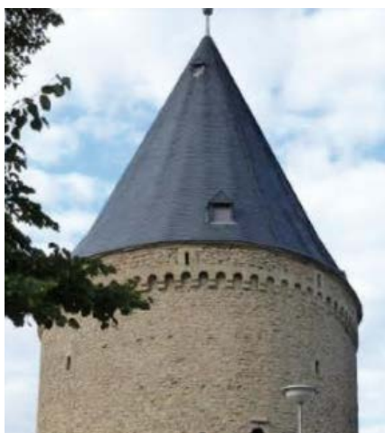
Fot. 3. Przykład przekrycia wieży z dachówki łupkowej (źródło własne)
