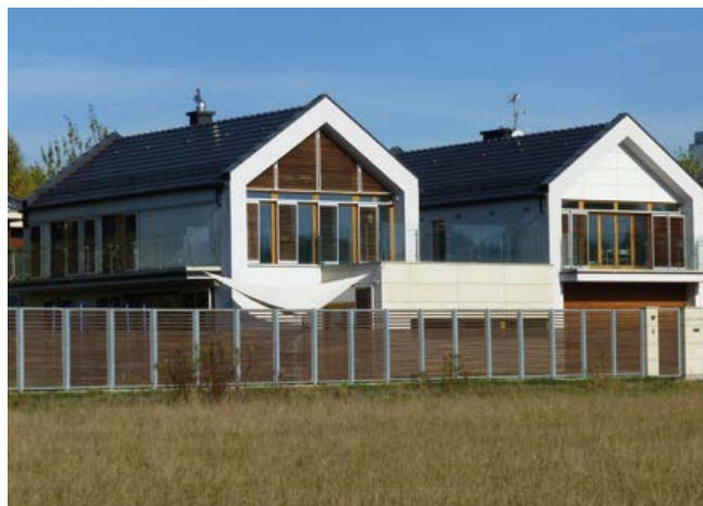
Fot. 2. Podobnie jest z elewacjami domów o prostej, modernistycznej architekturze
