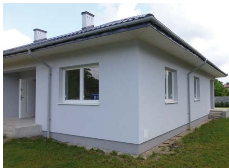
Fot. 6. Elewacja ścian ocieplonych metodą ETICS powinna być zawsze wykonywana z materiałów jednego producenta
