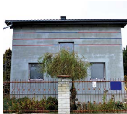
Fot. 12. W elewacjach ścian jednowarstwowych wykonanych tynkiem cienkowarstwowym bez problemów da się wykonać na przykład boniowanie
