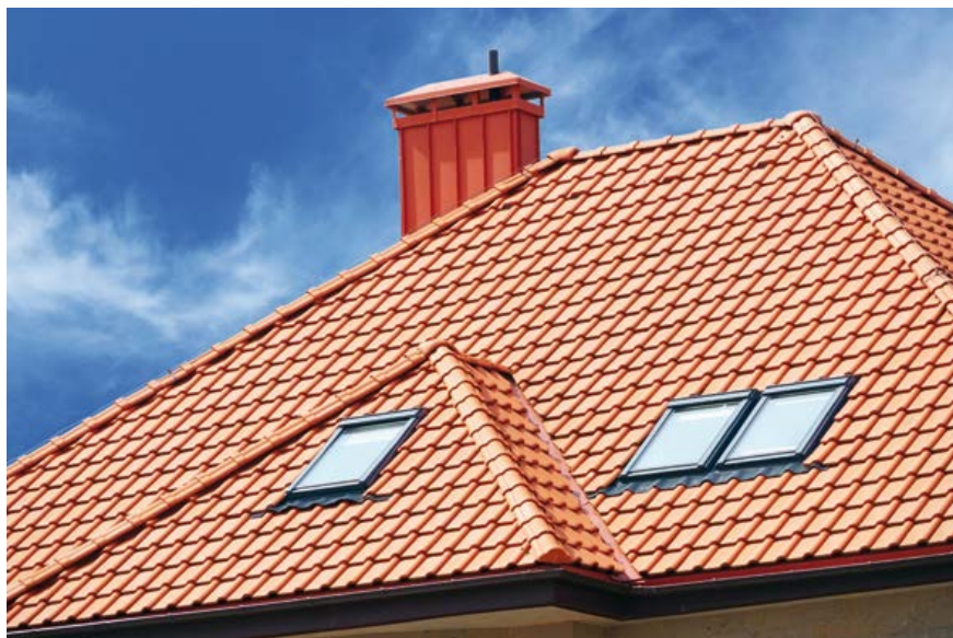
Fot. 1. Dach wykonany dachówką ceramiczną
