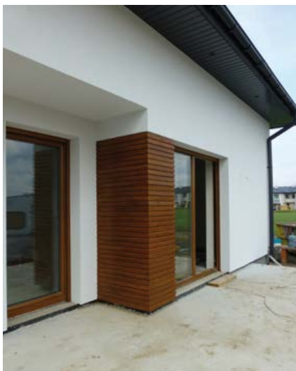
Fot. 7. Elewacje ścian ocieplonych styropianem bardzo uszlachetniają drewniane detale
