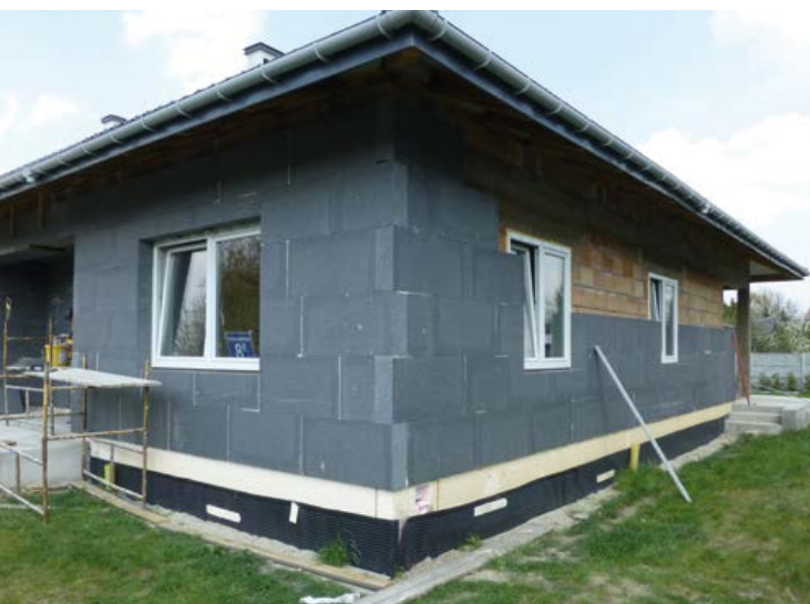
Fot. 5. Nawet gdy dom ma ściany z „suchych” pustaków ceramicznych, z ich ocieplaniem lepiej się nie spieszyć
