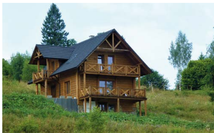
Fot. 4. Po wykonaniu elewacji dom murowany zmienia się w drewniany, dużo lepiej pasujący do krajobrazu i miejscowej architektury
