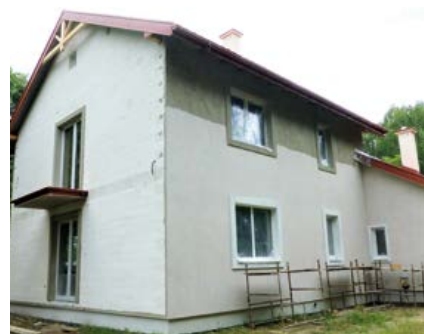
Fot. 11. Elewacje ścian jednowarstwowych najlepiej wykonać z tynku cienkowarstwowego, układanego na podkładzie zbrojonym plastikową siatką
