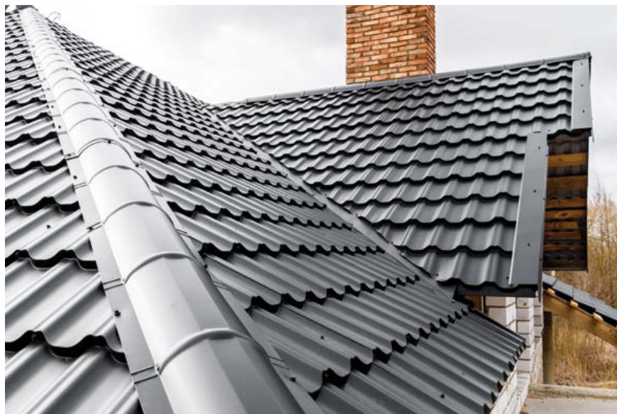
Fot. 2. Poszycie dachu z blachodachówki wraz z obróbką blacharską
