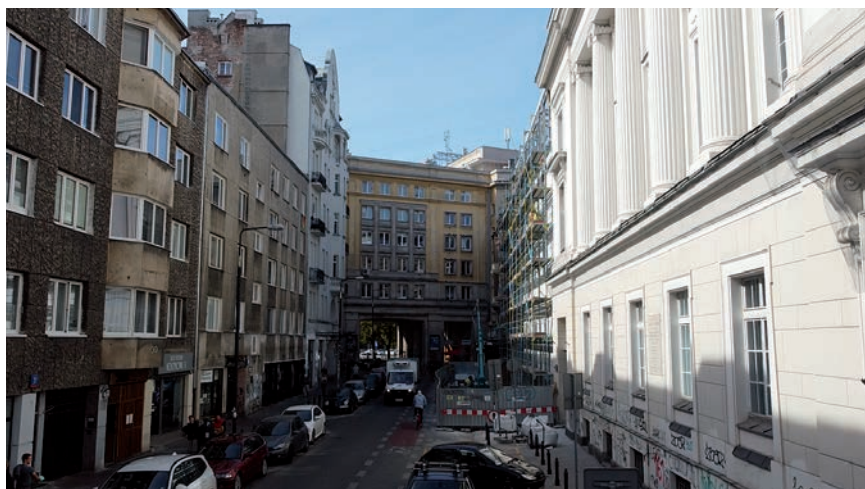
Fot. 1. Pas chodnika wygradzony na potrzeby dźwigu i składowania materiałów (fot. dzięki uprzejmości mgr. inż. Łukasza Krynickiego ze SPIE Building Solutions – pełniącego obowiązki kierownika robót elektrycznych podczas realizacji prac w Bibliotece Publicznej m.st. Warszawy – Bibliotece Głównej Województwa Mazowieckiego)
