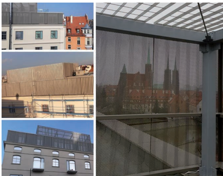
Fot. 5. Wygląd okładziny perforowanej zależnie od miejsca obserwacji
