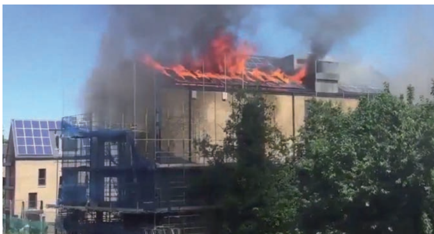
Fot. 2. Pożar paneli PV zamontowanych na dachu [12]
