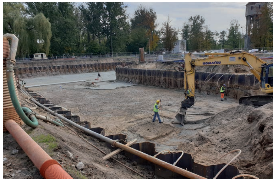
Fot. 3. Realizacja wykopu w zabezpieczeniu ścianki szczelnej z igłofiltrami
