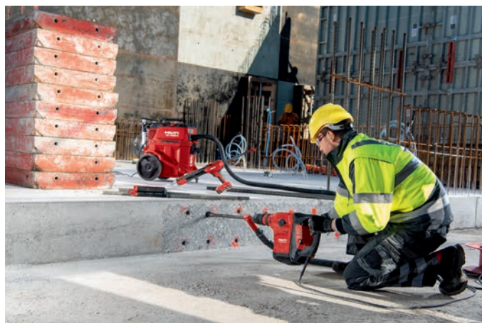
Przykład wykonania kotwienia wklejanych prętów zbrojeniowych z wykorzystaniem systemu bezpiecznego montażu Hilti SafeSet
