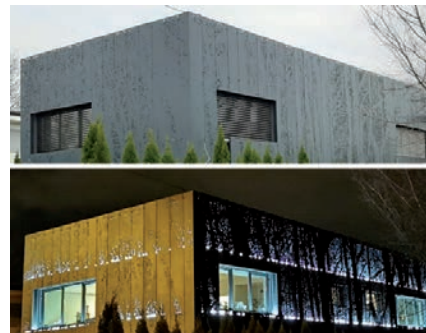
Fot. 3. Elewacja w świetle dziennym oraz po podświetleniu
