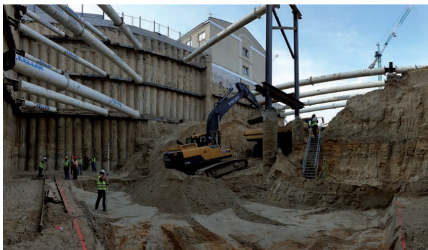
Fot. 7. Realizacja głębokiego wykopu do 16 m z trzema poziomami rozparcia – budowa SPSK1 w Lublinie
