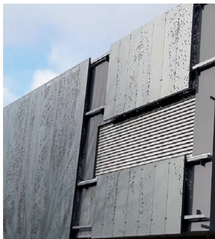
Fot. 8. Zabezpieczenie termoizolacji elewacji perforowanej systemem ETICS
