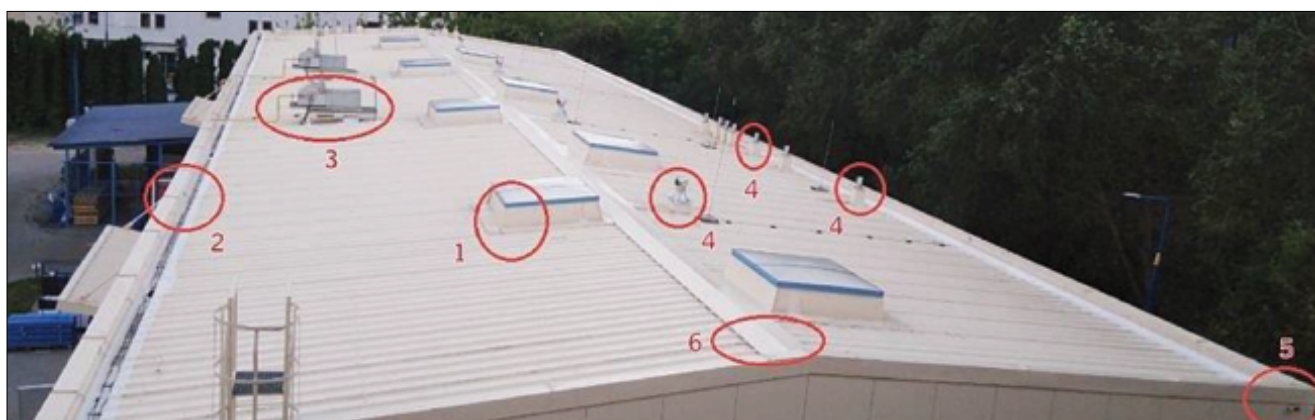
Fot. 3. Przykładowe elementy dachu z płyt warstwowych wymagające szczegółowej kontroli: 1 – osadzenie klapy, 2 – rynny spustowe i połączenie płyty dachowej z attyką, 3 – osadzenie instalacji grzewczo-wentylacyjnej, 4 – osadzenie kominów wentylacyjnych, 5 – rzygacze i przelewy bezpieczeństwa, 6 – obróbki blacharskie w miejscach zmiany kształtu dachu [5]
