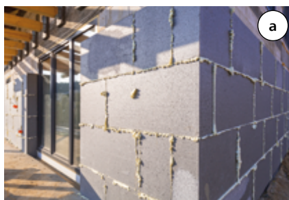
Fot. 1. Przykładowe materiały termoizolacyjne: a) płyty ze styropianu grafitowego, b) płyty PIR, c) płyty z wełny mineralnej
