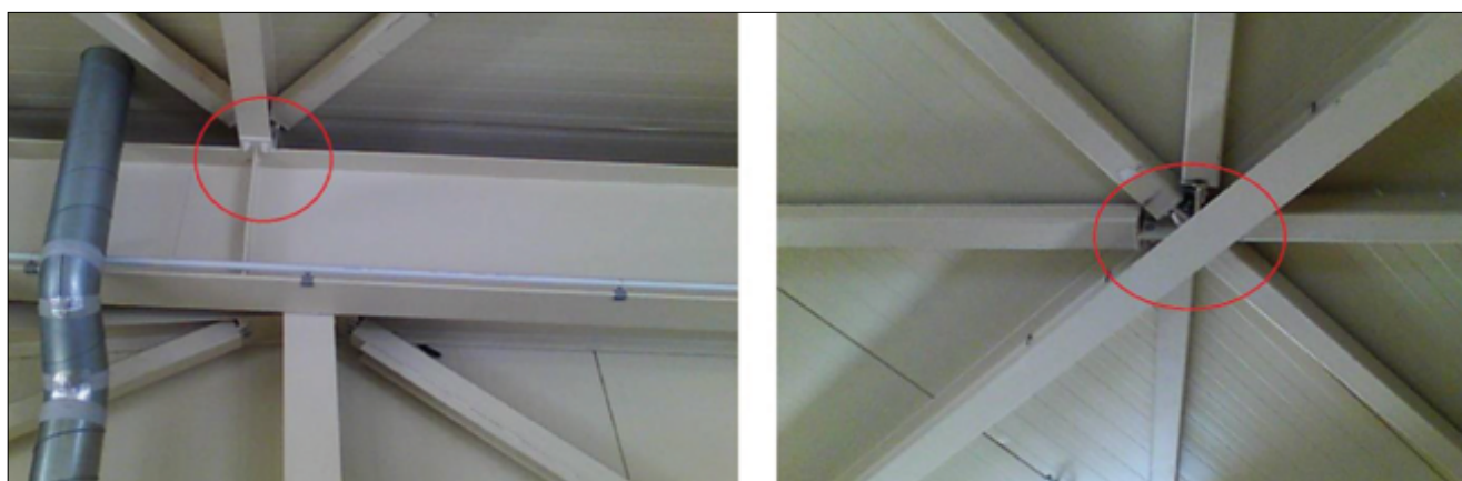
Fot. 4. Węzeł połączenia elementów nośnych stalowej konstrukcji dachu wymagający sprawdzenia połączeń mechanicznych
