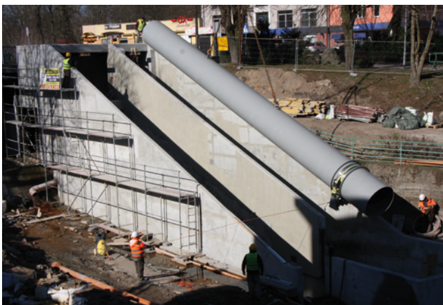
Fot. Prace związane z osadzeniem toru zstępującego (po lewej) i toru wstępującego (po prawej) aktywnej przepławki dla fauny wodnej w Starogardzie Gdańskim (źródło: Instytut OZE)
