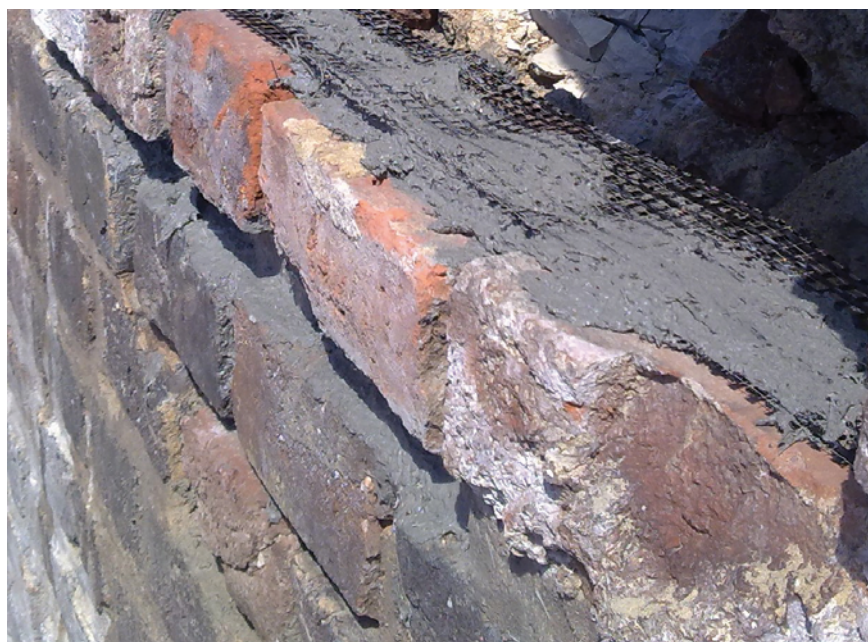
Fot. 1. Siatka z włókien węglowych wzmacniająca spoinę odbudowywanego fragmentu ceglanoego muru
