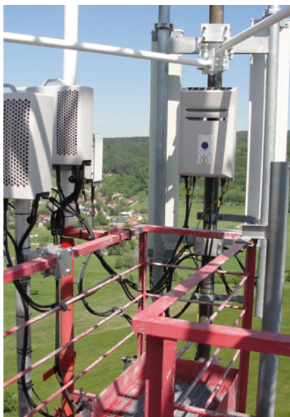
Fot. 5. Mocowanie anten stacji bazowej na wieży
