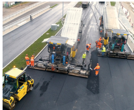
Budowa węzła drogowego w Porosłach w powiecie białostockim. Wyprowadzenie ruchu w kierunku S8 dla inwestycji będącej przedmiotem współpracy z dostawcą w ramach Programu „15 inwestycji z okazji 15-lecia spółki LOTOS Asfalt”
