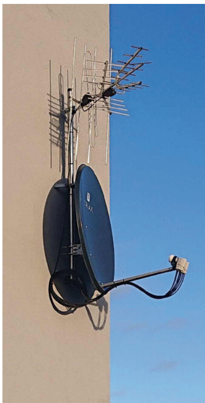
Fot. 1. Montaż zestawu anten: SAT, TV na elewacji budynku wielorodzinnego
