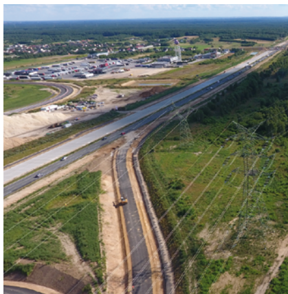
Fot. 1. Słupy linii 220 kV i 400 kV dla usunięcia kolizji przy węzle autostradowym zostały wymienione na wyższe
