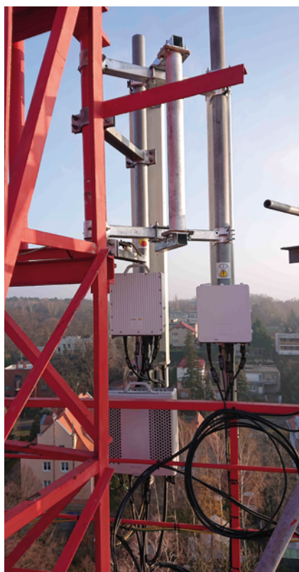
Fot. 6. Jednostki antenowe oraz RRU
