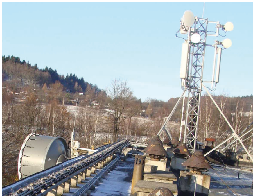
Fot. 7. Stacja bazowa montowana na dachu budynku
