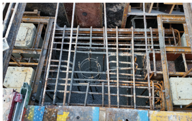
Fot. 2. Specjalna wkładka w szkieletzie zbrojenia do głębokiego wprowadzania węża pompy
