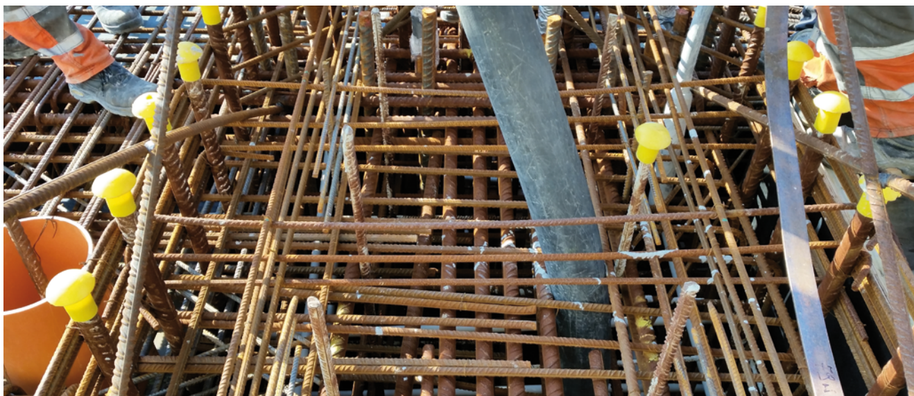
Fot. 3. Proces wbudowywania mieszanki betonowej w elemencie o gęstym układzie prętów w szkieletie zbrojenia
