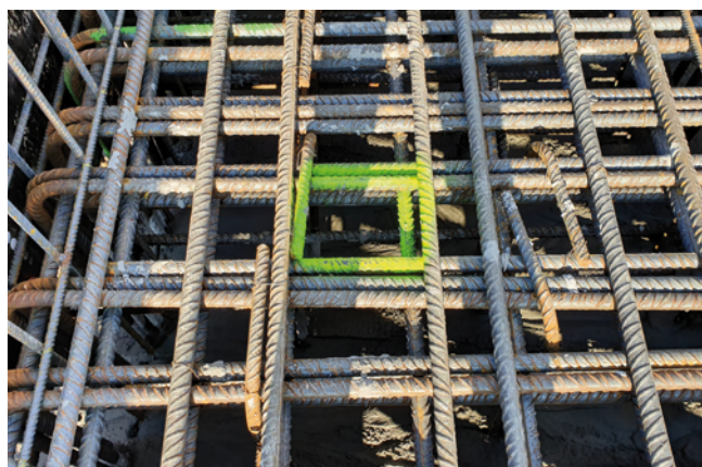
Fot. 1. Przygotowane i oznaczone miejsce wprowadzenia węża pompy do betonu
