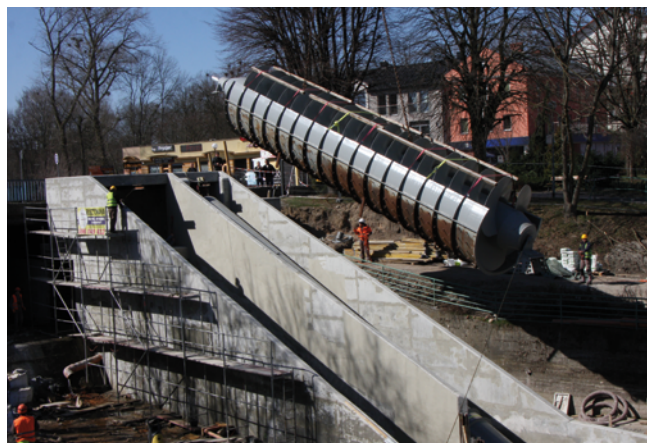
Fot. Prace związane z osadzeniem toru zstępującego (po lewej) i toru wstępującego (po prawej) aktywnej przepławki dla fauny wodnej w Starogardzie Gdańskim (źródło: Instytut OZE)
