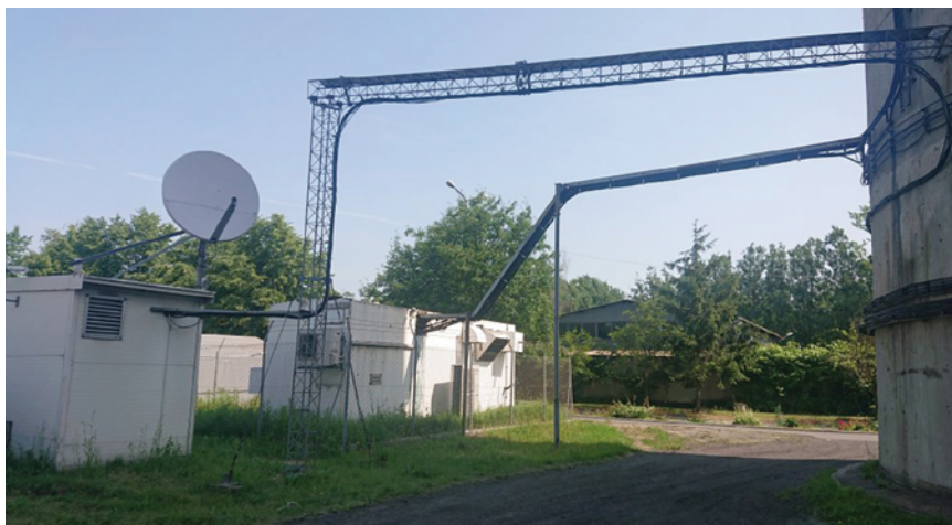
Fot. 11. Most kablowy do kontenera i zadaszenie
