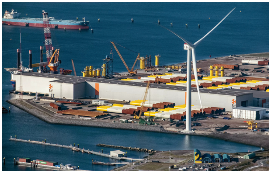
Fot. 4. Największa obecnie na świecie turbina wiatrowa Haliade-X o mocy znamionowej 12 MW podczas eksperymentalnej eksploatacji w porcie w Rotterdamie w Holandii (źródło: materiały prasowe General Electric)
