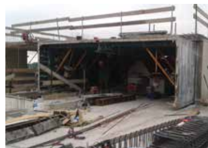
Fot. 13. Wyszukiwanie tunelu i oprysk preparatem antyadhezyjnym
