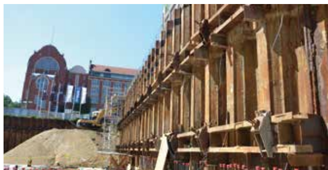
Fot. 1. Zabezpieczenia wykopów AARSLEFF Sp. z o.o.
