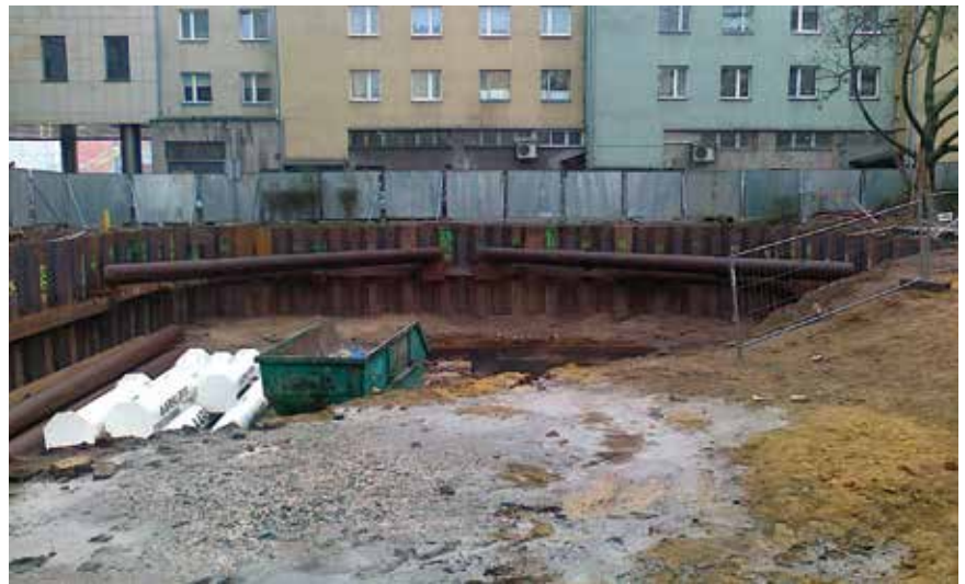
Fot. 1. Wykonanie ścianki szczelnej (wykop wykonywany wciskarką) w ciasnej zabudowie miejskiej – Wrocław, ul. Krawiecka
