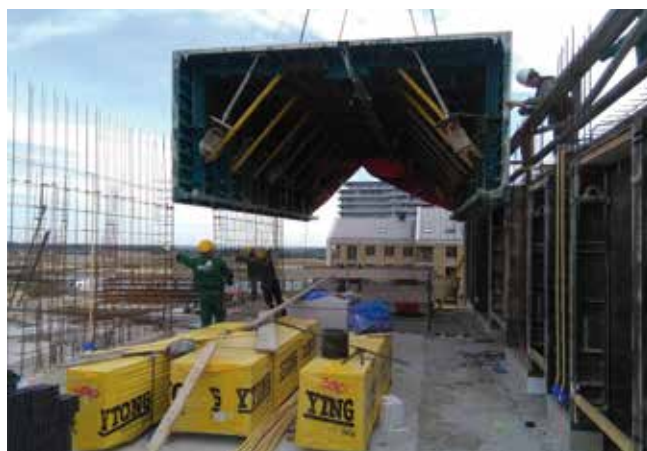
Fot. 5. Montaż segmentu deskowania tunelowego
