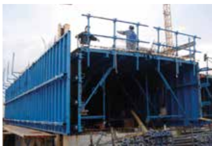
Fot. 1. Widok deskowania tunelowego z tarczą czołową
