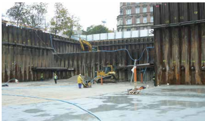
Fot. 4. Elementy obudowy wykopu: ściany, kotwy, rozpory rurowe, ścianki wewnętrzne rozdzielające wykop o zróżnicowanej głębokości, studnie depresyjne z elementami odwodnienia.
