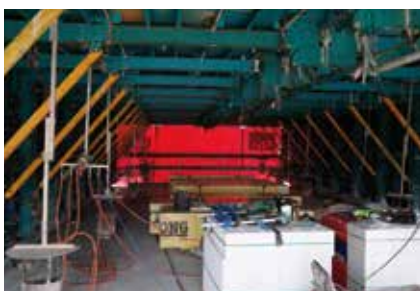
Fot. 9. Zamknięty tunel w trakcie nagrzewania
