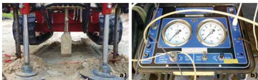
Fot. 2. Badanie dylatometrem płaskim DMT: a) łopatka pomiarowa bezpośrednio przed wciśnięciem w grunt, b) panel do zadawania i pomiaru ciśnienia
