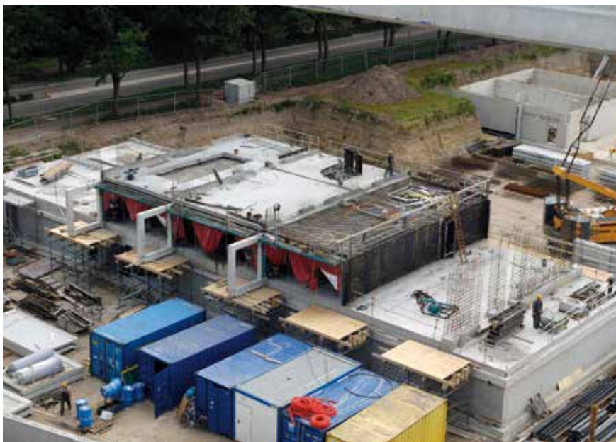
Fot. 8. Kolejne etapy betonowania ścian i stropów
