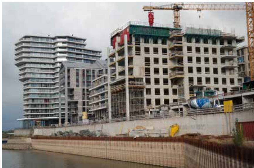
Fot. 2. Przykłady kształtowania architektury w technologii deskowań tunelowych
