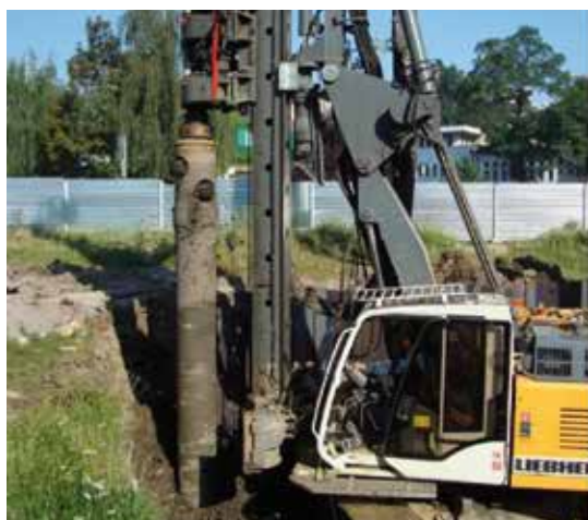
Fot. 6. Zastosowanie wiercenia świdrem ciągłym w osłonie rurowej do rozluźnienia gruntu (świder o średnicy 500 mm, z prowadzeniem, produkcji firmy Liebherr), budowa SKY-TOWER we Wrocławiu.
