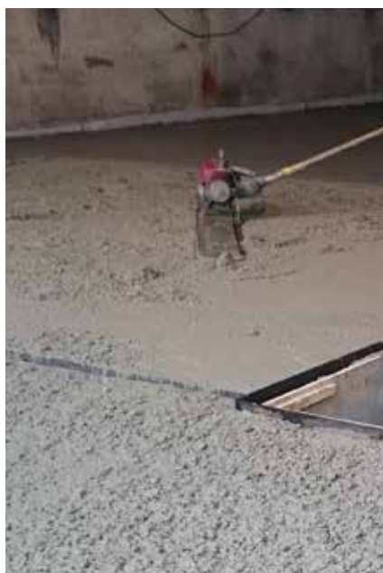
Fot. 1, 2. Proces układania mieszanki betonowej (fot. Lafarge)
