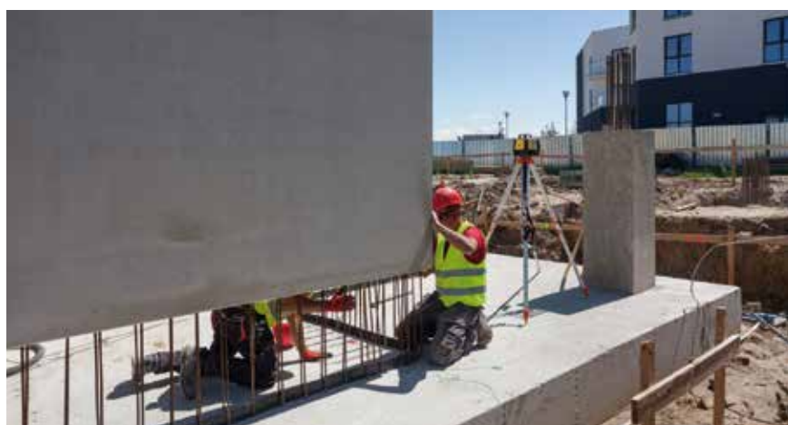
Montaż ściany zespolonej
