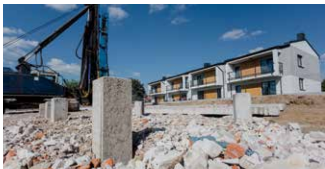
Fot. 3. Fundamenty palowe AARSLEFF Sp. z o.o.
