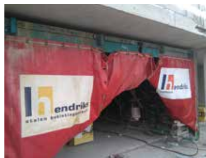
Fot. 12. Widok odspojonego i obniżonego tunelu
