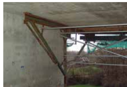
Fot. 16. Montaż pomostów roboczych dla następnej kondygnacji
