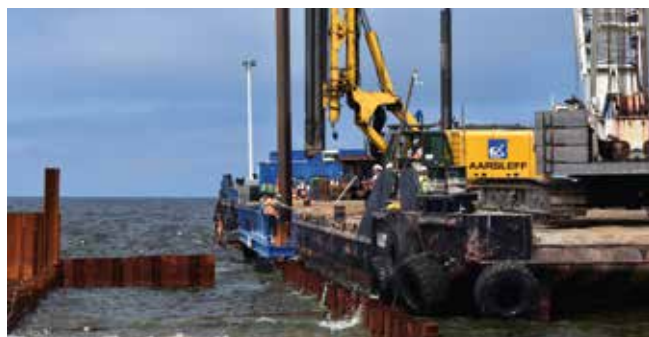
Fot. 4. Roboty hydrotechniczne AARSLEFF Sp. z o.o.
