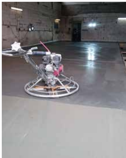
Fot. 3. Proces zacierania powierzchniowego posypki (fot. Lafarge)
