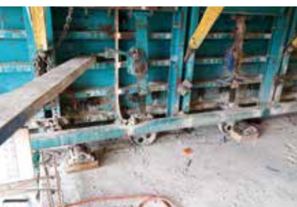
Fot. 11. Obniżenie deskowania tunelowego na rolki jezdne
