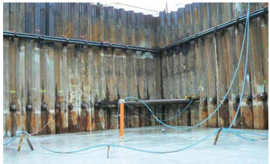
Fot. 2. Głęboki wykop z dwoma różnymi sposobami zakotwień – Wrocław, ul. Sikorskiego
