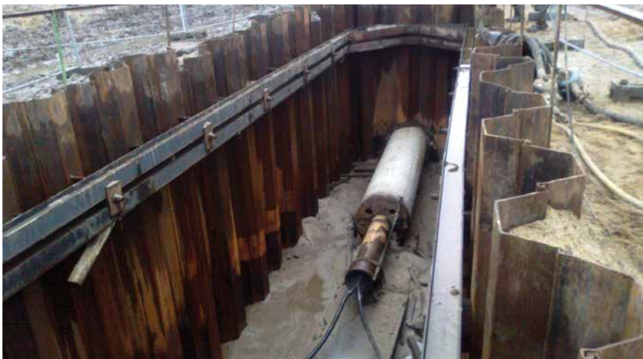
Fot. 5. Obudowa wykopu do realizacji prac przeciskowych przy budowie infrastruktury podziemnej.
