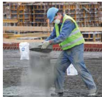
Fot. 3. Aplikacja Hydrostopu podczas formowania spadków stropu
