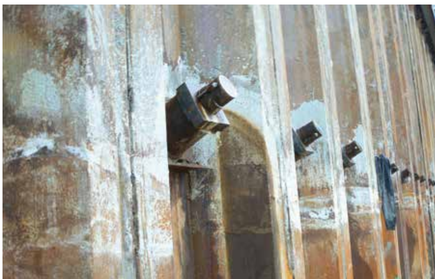
Fot. 3. Szczelne główki zakotwień gruntowych do instalacji poniżej zwierciadła wody gruntowej
