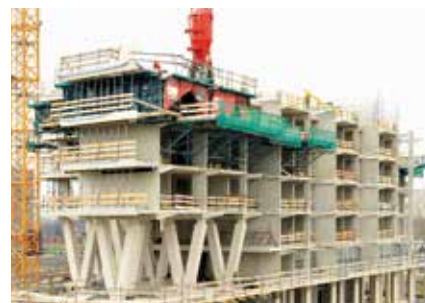
Fot. 7. Betonowanie ścian i stropów przy użyciu pojemników
