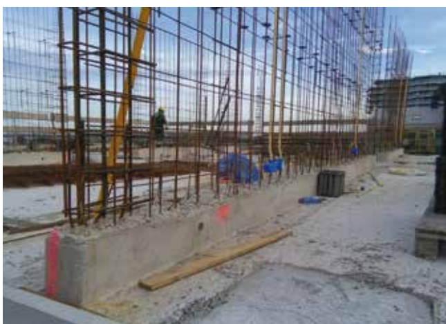
Fot. 4. Zbrojenie ścian i montaż elementów instalacyjnych
