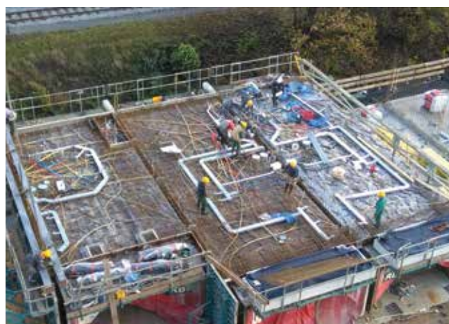
Fot. 6. Widok zazbrajanych stropów
