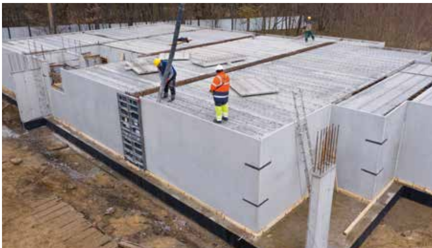
Ściany zespolone zastosowane w kondygnacji garażowej
