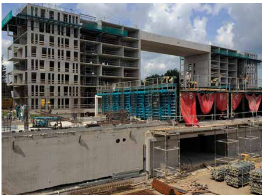
Fot. 15. Przygotowanie deskowań tunelowych na kolejnych działkach
