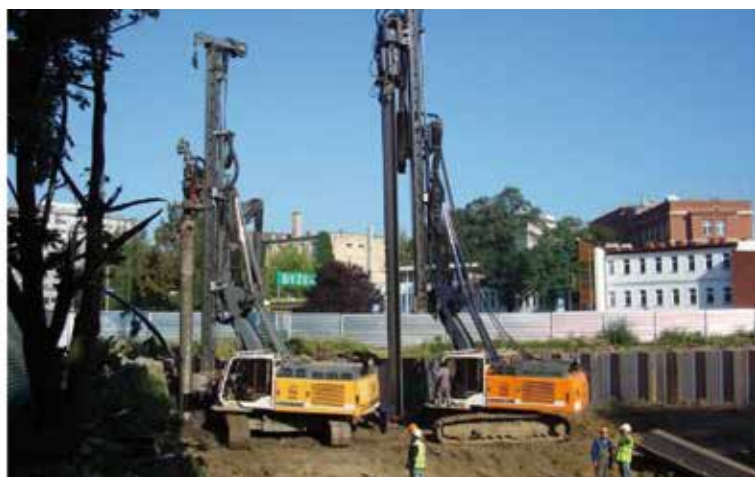
Fot. 6. Zastosowanie wiercenia świdrem ciągłym w osłonie rurowej do rozluźnienia gruntu (świder o średnicy 500 mm, z prowadzeniem, produkcji firmy Liebherr), budowa SKY-TOWER we Wrocławiu.
