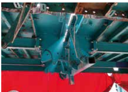
Fot. 10. Zamek tarczy stropowej z opuszczoną listwą domykającą
