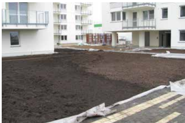
Fot. 1. Patio między budynkami wielorodzinnymi
