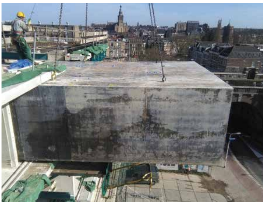
Fot. 14. Transport dźwigowy segmentu poza obrysem budynku
