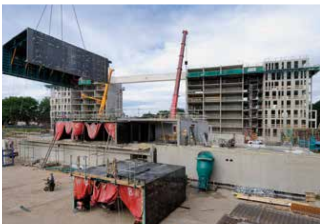
Fot. 3. Transport elementów na plac budowy
