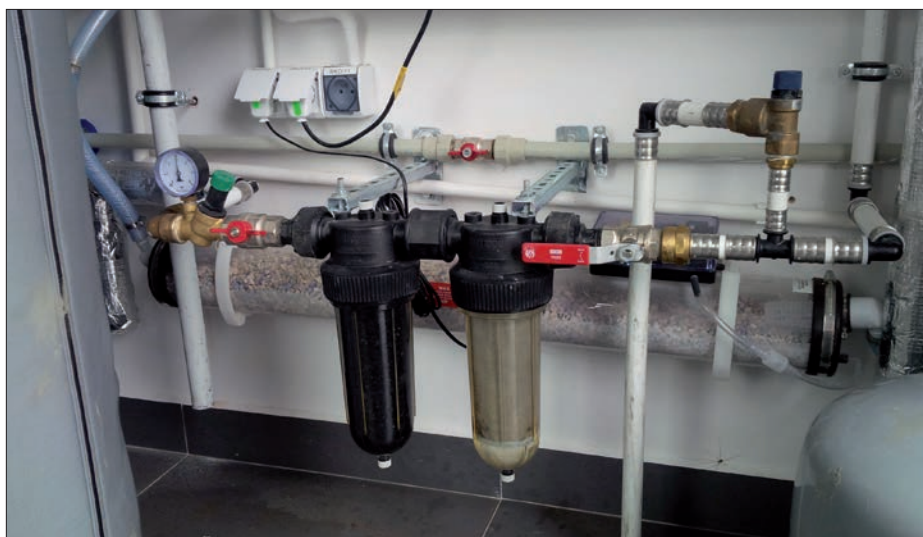
Fot. 5. Instalacja wody deszczowej wraz z centralą deszczową, filtrami narutowymi, zaworami odcinającymi, filtrem antyskażeniowym oraz manometrem (źródło własne)
