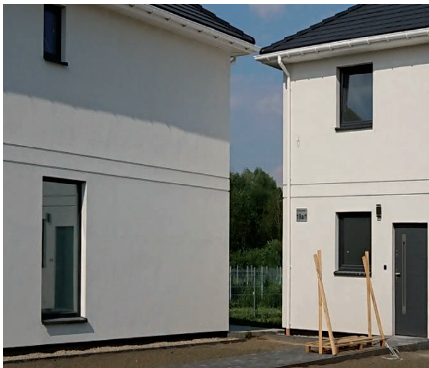
Fot. 5. Budynki „jednorodzinne” na jednej działce, odległość między okapami rzędu kilkudziesięciu centymetrów
