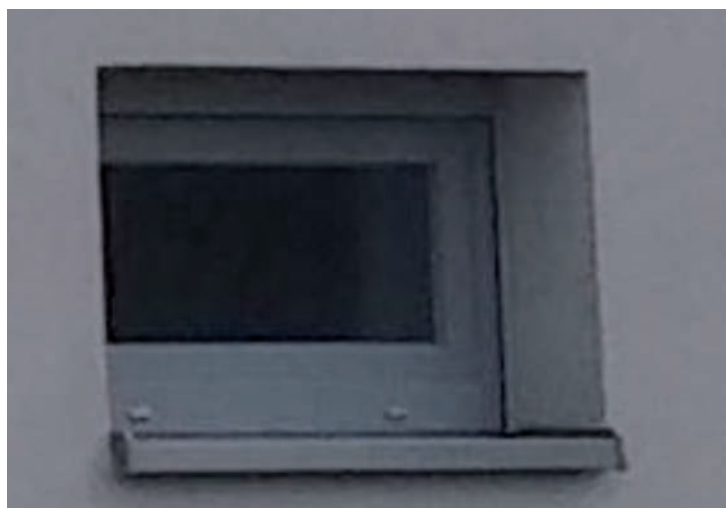
Fot. 2. Duża szerokość ościeży okiennych, wynikająca ze zwiększenia grubości izolacji termicznej, wpływa na zacienie pomieszczeń w budynku, pogarszając tym samym bilans energetyczny budynku [6]
