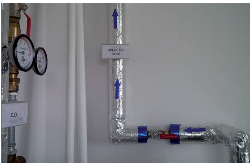
Fot. 5. Instalacja wody deszczowej wraz z centralą deszczową, filtrami narutowymi, zaworami odcinającymi, filtrem antyskażeniowym oraz manometrem (źródło własne)
