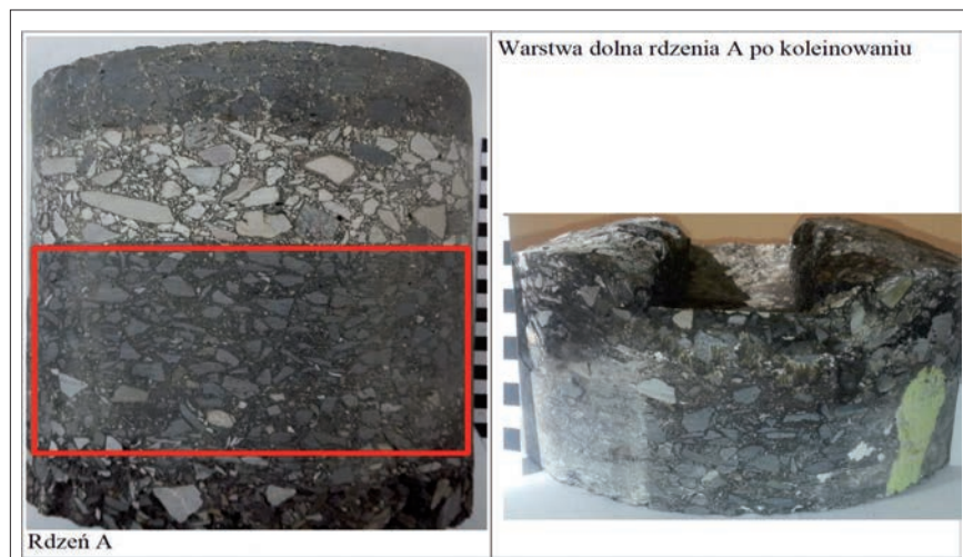
Rys. 4. Pobrane rdzenie z nawierzchni z wynikiem badania koleinowania dolnej warstwy
