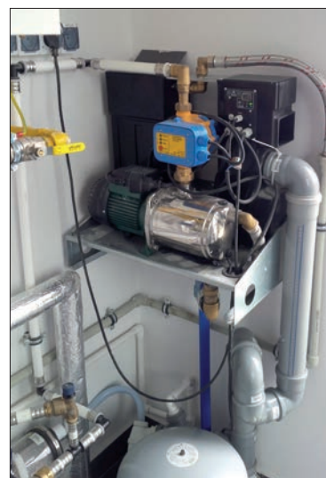
Fot. 5. Instalacja wody deszczowej wraz z centralą deszczową, filtrami narutowymi, zaworami odcinającymi, filtrem antyskażeniowym oraz manometrem (źródło własne)
