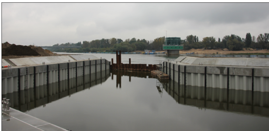
Fot. 1. Poszerzony wlot do zatoki, na razie jeszcze odgradzony od rzeki ściankami szczelnymi
