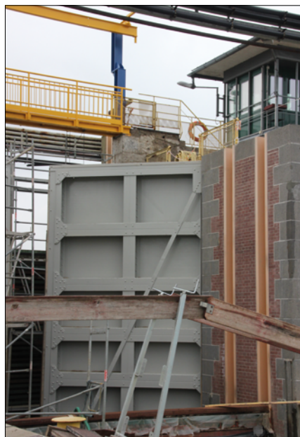
Fot. 2. Ściana bramy wałowej po renowacji i wrota. Wszystko jeszcze w towarzystwie rusztowań
