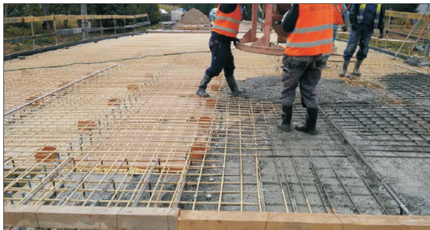
Fot. 2. Zbrojenie płyty mostu w Białowieży [3]
