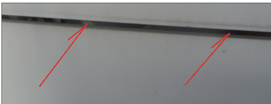
Fot. 7. Elewacja wentylowana. Zapchana folią paroprzepuszczalną przestrzeń wentylowana
