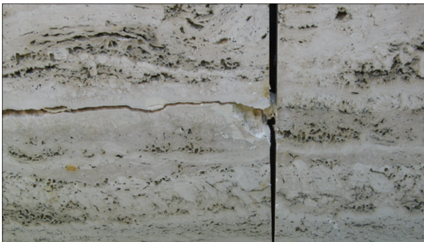
Fot. 1. Uszkodzona okładzina elewacji wentylowanej, pęknięcie przy kotwie kamieniarskiej
