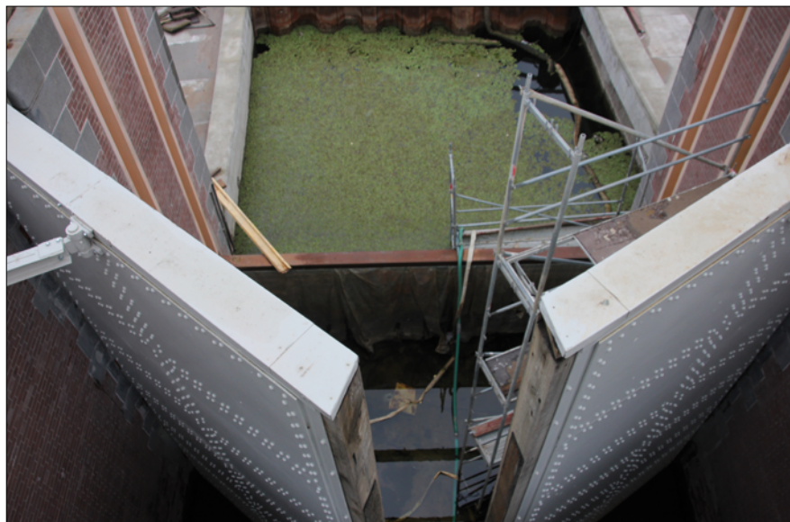
Fot. 4. Wrota bramy wałowej
