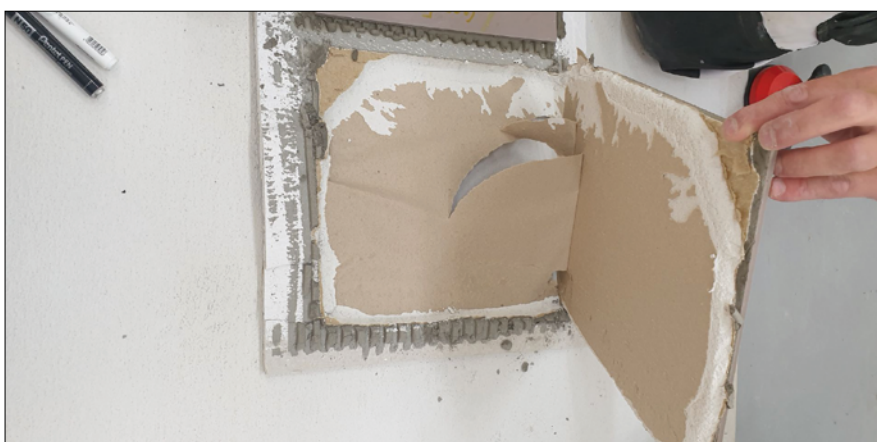
Fot. 4. Test zrywania płytki po 1,5 godzinie: nastąpiło oderwanie kleju Atlas Geoflex Express wraz z podłożem (w tym przypadku płyta g-k) (fot. Atlas)
