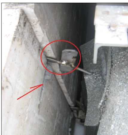
Fot. 3. Widoczne uszkodzenie kotwy kamieniarskiej, niepoprawnie wykonane gniazdo do kotwy kamieniarskiej
