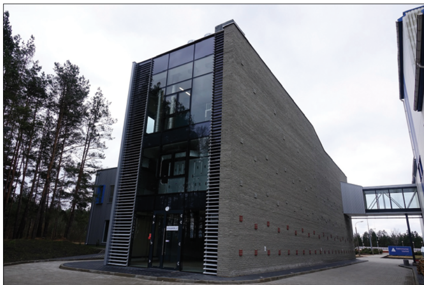
Budynek trzeciego pulsatora w SUW Pietrasze
