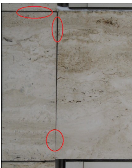
Fot. 2. Osuwająca się okładzina, widoczne zmiany grubości szczelin wentylacyjnych między okładzinami
