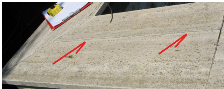
Fot. 4. Uszkodzona okładzina attyki
