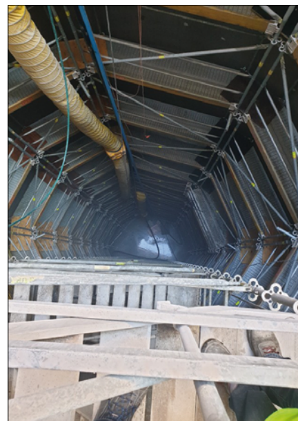
Fot. 1. Żelbetowa tuba basenu głębokiego nurkowania Deepspot schodząca do głębokości ponad 45 m podczas prowadzenia prac izolacyjnych elastyczną zaprawą Atlas Woder Duo i okładzinowym klejem Atlas Plus (fot. Atlas)
