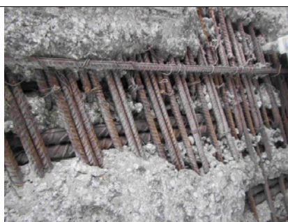
Rys. 5. Identyfikacja wad w betonie, pomiar na dolnej powierzchni płyty i fotografia po odkuciu wierzchniej warstwy betonu, Proceq Pundit
