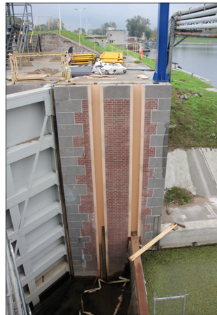
Fot. 3. Naprawiona ściana bramy wałowej
