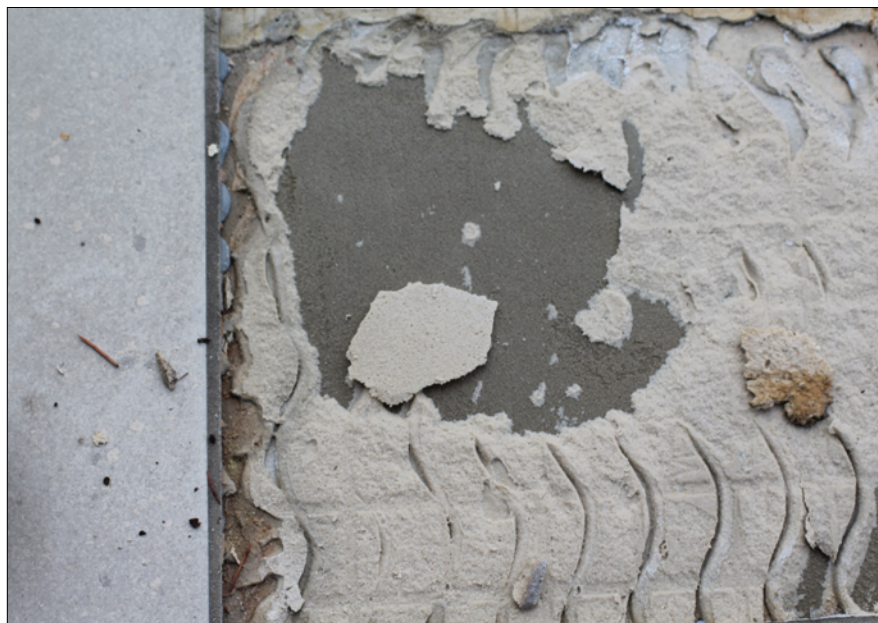
Fot. 2. Skutek klejenia płytek w temperaturach znacznie przekraczających dopuszczalne (fot. Atlas)
