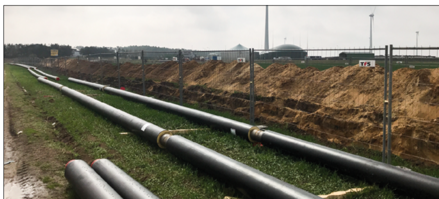
Fot. 3. Montaż sieci magistralnej 2 x Dz 219,1 x 4,5/315 mm w technologii Logstor
