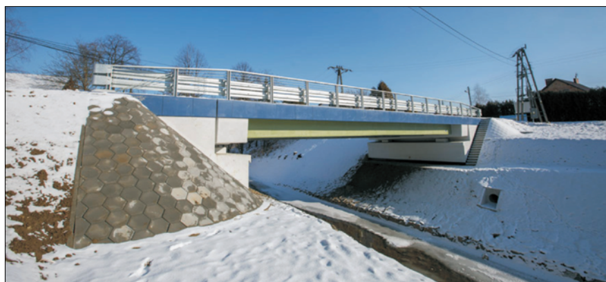
Fot. 3. Most w Białowieży, pierwszy polski most kompozytowy wykonany z materiałów FRP [2]
