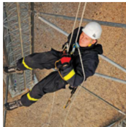
Fot. 4. Pracownik stosujący techniki alpinistyczne [7]
