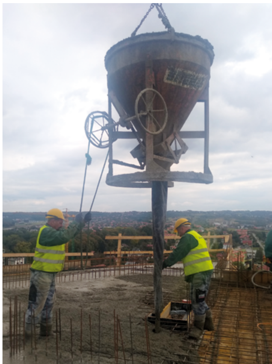
Fot. 2. Wyladunek mieszanki betonowej z kosza wyposażonego w rękaw elastyczny
