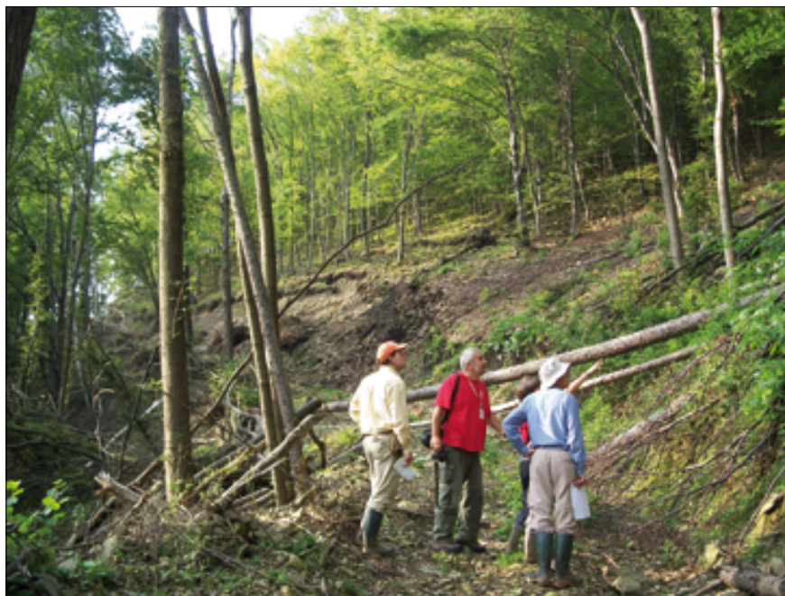
Fot. 2. Skarpa główna osuwiska 13.09.2010 r.
