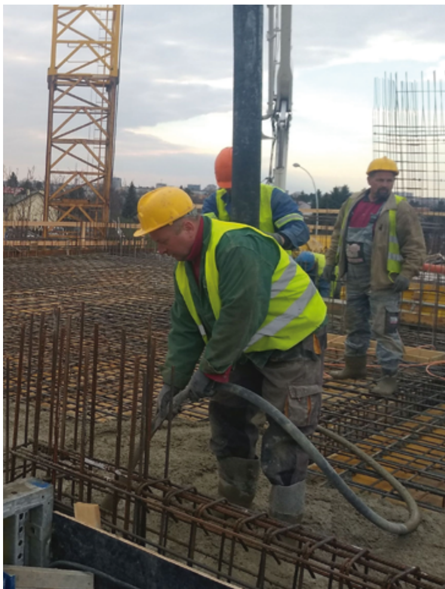
Fot. 4. Wibrowanie mieszanki betonowej za pomocą wibratora buławowego
