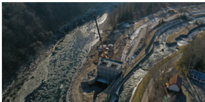
Fot. 3. Widok na MEW Zabrzeż na etapie montażu turbin
