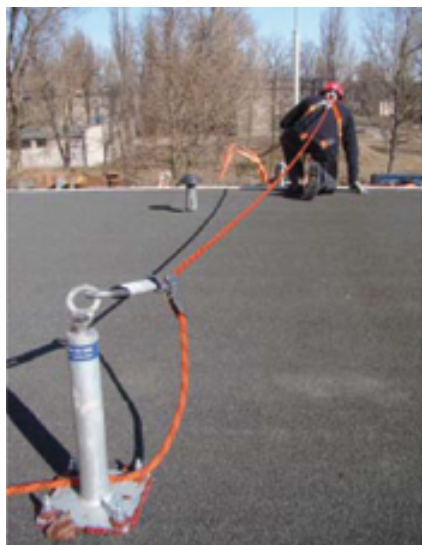
Fot. 2. Pracownik wykorzystujący szelki bezpieczeństwa z linką, hamulcem i kotwą [5]
