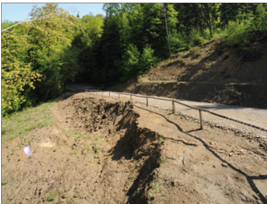
Fot. 4. Najbardziej aktywna część osuwiska Piaski-Drużków
