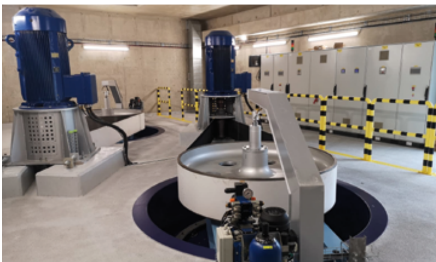
Fot. 2. Hala maszyn MEW Zabrzeż
