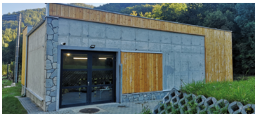
Fot. 1. Budynek MEW Zabrzeż
