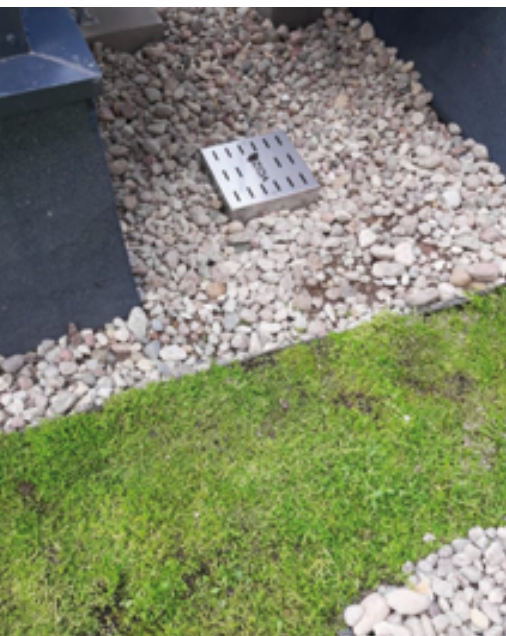
Fot. 3. Prawidłowo wykonane zabezpieczenie wpustu (źródło: www.zida.com.pl )
