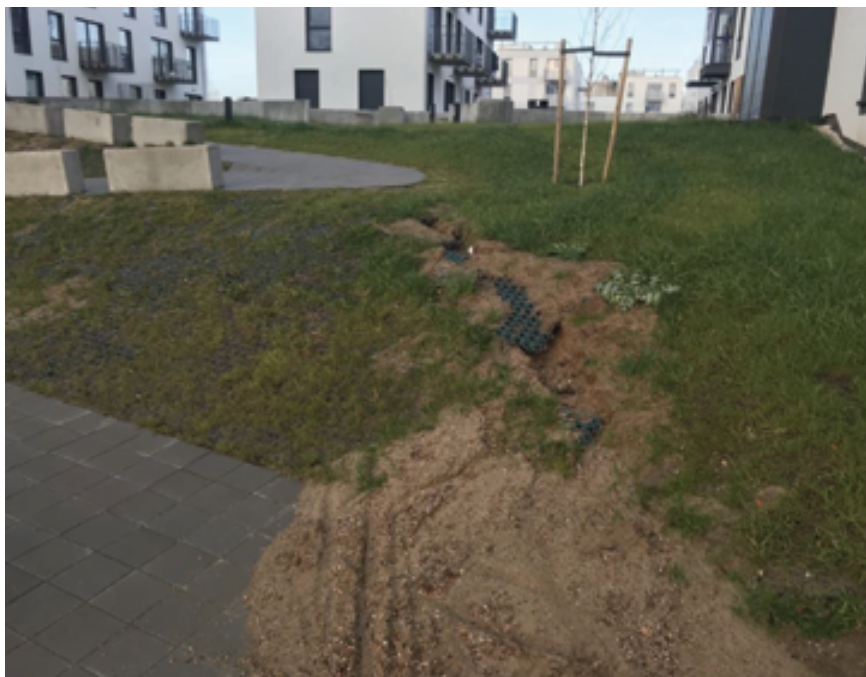
Fot. 2. Skutek zastosowania ziemi z wykopu na dachu garażu podziemnego (zdjęcie autora)
