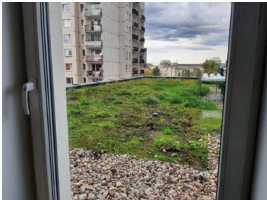
Fot. 1. Bioróżnorodny dach zielony w uprawie mieszanej ekstensywnej z wprowadzonymi gatunkami lokalnymi (źródło: www.zida.com.pl )
