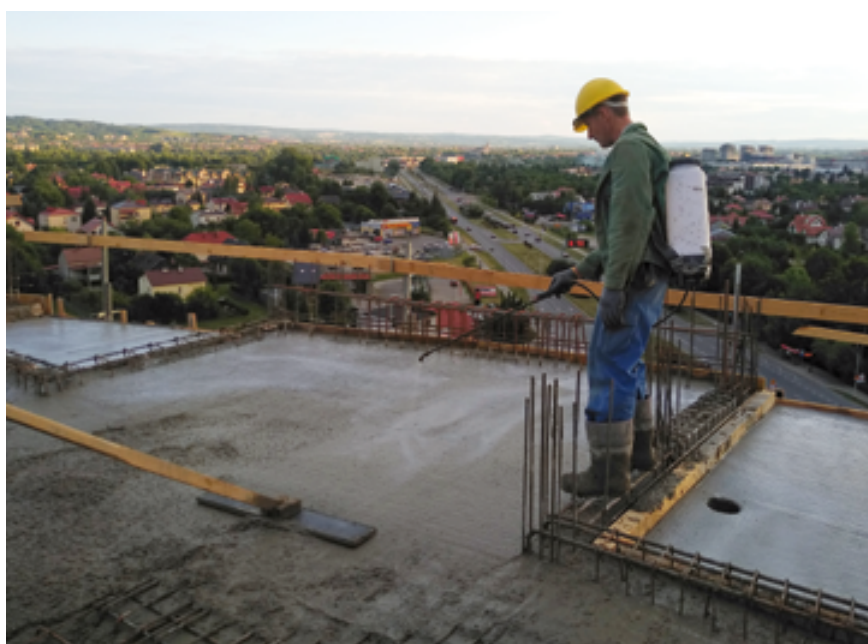
Fot. 3. Nakładanie powłoki zabezpieczającej przed parowaniem wody z betonu
