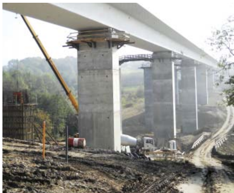
Wiadukt WS5 w km 3+157 (odc. II/1) końcowy etap realizacji ustrojów nośnych obu jezdni, w tle wiadukt WD1 w węźle "Krakowska"
