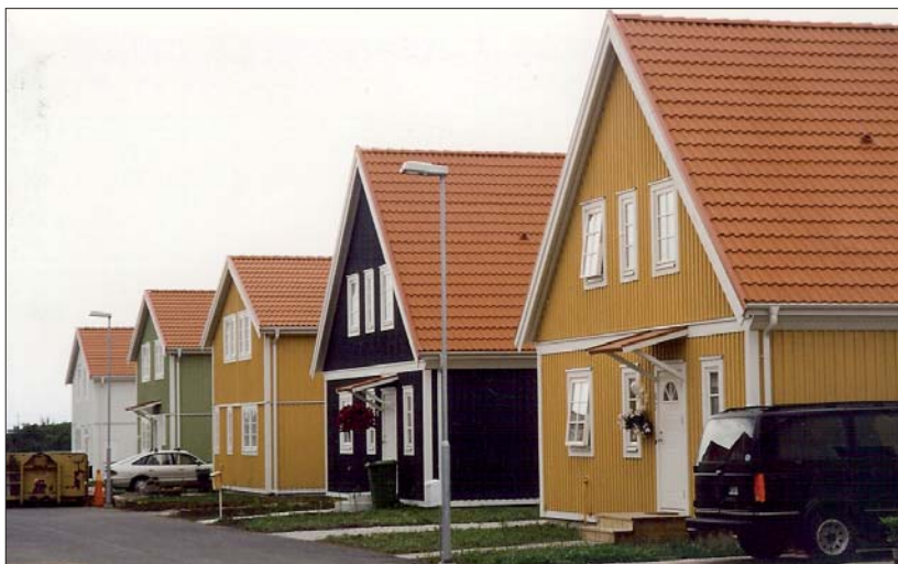
Fot. 1 | Elewacje drewniane na domkach jednorodzinnych
