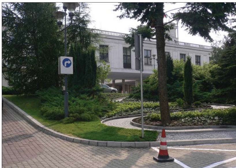
Fot. 2 | Ciąg komunikacyjny na terenie Sejmu RP w Warszawie, dostosowany (po likwidacji stopni, zmniejszeniu nachylenia i wydłużeniu ciągu) dla osób poruszających się na wózkach inwalidzkich
