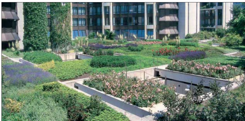
Fot. 3 | Dach z zazielenieniem intensywnym, fot. ZinCo
