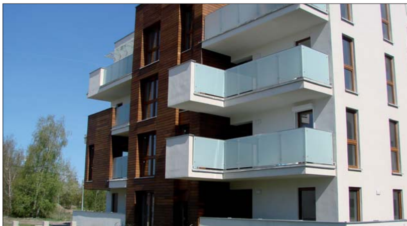
Fot. 4 | Widok ogólny budynku
