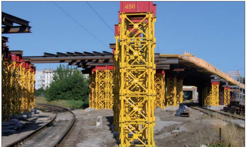
Fot. 2 | Droga Łąkowa w Grudziądzu zaprojektowana i nadzorowana w budowie przez płk. Głapiaka
