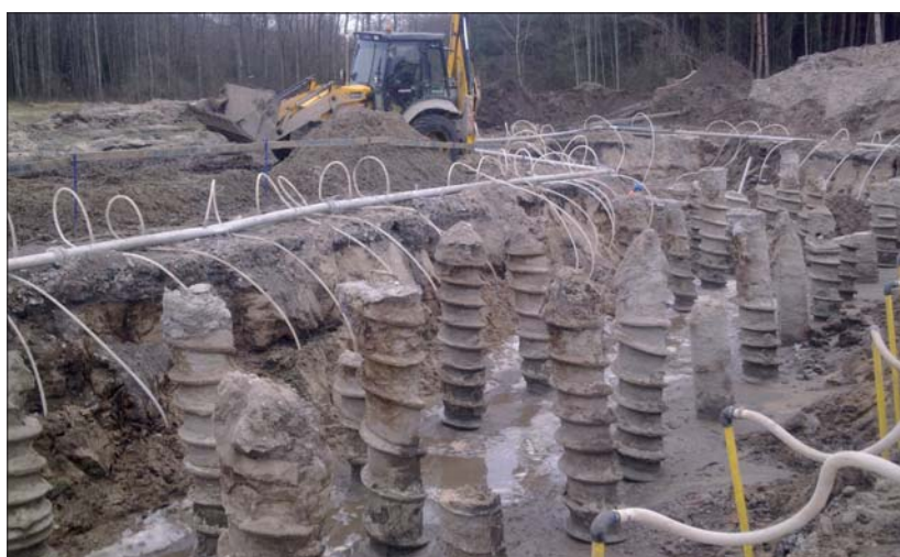
Pale SCREWSOL® 330/500 na obiekcie PZM 39, autostrada A2, odc. B
